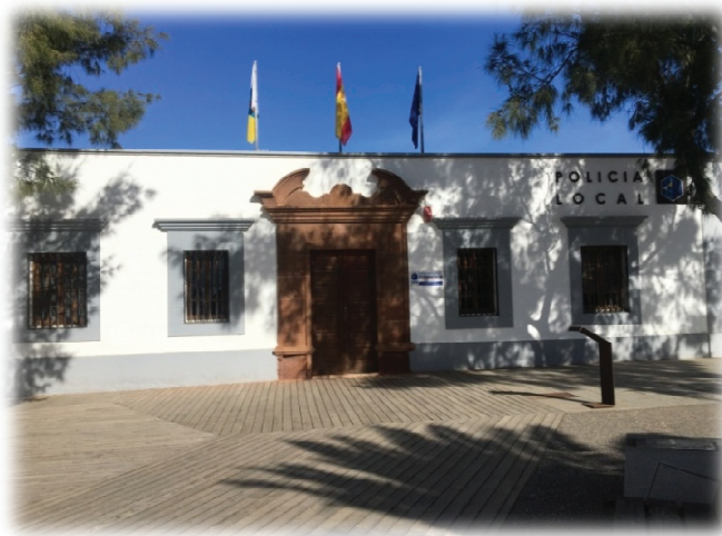
Ilustración 1. Fachada principal. Fuente: Elaboración propia
