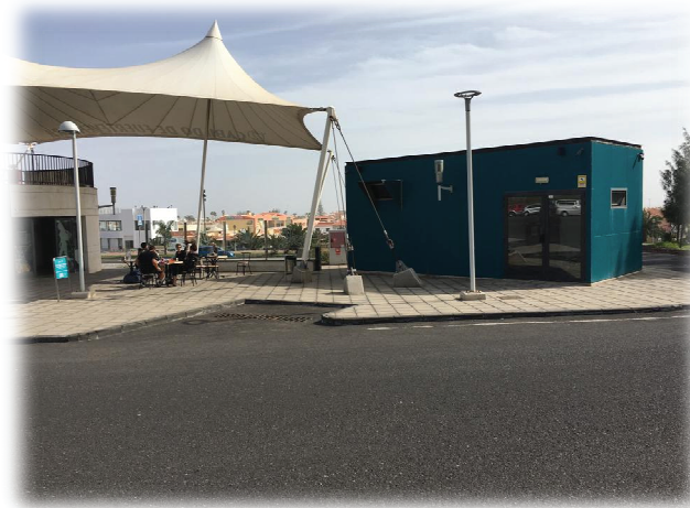
Ilustración 2. Fachada principal. Fuente: Elaboración propia
