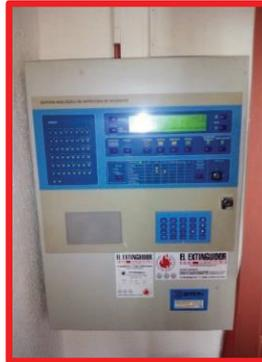
*Imagen 20. Central de control sistema analógico detección de incendios*
