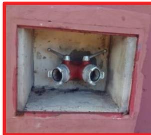
*Imagen 19. Toma exterior en fachada de columna seca*
