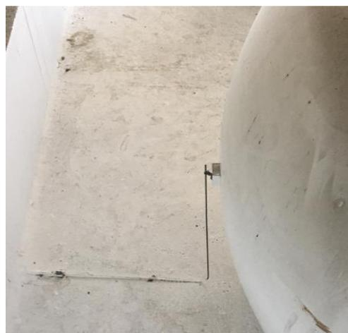
Ilustración 9 Conexión a tierra depósitos.
