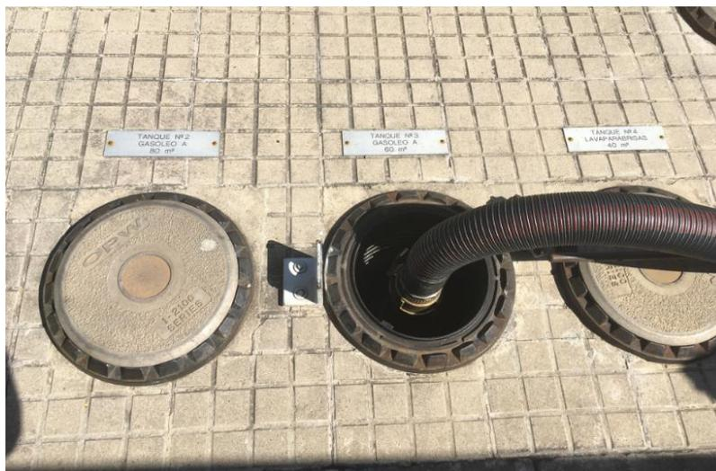
Ilustración 14 Boca de llenado durante descarga de gasoil. Elaboración propia.
