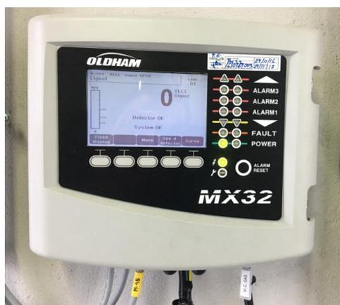
Ilustración 58 Central detección de gases.
