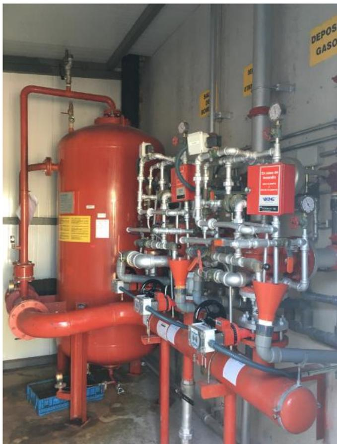
Ilustración 59 Puestos de control y depósito de espumógeno del sistema de extinción.
