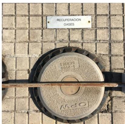
Ilustración 20 Conexión sistema recuperación de gases. Elaboración propia.
