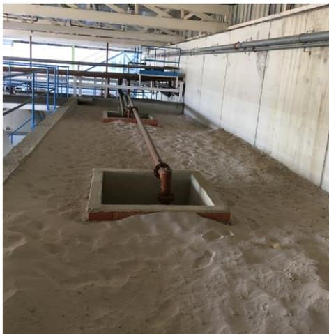
Ilustración 13 Material inerte en depósito enterrado de gasolina. Elaboración propia.
