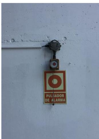
Ilustración 55 Pulsador activación de alarma pasillo entre depósitos. Elaboración propia.
