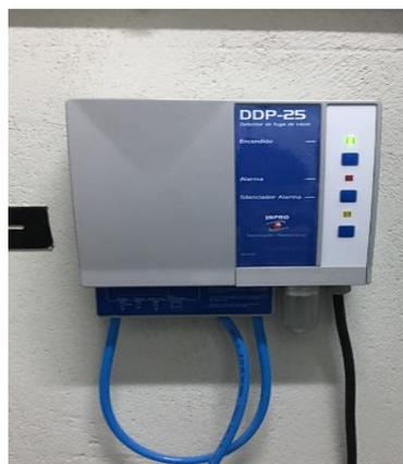
Ilustración 17 Detector fugas líquido lavaparabrisas. Elaboración propia.
