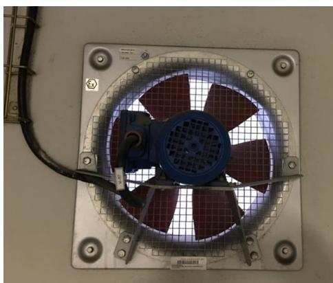
Ilustración 63 Ventilación forzada ATEX sala bombas. Elaboración propia.
