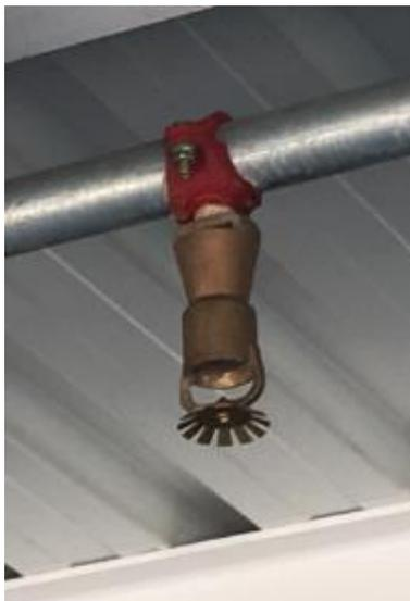
Ilustración 60 Rociador sistema extinción. Elaboración propia
