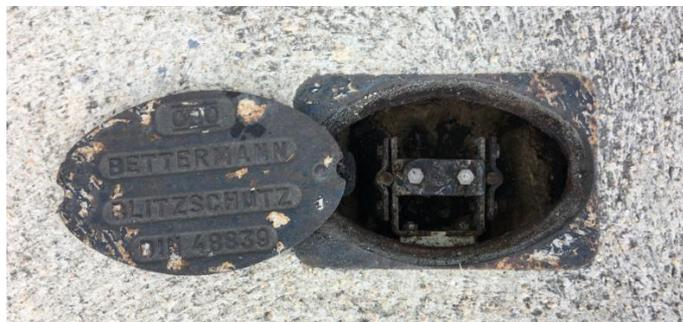
Ilustración 23 Derivadores instalación pararrayos. Elaboración propia.
