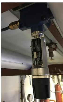
Ilustración 57 Detector gases sala bombas.
