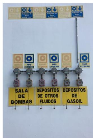
Ilustración 56 Pulsadores activación e inhibición de disparo. Elaboración propia.
