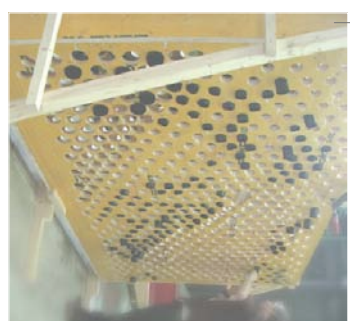
Detalle del enrejado y soporte de protección del muro exterior de hormigón armado.
