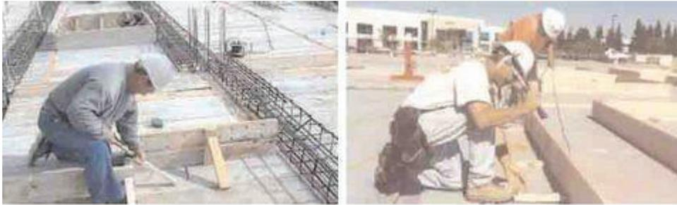
Figura 48 - Encofrador: posturas forzadas de piernas.
