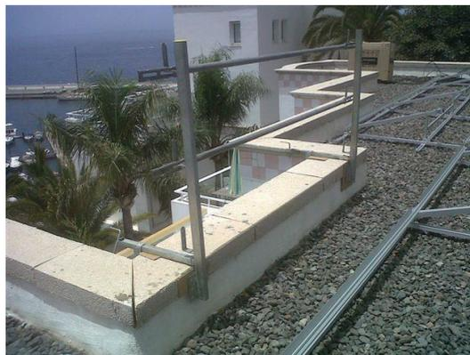
**Fig. 3: Montaje Barandilla cubierta con pretil**
