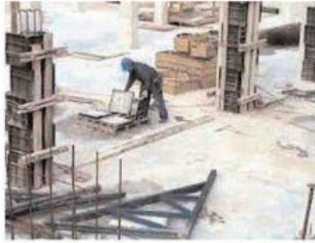
Figura 45 - Encofrador: recoger material a ras de suelo.
