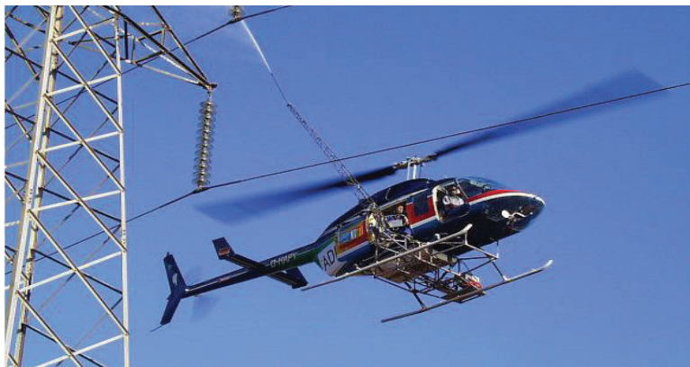
Imagen 8. Inspección aérea con helicóptero. [14]
