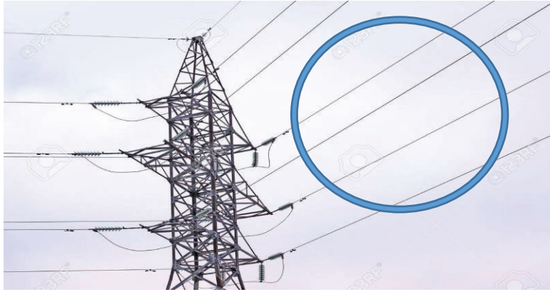
Imagen 4. Conductores de una línea eléctrica. [9]
