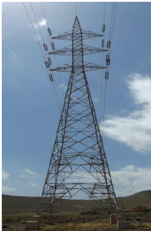
Imagen 6. Apoyo de línea eléctrica de alta tensión. [11]
