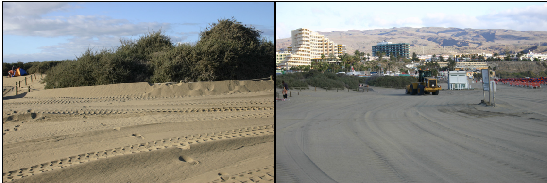
Figura 6.101. Destrucción de geoformas dunares por la acción de maquinaria pesada en las labores de gestión de la playa.
