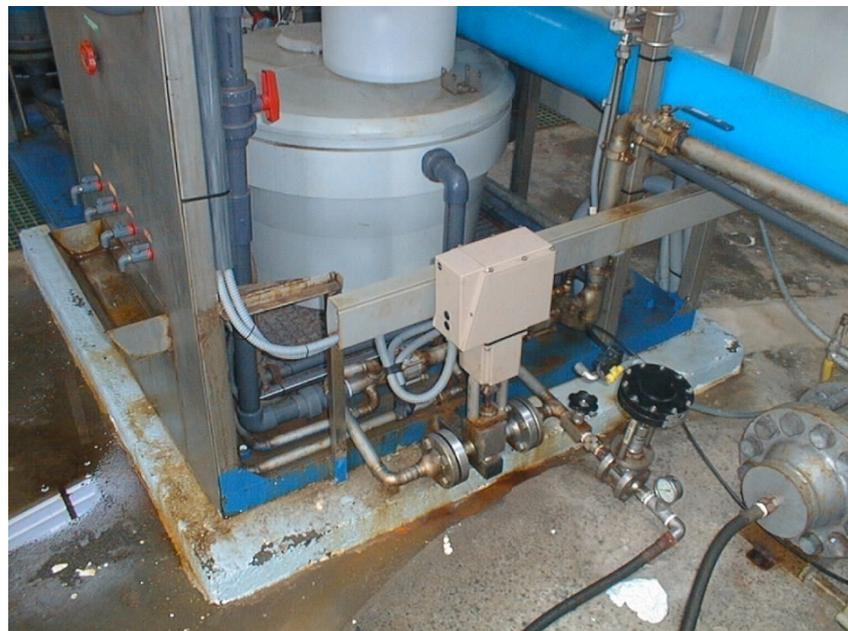
Figura 6-9 Válvula de control motorizada
