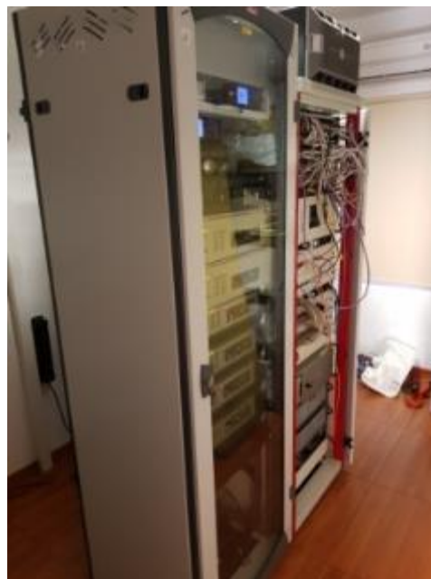
Figura 10: Cuarto Frío Fuente: Elaboración propia
