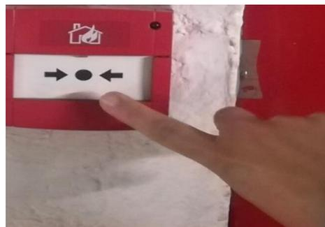
**FIGURA 35. UTILIZACIÓN DEL PULSADOR DE ALARMA.**
