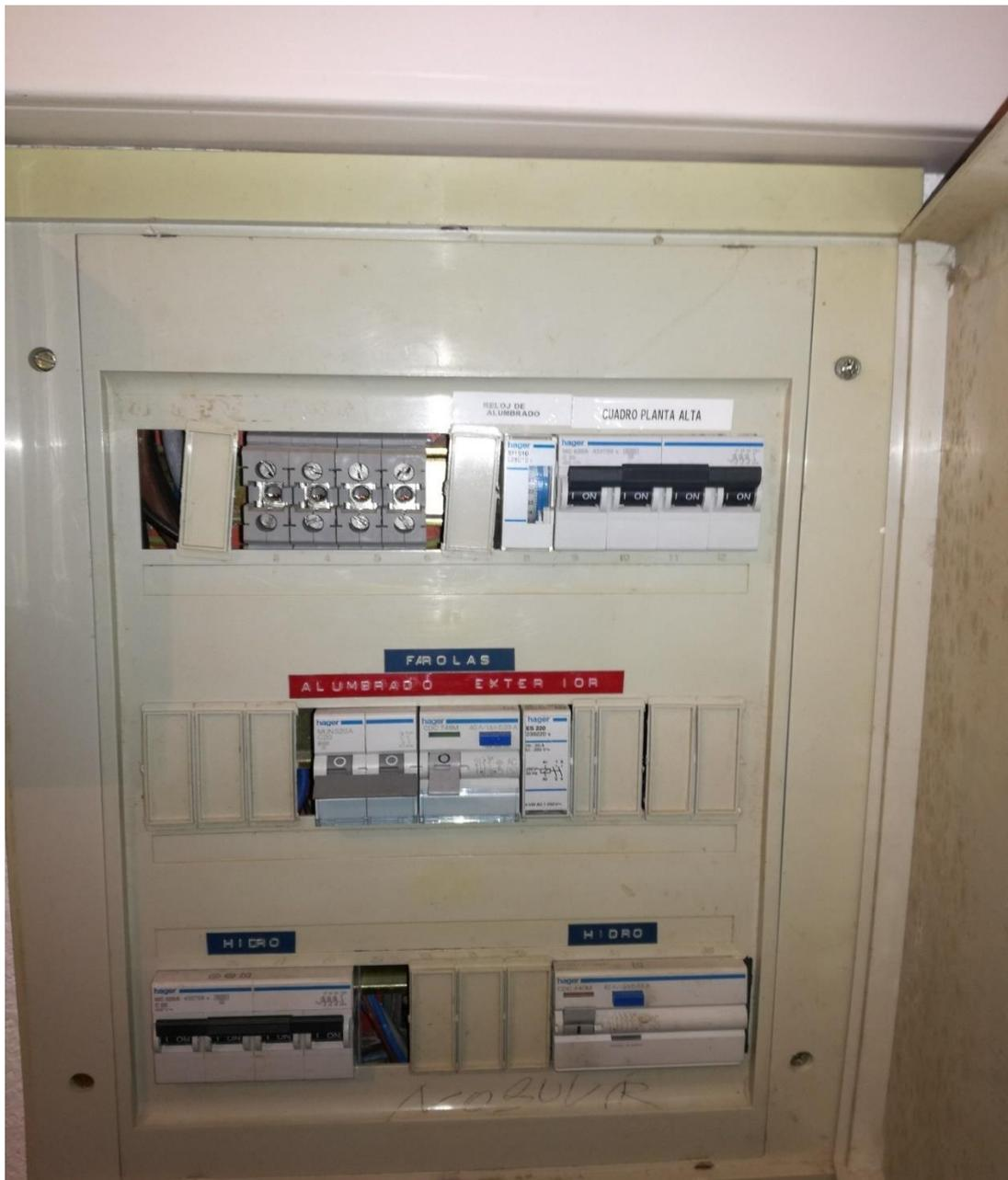
**FIGURA 13. CUADRO DE PALANCAS ALUMBRADO EXTERIOR.**
