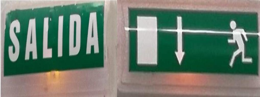
**FIGURA 16. ALUMBRADO DE EMERGENCIA.**
