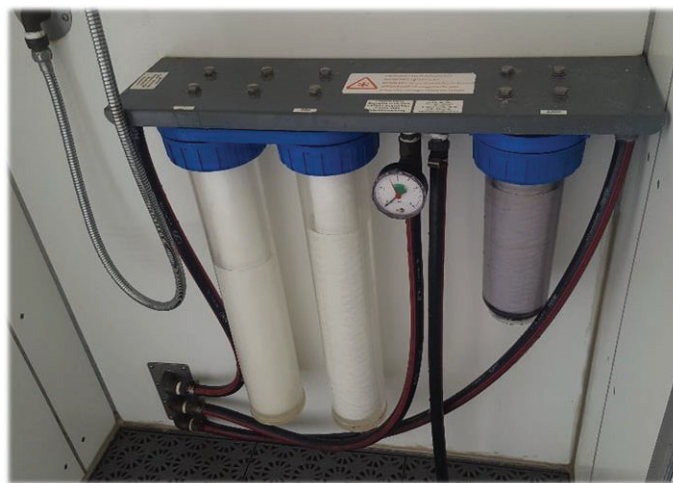
Ilustración 4 - Sistema de filtrado del agua residual
