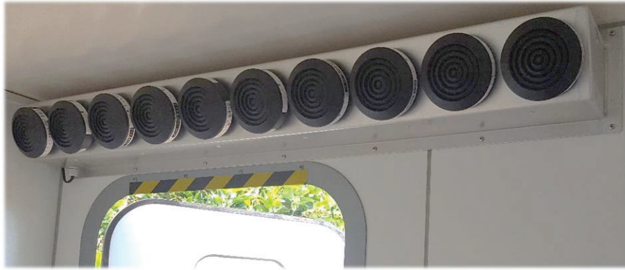
Ilustración 5 - Filtros del sistema de ventilación
