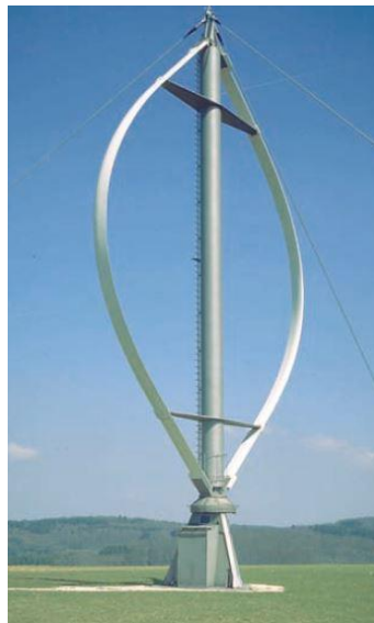
Figura 64. Aerogenerador vertical Darrieus [23]
