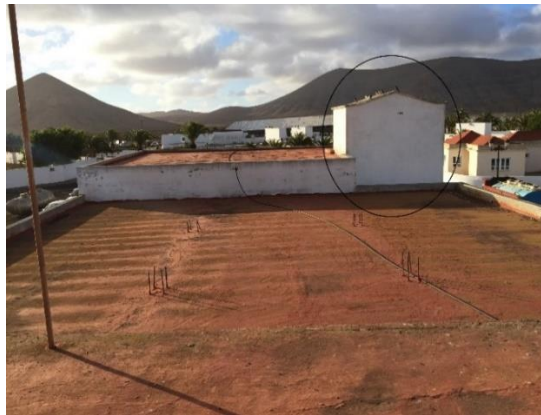
Figura 87. Ubicación del aerogenerador
