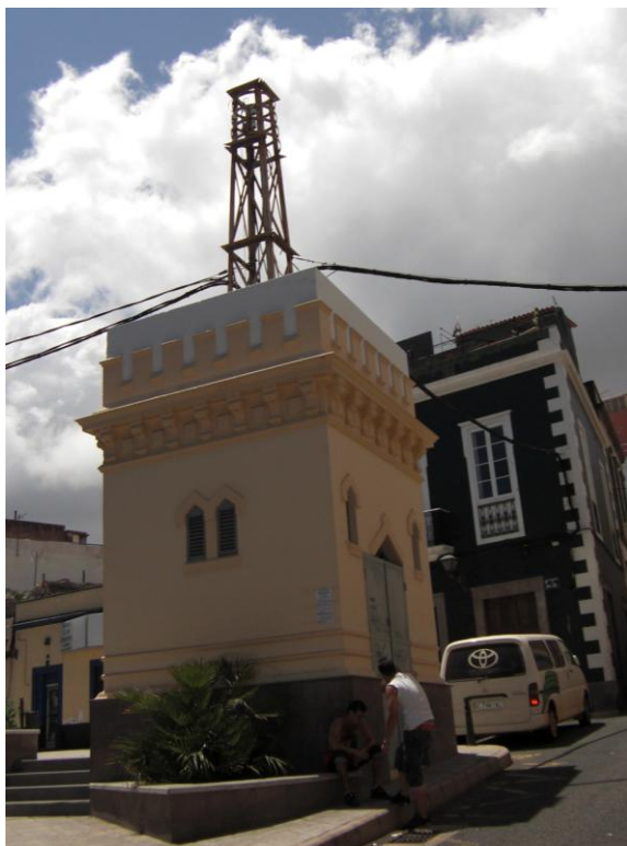
Torreón de la luz diseñado por el arquitecto Fernando Navarro en el Paseo de San José, 2009. Fuente: la autora.
