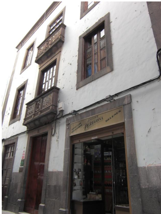
Entrada del Bazar Peregrina en la calle de la Peregrina nº 8, 2009. Fuente: la autora.
