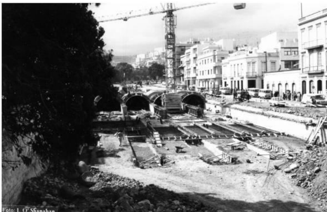
Canalización de las aguas del barranco de Guinguada, 1970. Fuente: Memoria digital de Canarias, Archivo Fotográfico Jaime O'Shanahan, Biblioteca General de la ULPGC.
