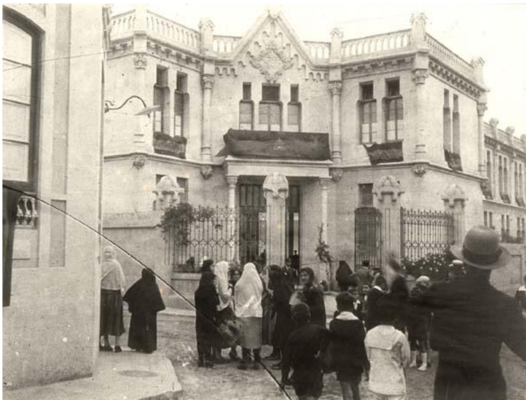
Entrada del antiguo edificio del Colegio de los Jesuitas en Juan E. Doreste, nº 1, 1920-25. Fuente: fondo fotográfico FEDAC.
