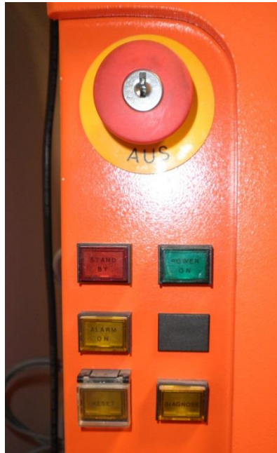
Figura 44. Panel de controles de la máquina.
