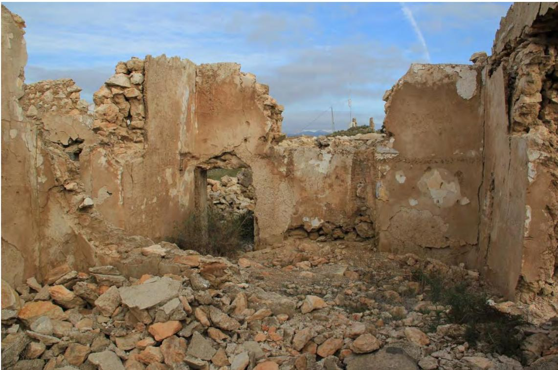
Fotografía 6.21: interior de una vivienda del poblado minero del Embarcadero. Se aprecia el revestimiento (repellado, enfoscado) de las paredes interiores
