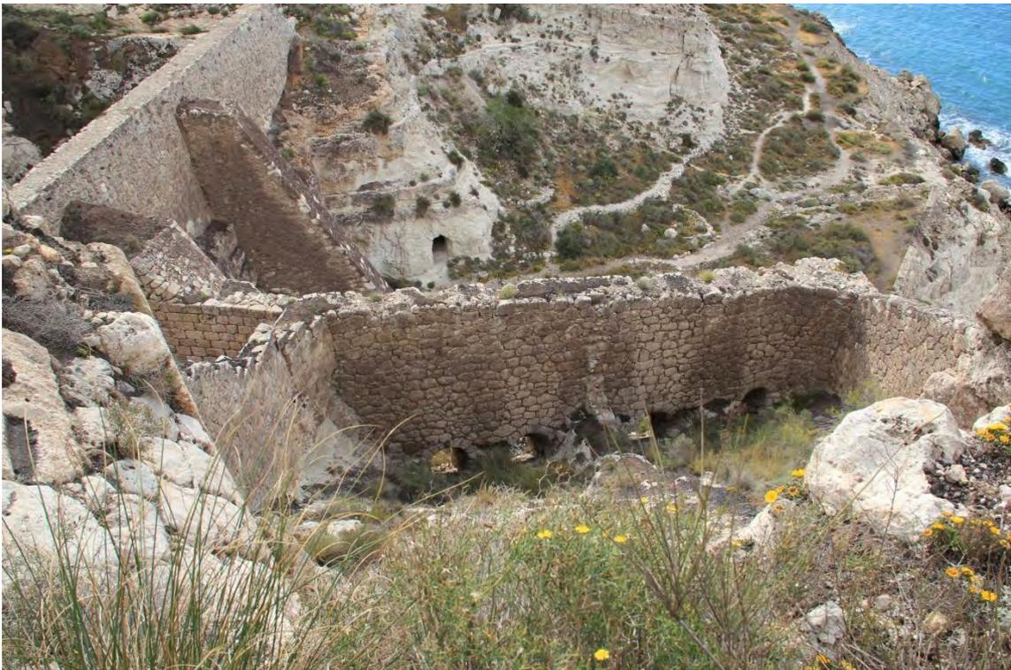
Fotografía 6.39: vista de las aberturas en arcos en la base de las tolvas más externas (más próximas al mar), por donde se sacaba el mineral para el Cargadero
