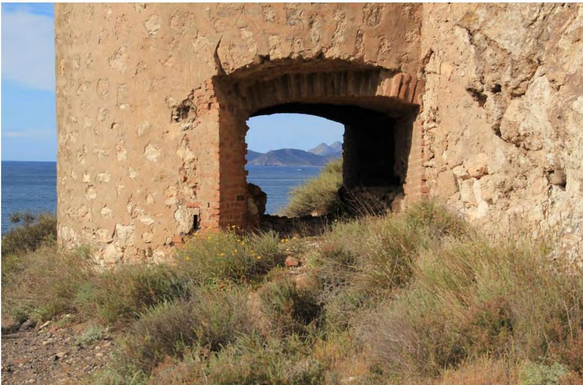
Fotografía 6.9: vanos de la base recubiertos con ladrillos refractarios.
