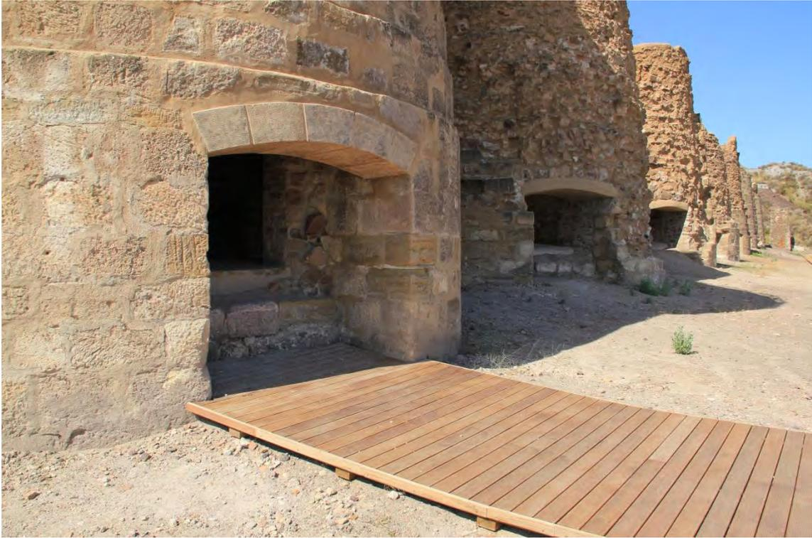
Fotografía 4.51: vanos septentrionales para la aireación de la combustión y la retirada del mineral calcinado
