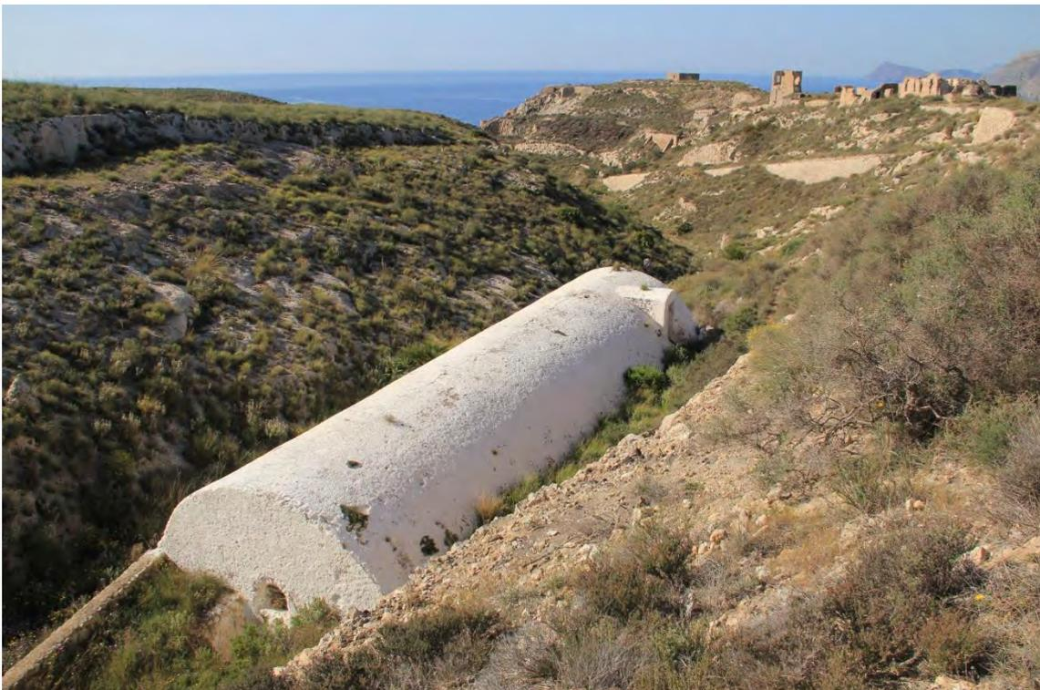
Fotografía 6.4: vista del aljibe. Se observa su bóveda de cañón, su lateral occidental y su parte trasera, con las canalizaciones de captura, el reposadero (balsa de decantación) y la boquera para la recogida de las aguas superficiales desde el reposadero. En la mayoría de los casos, las canalizaciones de captación se encuentran sustituidas por acequias de captación
