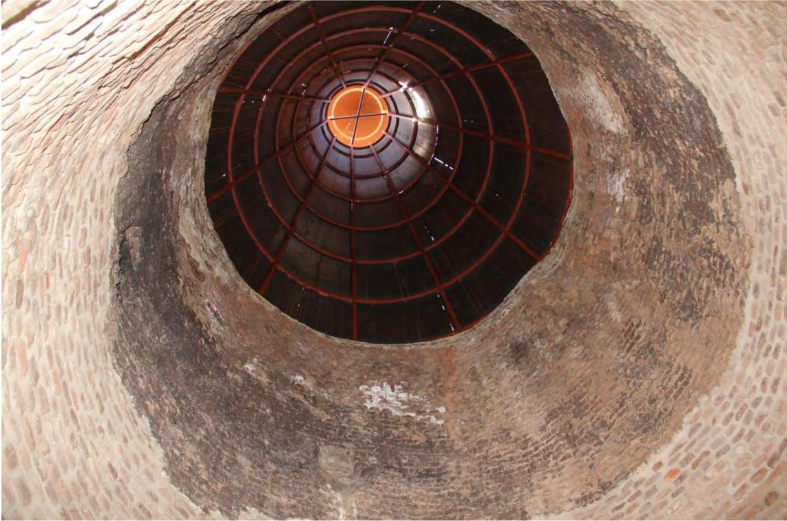
Fotografía 4.53: cierre metálico del tragante para forzar el tiro de la combustión
