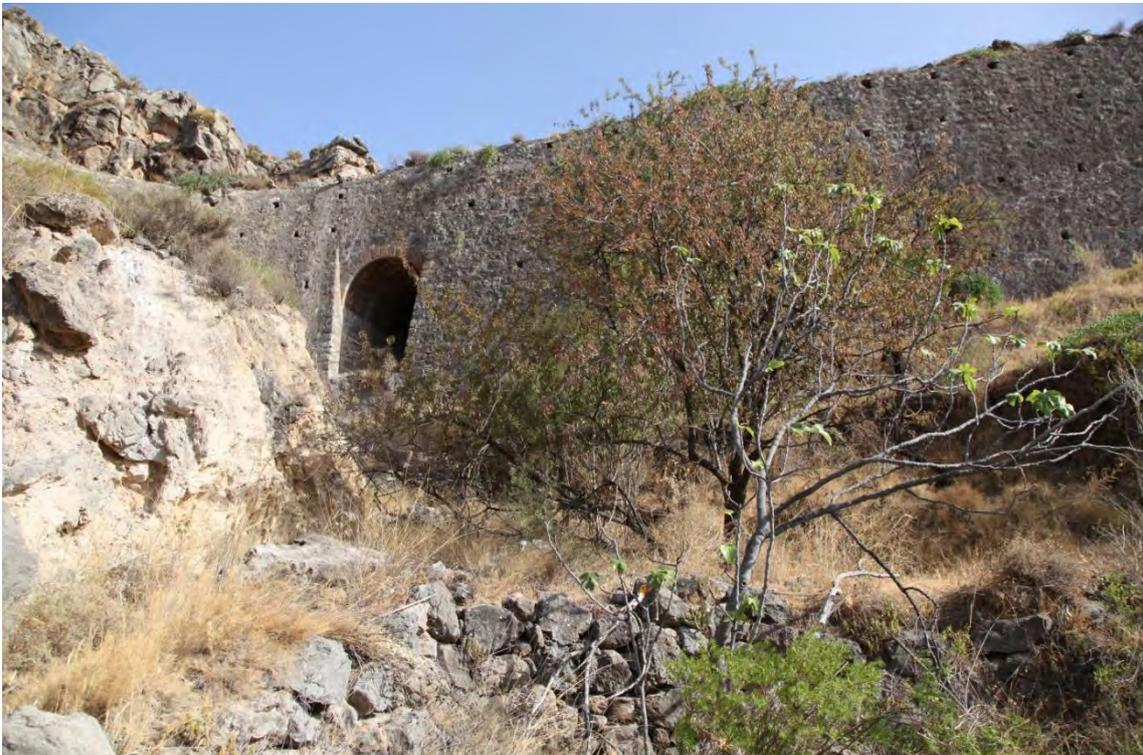
Fotografía 4.27: ojo en el muro de contención de la Estación de Cañadas, que permite el paso del cauce de una torrentera
