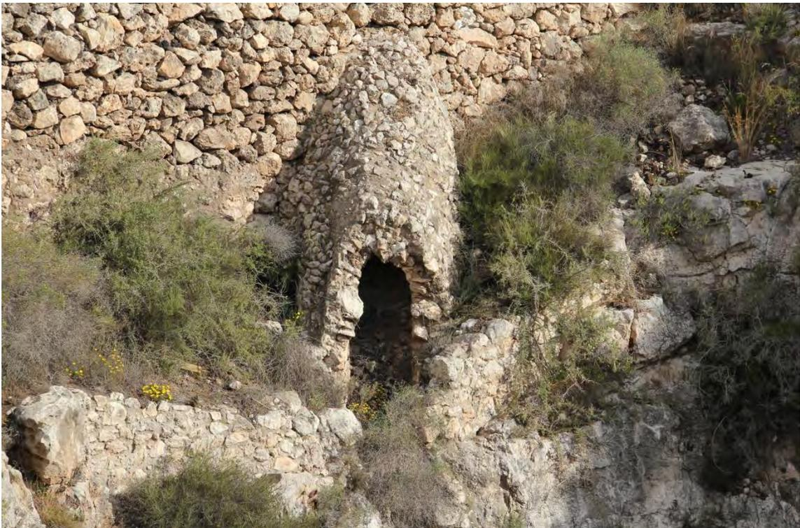
Fotografía 6.43: detalle de una bocamanga que permite la entrada a una de las tolvas más internas (más alejadas del Cargadero)
