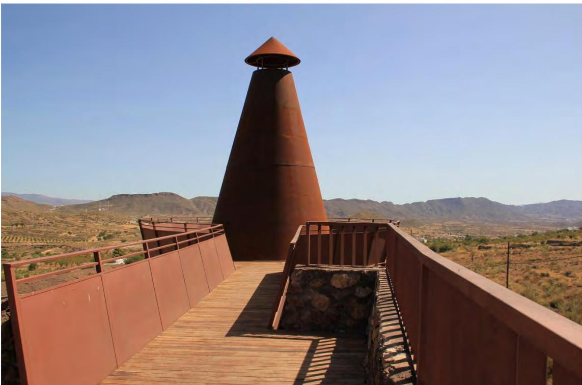
Fotografía 4.54: vista externa del cierre metálico del tragante
