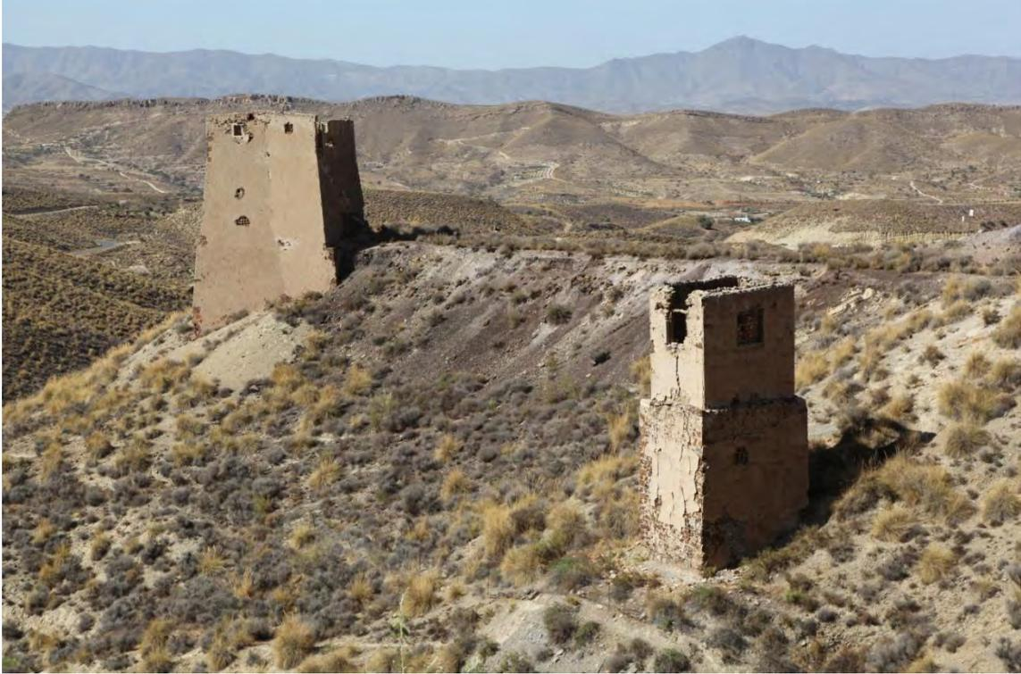
Fotografía 4.33: a la derecha, el respiradero de las galerías del Socavón Colmenillas. A la izquierda, castillete rehabilitado como palomar
