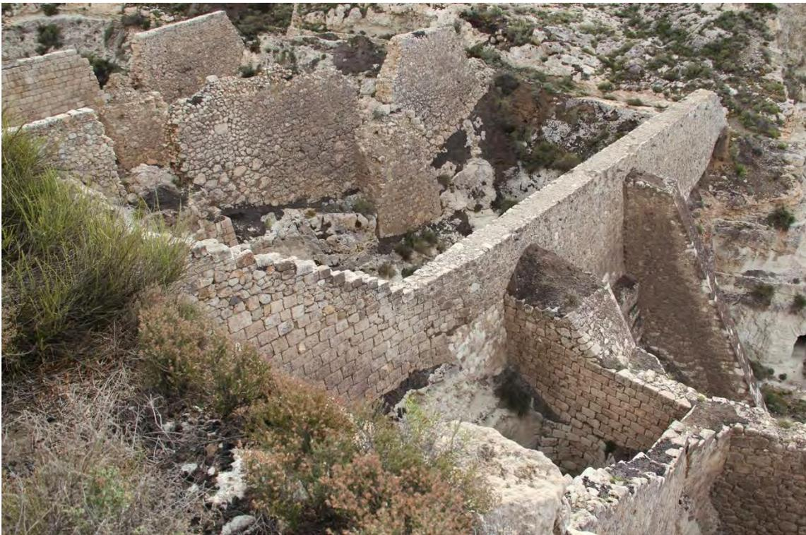
Fotografía 6.37: vista del interior de las tolvas más cercanas a la fachada marítima, reforzadas con contrafuertes
