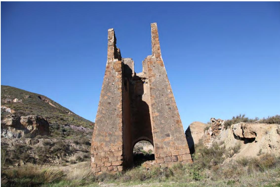
Fotografía 4.20: detalle del vano para la circulación de las vagonetas del castillete representativo entre el cortijo de Don Juan Cuadrado Nieto y la zona de Hoyo Visto
