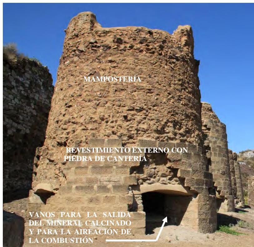
Fotografía 4.45: elementos específicos de la estructura constructiva y de la funcionalidad de los hornos de la batería de calcinación (Lucainena de las Torres)
