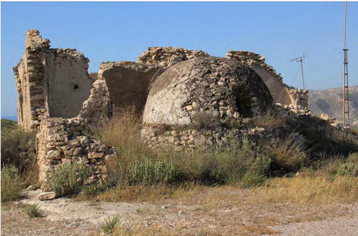
Fotografía 6.19: vista en detalle de la tahona de pan con cúpula, en el pueblo minero. Se observa la solución edificatoria del horno y la ubicación y características geométricas de su boca
