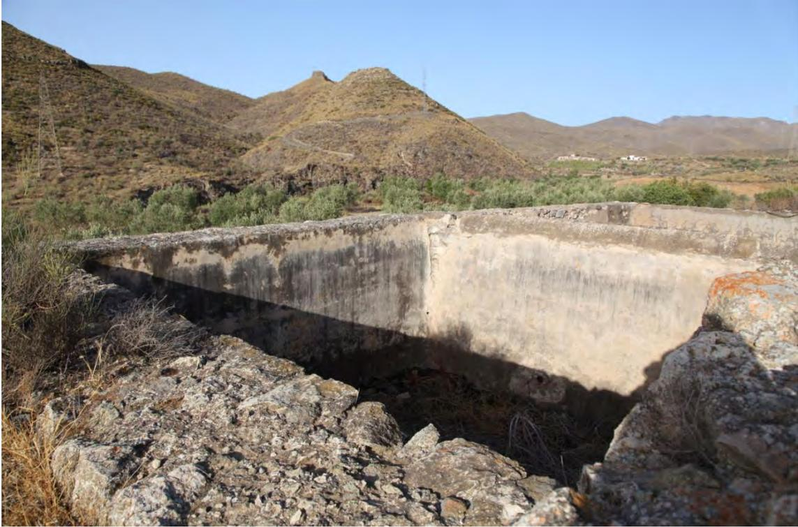
Fotografía 5.21: vista del depósito (estanco) de suministro de agua para las locomotoras de la subestación de Peralejos
