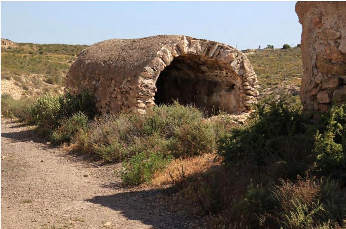
Fotografía 6.17: detalles de la bóveda de cañón de una de las construcciones de almacenamiento, al borde del camino de la divisoria de aguas, desde el sur
