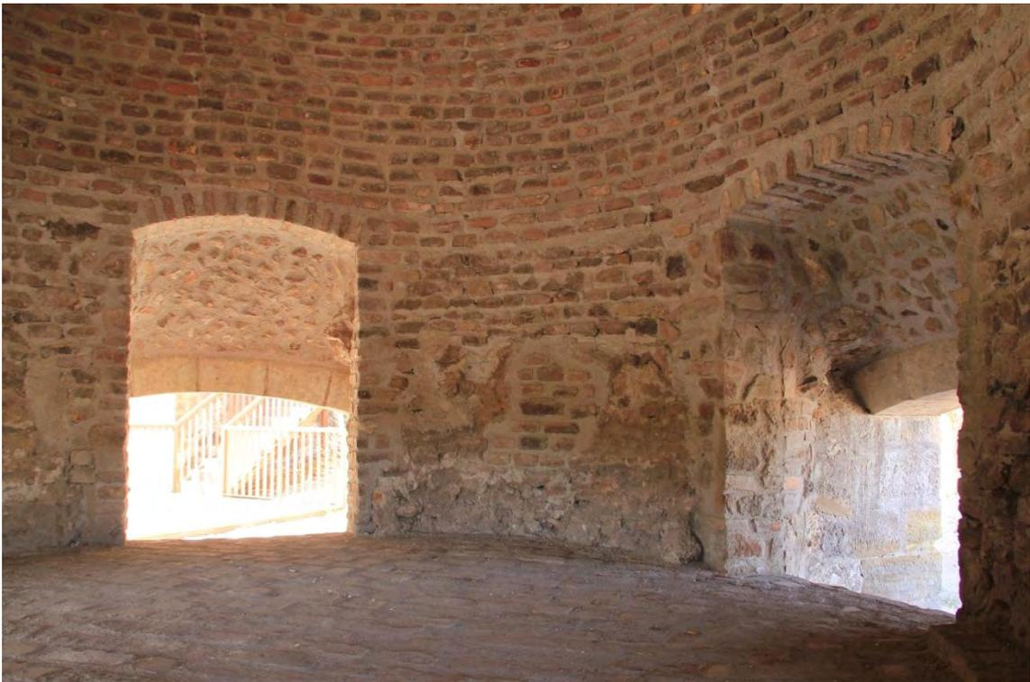
Fotografía 4.52: interior de la cuba del horno, revestida con ladrillos refractarios
