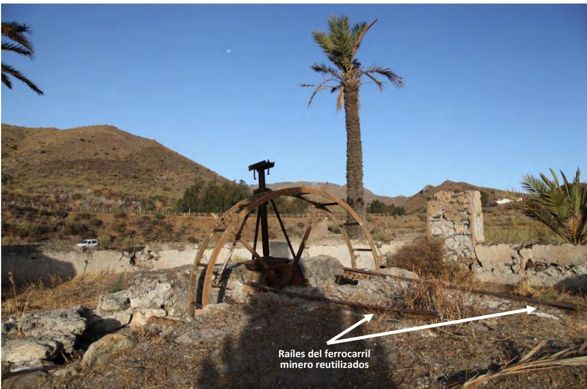
Fotografía 5.2: raíles utilizados como equipamiento de la noria que se localiza en las proximidades del cruce entre las ramblas Alías y Honda, en el marco geográfico de El Saltador
