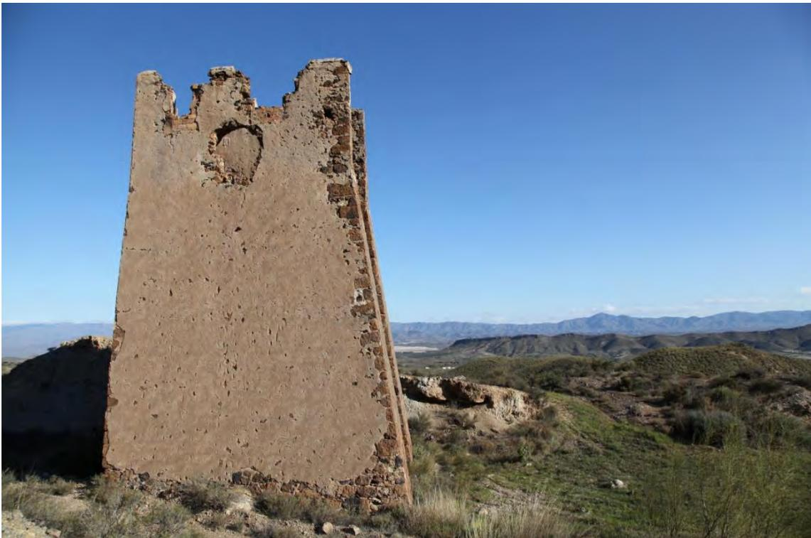
Fotografía 4.19: detalles de los huecos redondeados, en la parte superior, para el alojamiento del rotor del castillete representativo entre el cortijo de Don Juan Cuadrado Nieto y la zona de Hoyo Visto
