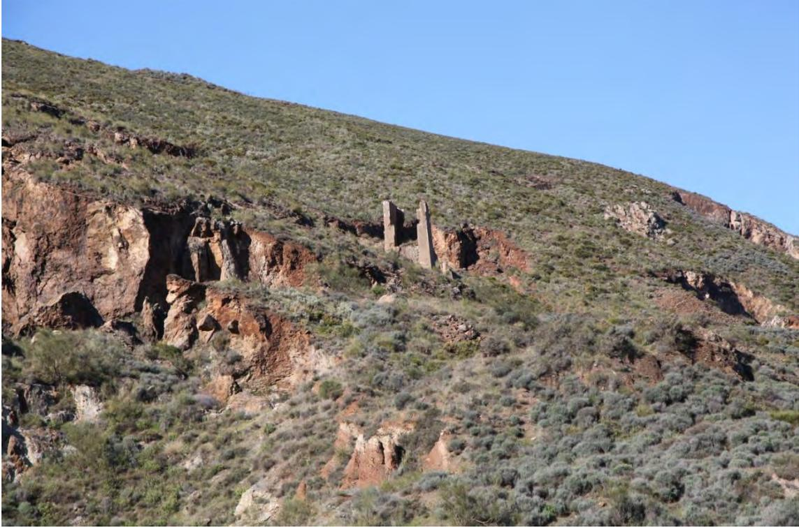
Fotografía 4.16: el anterior castillete, en el centro de un plano medio. A la izquierda, depresión provocada por la aplicación de la técnica del hundimiento en retirada
