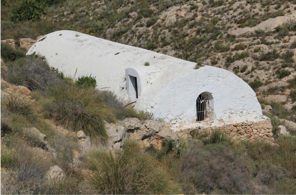
Fotografía 6.5: vista del lateral occidental, del exterior de la bóveda y de la cara frontal del aljibe, con su pared inferior externa a piedra vista y los elementos funcionales propios para la explotación del agua almacenada. En un aljibe estándar, la puerta lateral suele estar ausente y, en su lugar, se construyen un pilar, un lavadero y un abrevadero para el ganado
