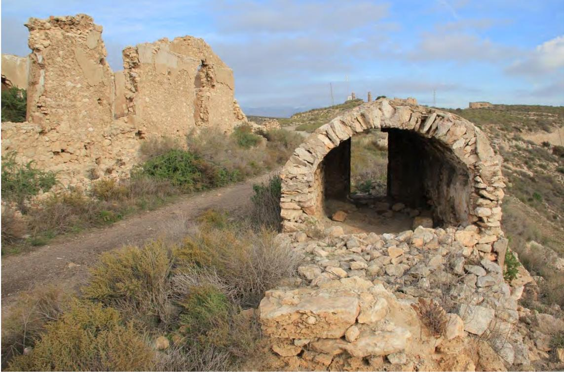
Fotografía 6.16: detalles frontales de una de las construcciones de almacenamiento, con bóveda de cañón (a la derecha y en un primer plano), al borde del camino de la divisoria de aguas, desde el sur
