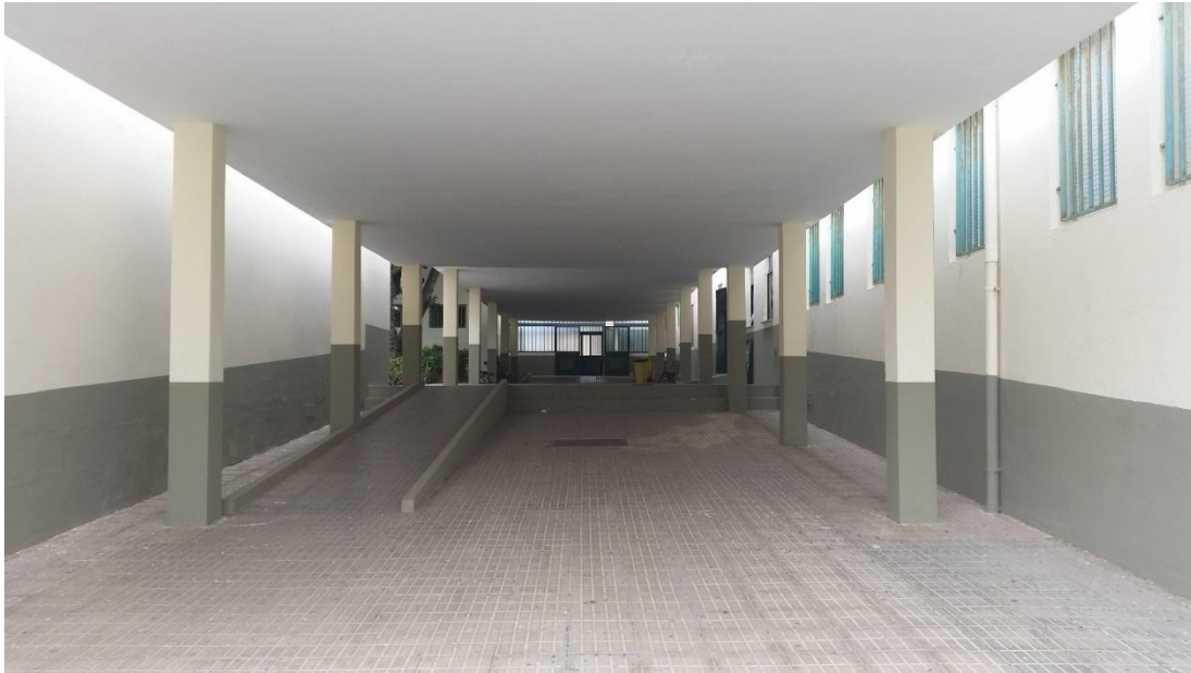
Imagen nº 10. Estructura edificio - pasillo exterior. Fuente: Iván Tejera.
