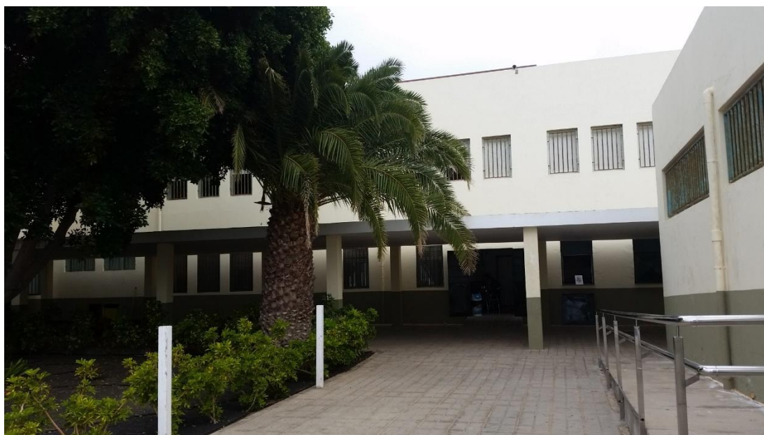
Imagen nº 9. Estructura edificio y fachada. Fuente: Iván Tejera.
