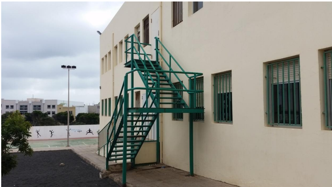
Imagen nº 28. Escaleras externas de emergencia. Fuente: Iván Tejera.
