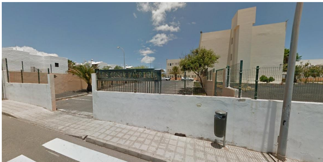
Imagen nº 12 Muro exterior del centro. Fuente: Iván Tejera
