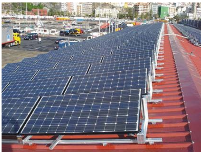
Figura 54. Instalación de módulos fotovoltaicos de manera transversal
