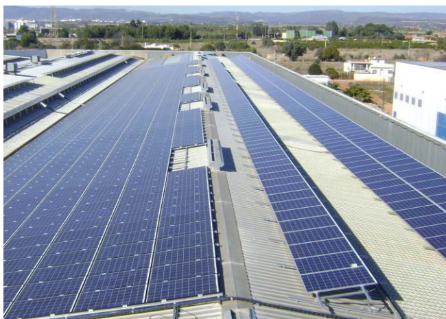
Figura 55. Instalación de módulos fotovoltaicos de manera longitudinal
