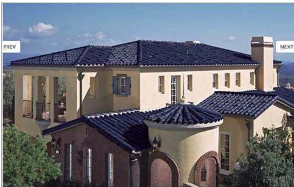
Figura 19. Fotografía de un chalet con tejado compuesto de tejas solares fotovoltaicas
