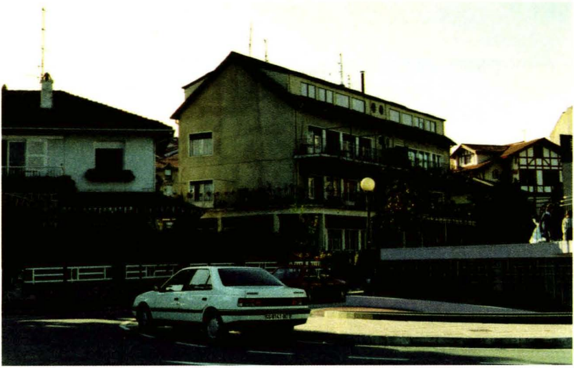
EL EDIFICIO ANTES DE SU REHABILITACIÓN.
