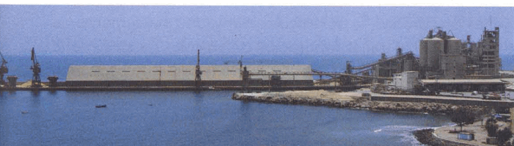
Instalaciones de la empresa de Cementos Especiales de las Islas en el Barranco de Arguineguín.
