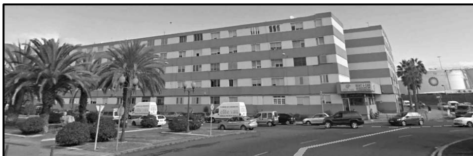
Figura I.7.8. Fachada afectada en Calle Antonio Jorge Aguiar.
