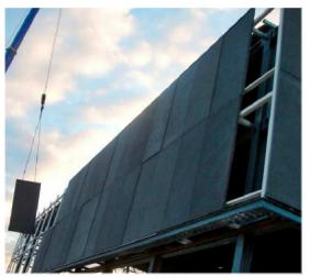
DETALLE PANELES DE HORMIGÓN PREFABRICADO
