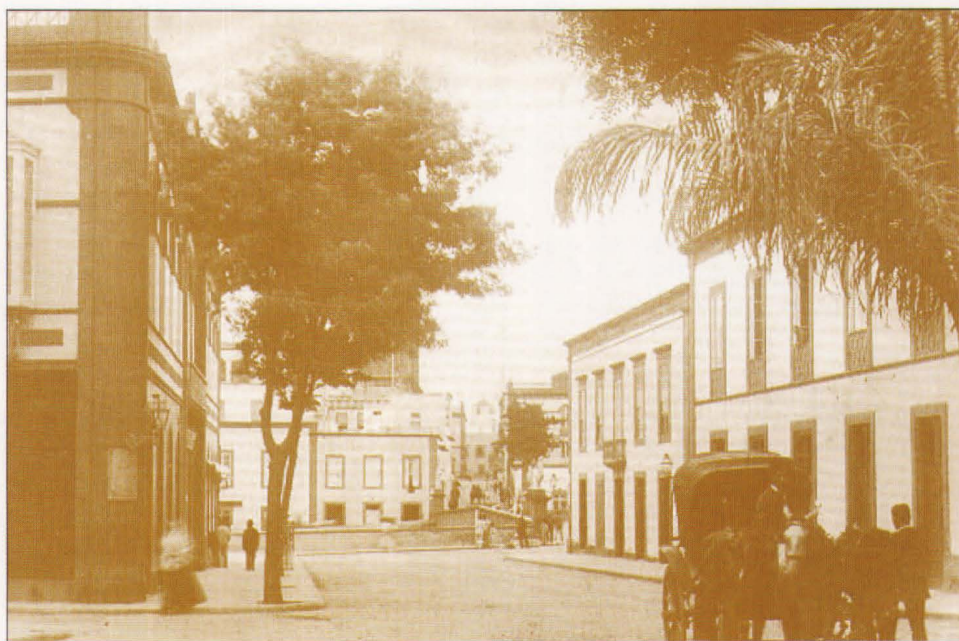
Calle dedicada al Subgobernador Muro en Las Palmas de Gran Canaria (año 1896).
