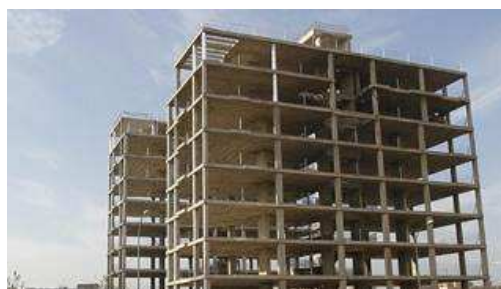
Figura 7: Edificación inconclusa del área metropolitana de Sevilla. (Fuente: los autores)
