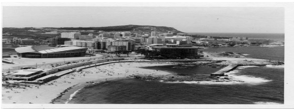
Ilustración 9: Zona del espigón de Riazor. Fuente: Pinterest
