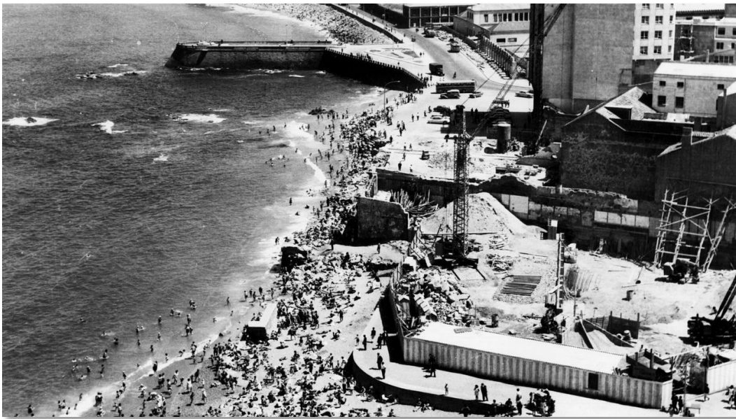
Ilustración 8: Imagen de la fachada marítima en 1964. Fuente: La Voz de Galicia
