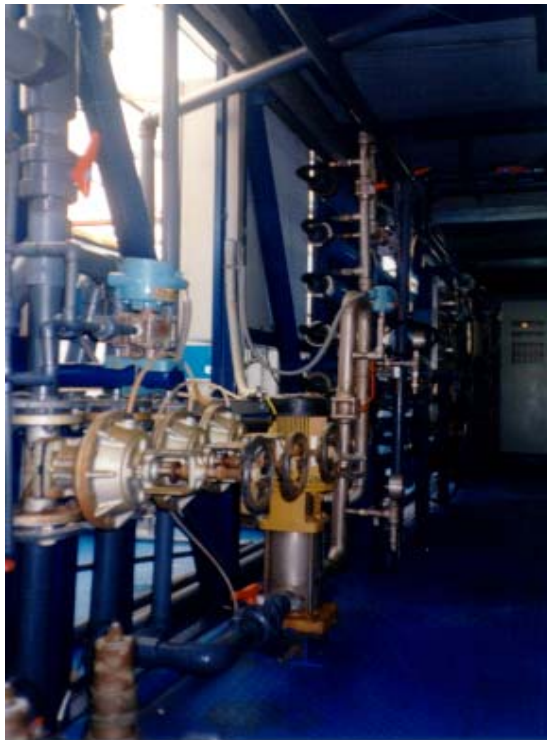
13. Planta Reconvertida de Ultrafiltración
