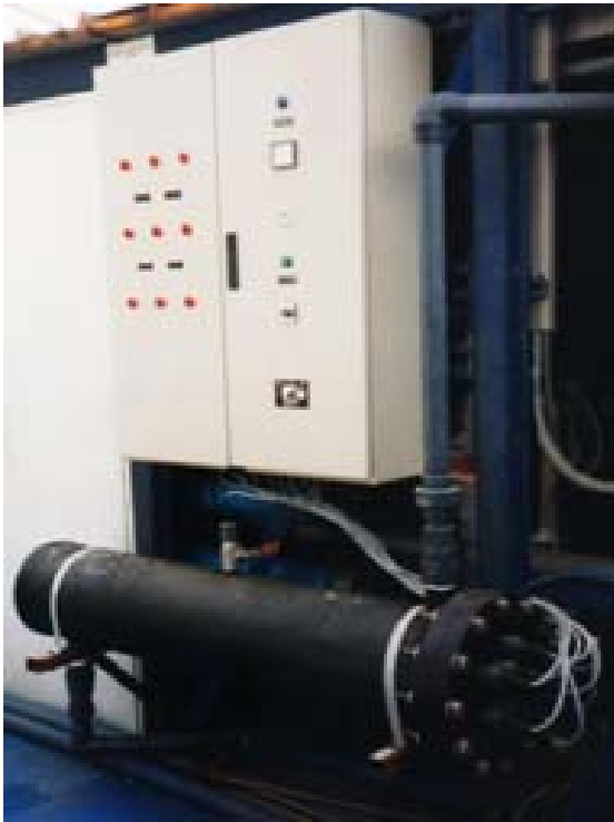
15. Sistema de Desinfección Ultravioleta
