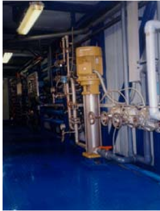
16. Planta Osmosis Inversa, disposición vertical
