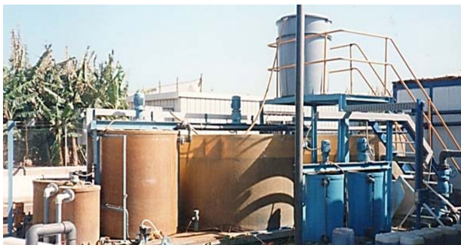
6. Sistema de dosificación químicos
