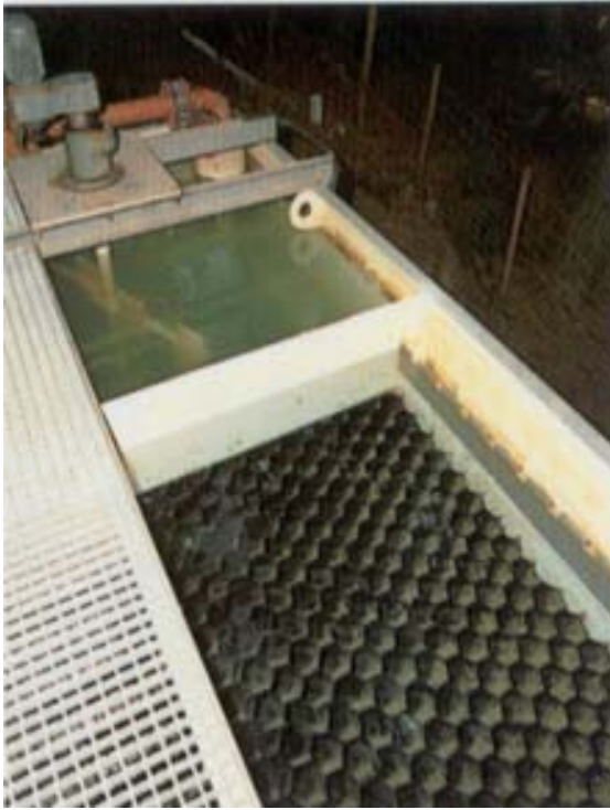
7. Decantador tipo lamelar
