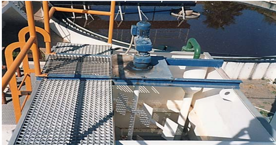
5. Unidad de floculación
