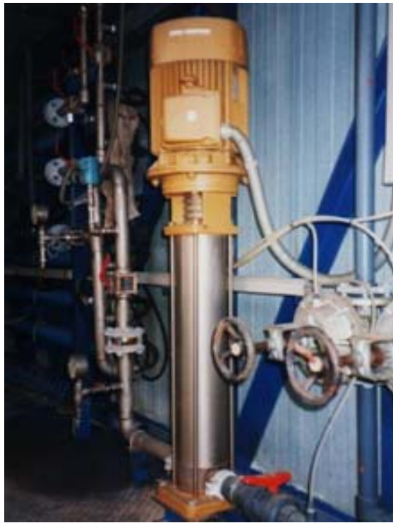
14. Bomba de alta presión OI
