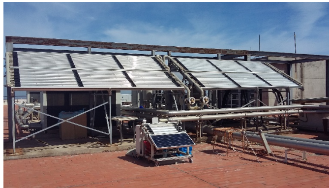
Fig. 3. 23- Planta solar a escala semi-piloto empleada en esta Tesis (plano anterior) y planta solar a escala piloto (plano posterior).
