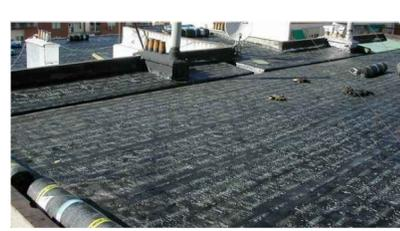
**LÁMINA IMPERMEABILIZANTE BITUMINOSA**
