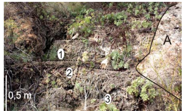
FIGURA 2. Parte del edificio del barranco de Calabozo mostrando al menos 3 pequeñas barreras (1 a 3). A: Fonolitas Miocenas.
