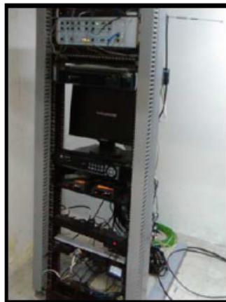
Figura 2.13: Equipos del Sistema de VoIP de Brenntag
