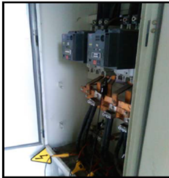
Figura 2.15: Medición de corriente en barras de alimentación principales
