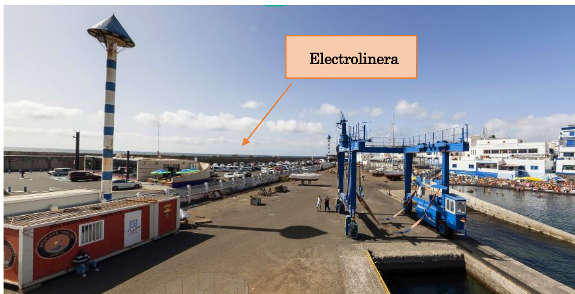
Figura 54. Ubicación electrolinera. Zona de aparcamiento. Fuente: Red de Puertos Canarios
