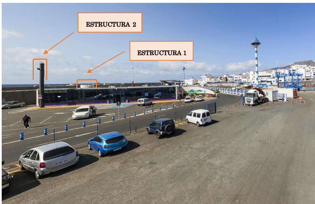
Figura 91. Obstáculos estructurales. Fuente: Red de Puertos Canarios
