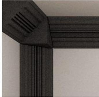
*Figura 19.-Disposición final de las trampas de graves en las esquinas superiores.*
