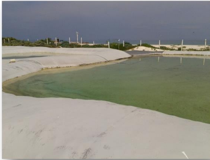
Figura 5: Estanques generales donde se almacena, decanta y airea el agua procedente de los estanques
