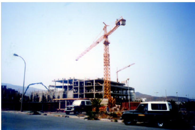
Grúas de construcción: incremento del capital constante en detrimento del variable.
