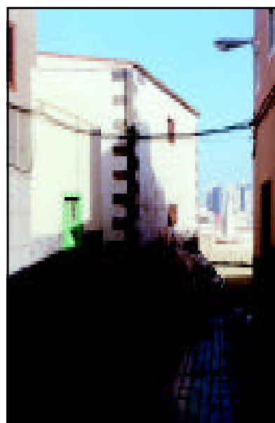
Ilustración de la trasera en donde se observa el encajonamiento que sufre el conjunto.
