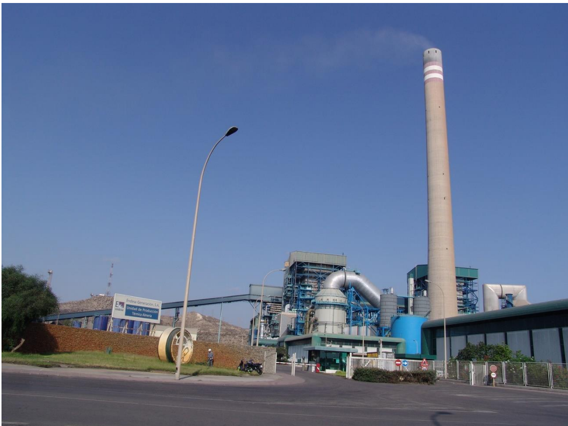
Fotografía 15.30: vista parcial de la Térmica de Endesa (de carbón), en la zona industrial de Carboneras. Captura del 4 de agosto de 2009.
