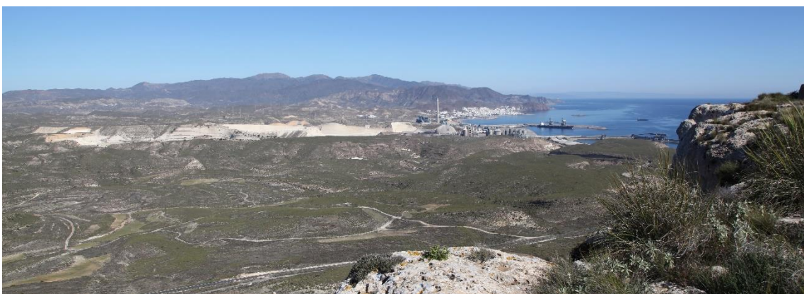
Fotografía 15.3 y 15.4: cicatrices geomorfológicas, en un plano intermedio de la estampa superior, causadas por la extracción de rocas en explotaciones a cielo abierto, para alimentar la cementera de Carboneras (casi en el centro de la estampa inferior). Capturas (de arriba a abajo) del 12 de abril de 2019 y del 14 de marzo de 2012.
