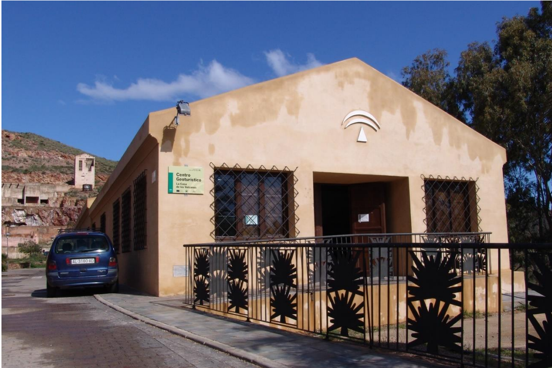
Fotografía 17.4: exterior de una nave de la arqueología industrial minera de Rodalquilar (Almería), restaurada y rehabilitada como Casa de los Volcanes. Captura del 9 de marzo de 2010.
