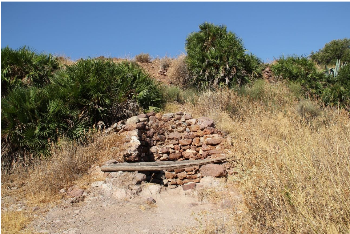
Fotografía 16.70: primer plano del pozo abandonado de agua, en la Rambla de Majada Redonda. Captura del 6 de agosto de 2010.
