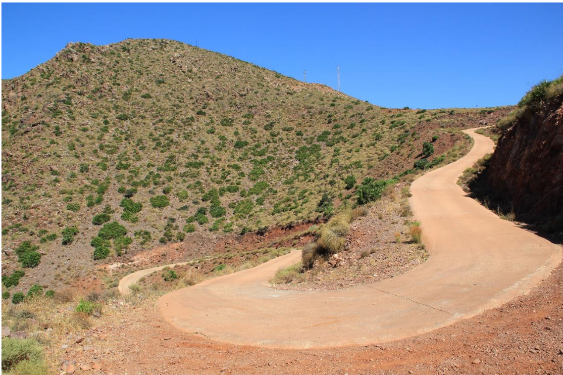
Fotografías 16.10: tramo final del camino de acceso a la divisoria de aguas de La Rellana. Captura del 20 de agosto de 2010.
