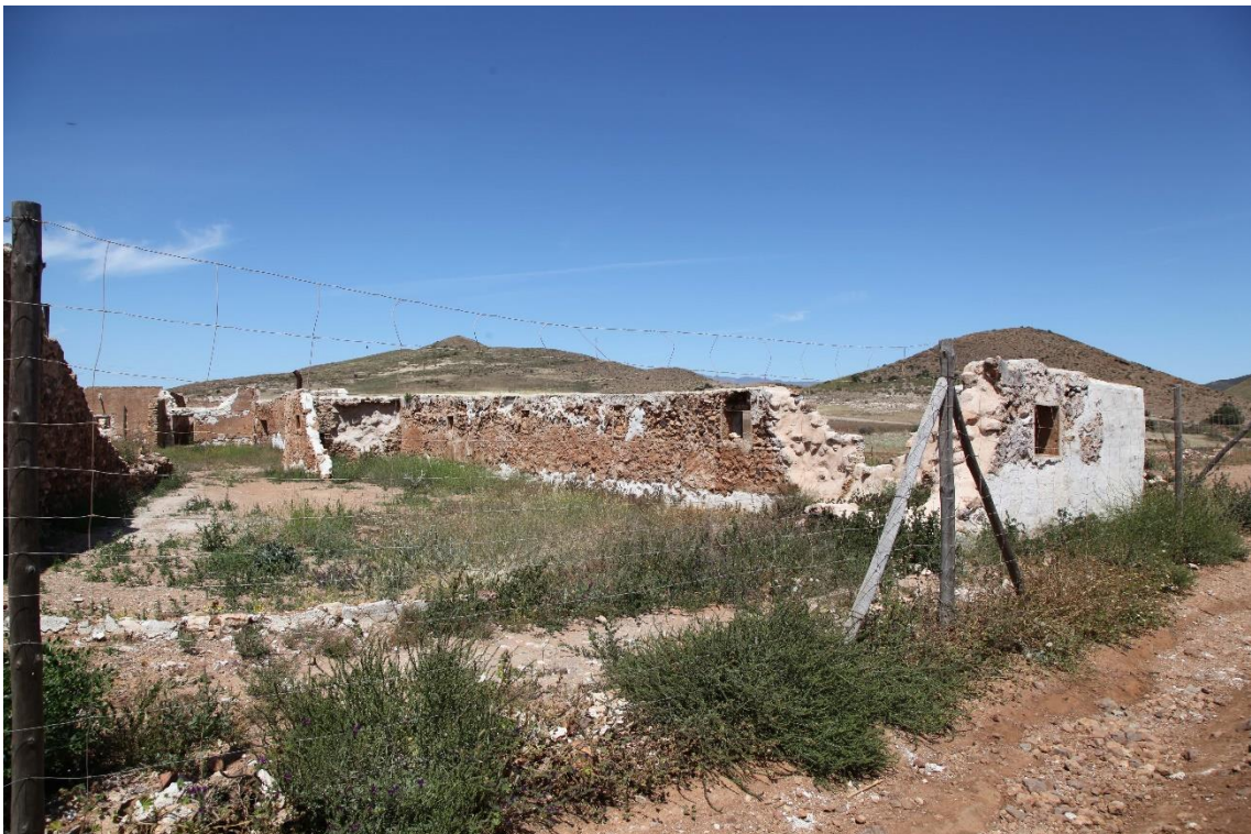
Fotografía 15.58: vistas parciales de las fachadas oriental septentrional del Cortijo del Fraile, después de la segunda fase de las actuaciones de consolidación externa. Las actuaciones de esta segunda fase se iniciaron en la segunda quincena de octubre de 2016. Captura del 3 de mayo de 2017.
