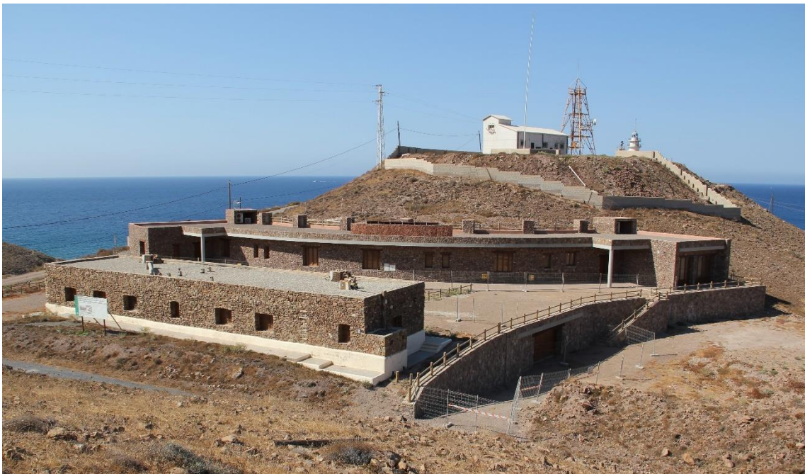
Fotografía 15.43: vista de las obras para levantar el Aula del Mar, en las proximidades del Morro del Cabo de Gata, centradas en la restauración de un antiguo Cuartel de la Guardia Civil. Captura del 26 de julio de 2010.
