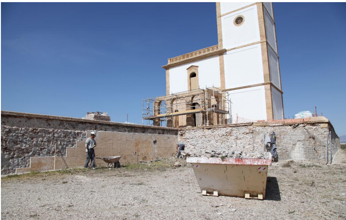
Fotografía 15.48: trabajos de restauración de la Iglesia de Las Salinas, Captura del 23 de marzo de 2012.
