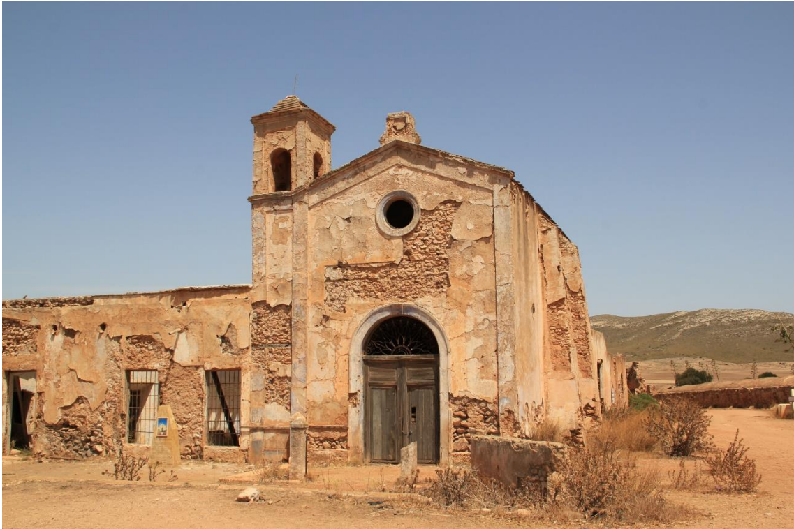
Fotografía 15.51: situación del frontis del oratorio y del campanario antes de las actuaciones de la consolidación (2015-2016). Captura del 17 de agosto de 2011.
