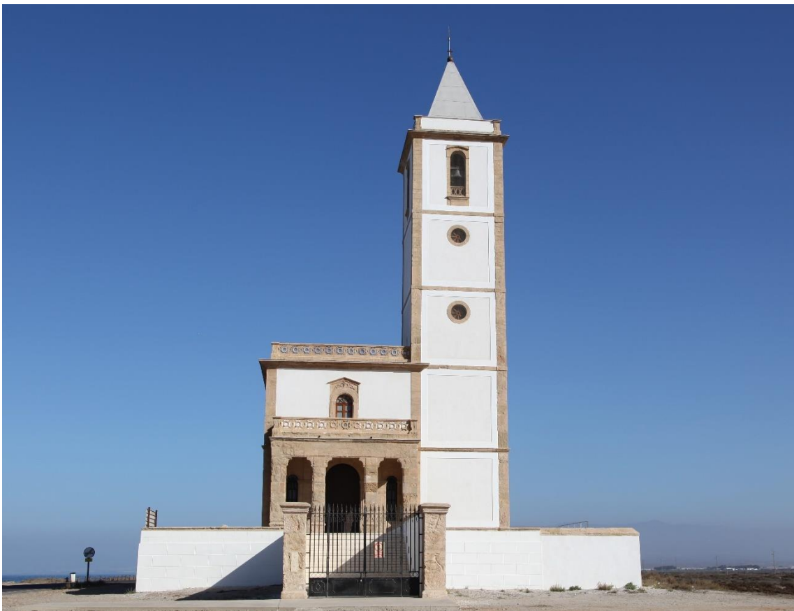
Fotografía 15.50: Iglesia de Las Salinas del Cabo de Gata, tras obras de restauración. Destaca su esbeltez. Captura del 14 de agosto de 2012.
