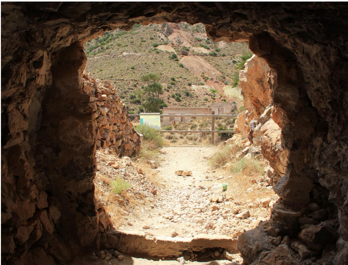
Fotografía 12.145: Túnel de acceso al Poblado de San Diego, que nace en el camino de tierra. entre Rodalquilar y el Cortijo del Fraile. Al final del túnel, hay un mirador. Captura del 3 de agosto de 2011.
