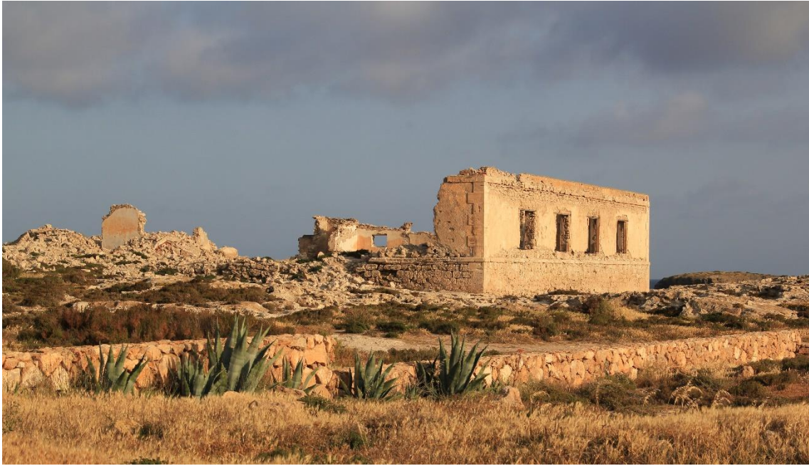
Fotografía 12.64: Fachada lateral de la casa cuartel en ruinas de la Guardia Civil, conocida como de San Felipe, o puesto 1 de Los Escullos. Captura del 15 de abril de 2011.
