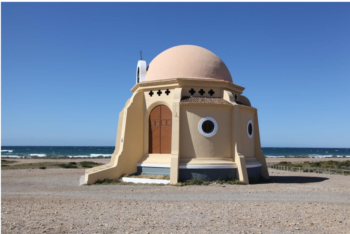
Fotografía 12.219: vista lateral de la Ermita de la Virgen del Mar, en Torregarcía, que se encuentra en el extremo occidental del Parque Natural de Cabo de Gata-Níjar. Captura del 6 de abril de 2012.
