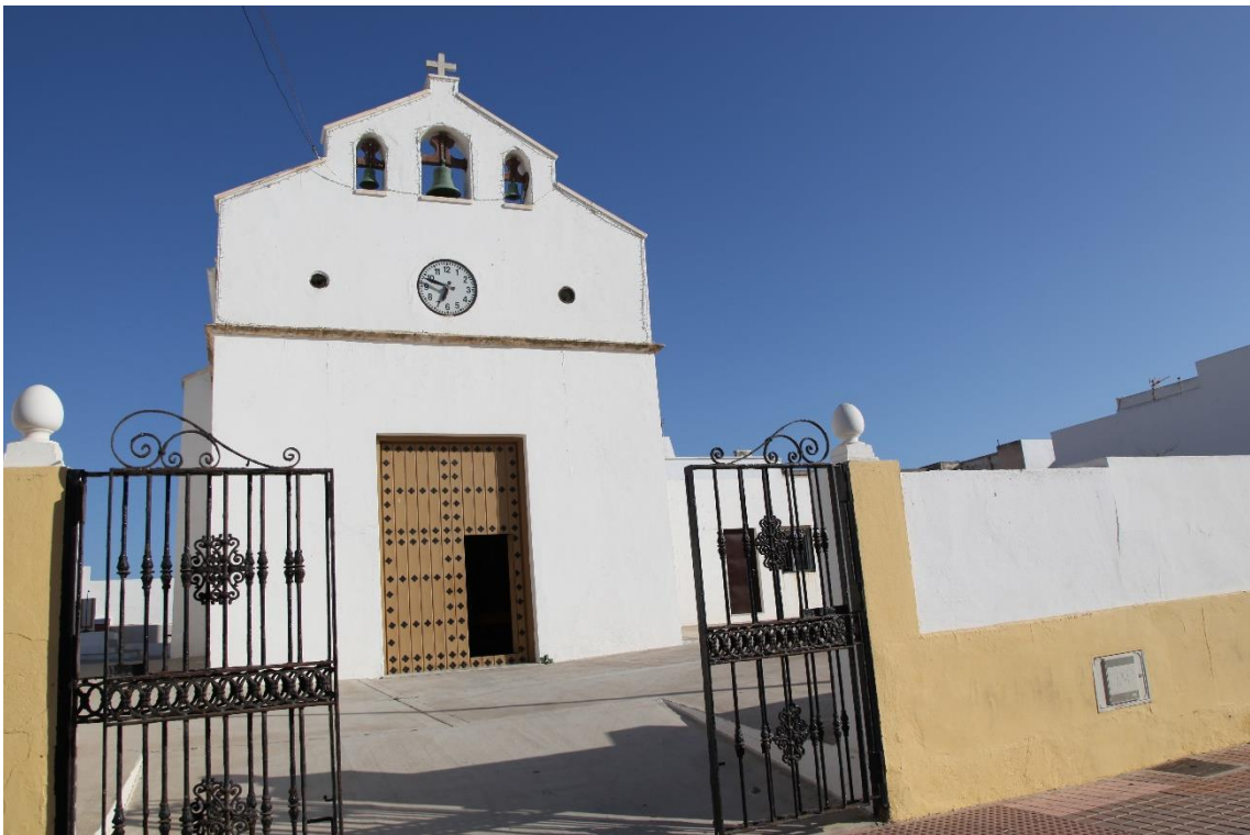
Fotografía 12.239: frontis de la Iglesia de la Pedanía del Cabo de Gata, construida conforme con una tipología popular marinera del Mediterráneo septentrional. Parcialmente, se observa su patio franciscano. Captura del 14 de agosto de 2019.
