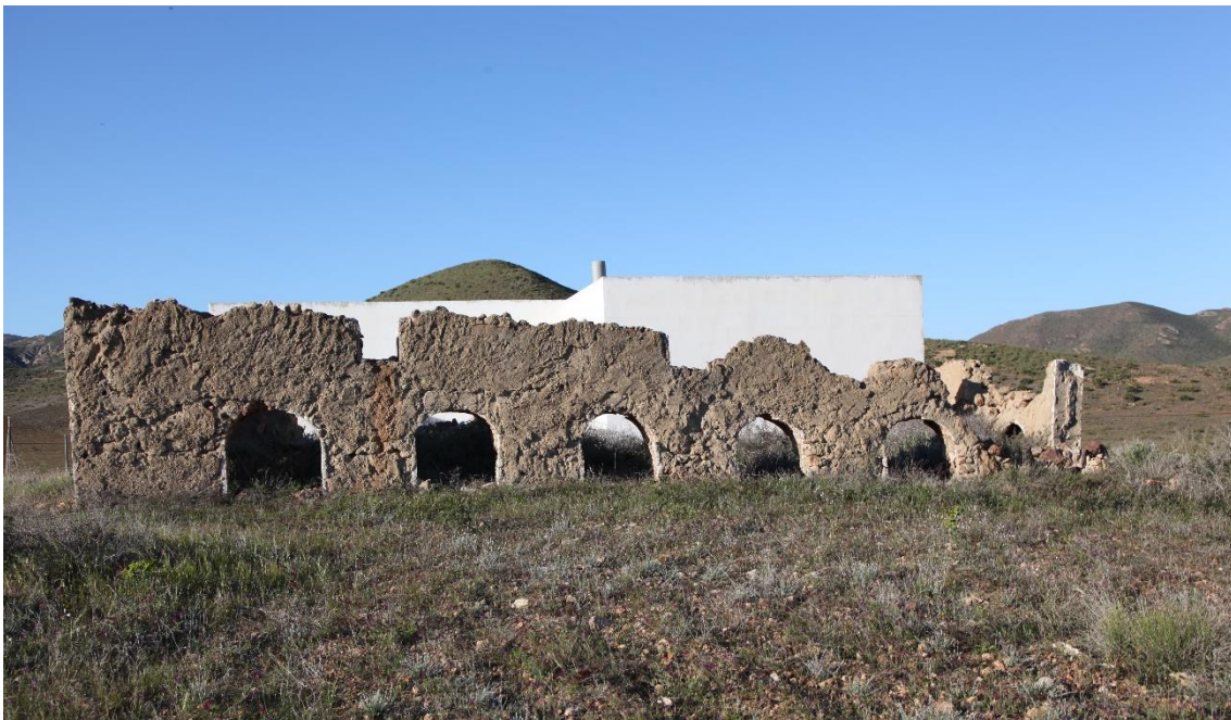
Fotografía 12.89: fachada norte del sestero ganadero de doña Paca Góngora, parcialmente derrumbado para la construcción de una casa en su espacio. Boca de Los Frailes. Captura del 22 de marzo de 2018.
