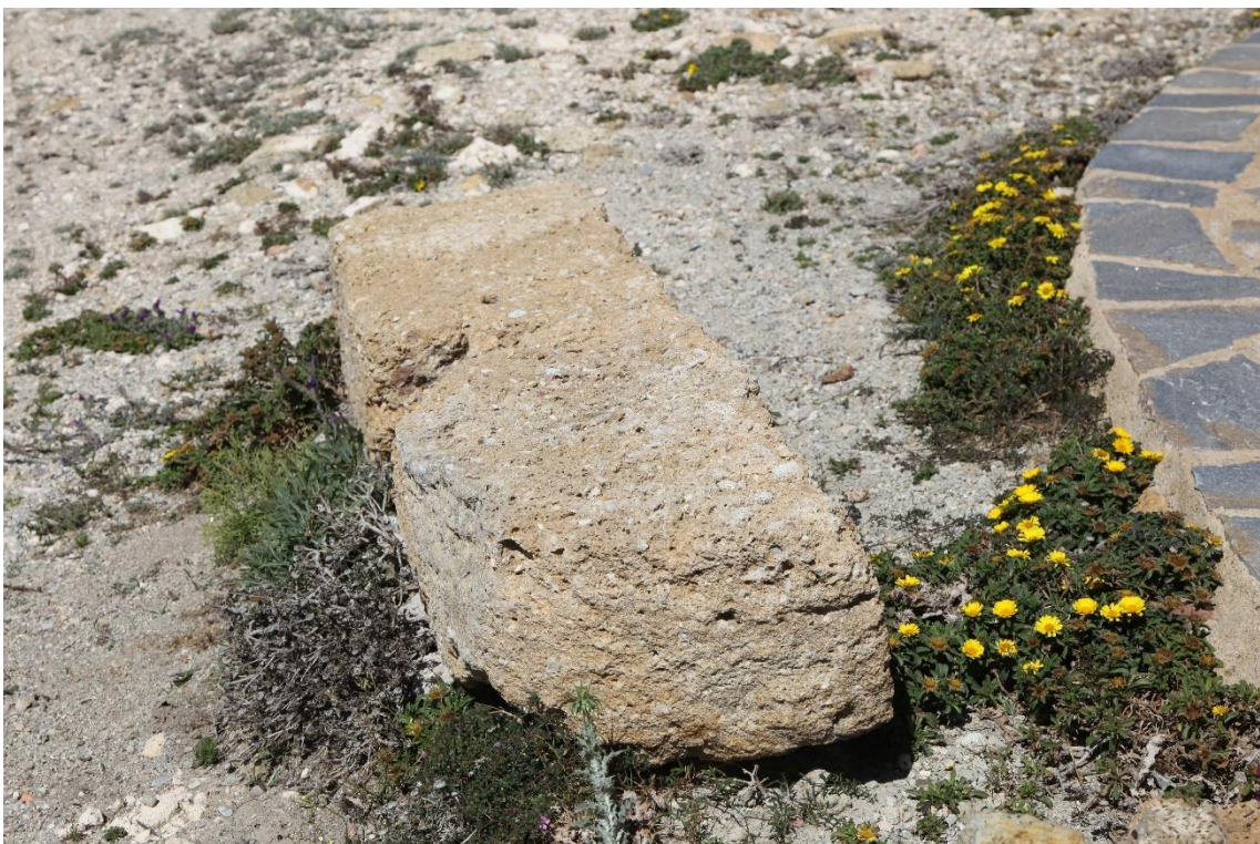
Fotografía 12.26: Torre del Rayo (entre el Pueblo de Carboneras y la Playa de El Algarrobico). Ménsula desprendida, de las que cerraban el anillo decorativo de canecillos. Captura del 26 de abril de 2019.
