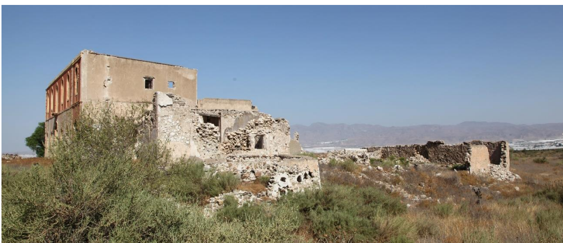
Fotografía 12.70: vista del conjunto del Cortijo Cayuela, en ruinas, con el edificio principal, la casa-vivienda de los aparceros y los corrales y cuadras traseros. Captura del 29 de julio de 2017.
