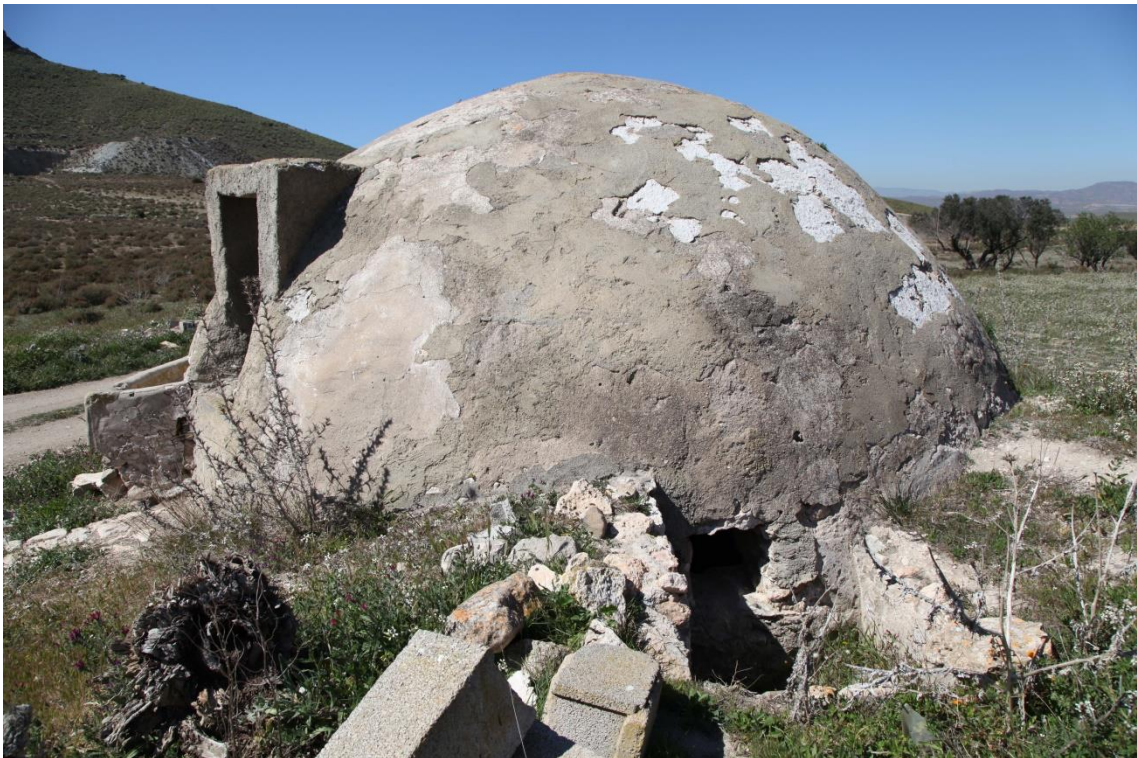
Fotografía 12.84: Aljibe de cúpula en la Cortijada del Collado de Las Huertas (entre Fernán Pérez y Agua Amarga). Destacan la balsa de decantación del agua de escorrentía procedente del canal de conducción, el tragante, el acceso al almacenamiento de agua y una parte del abrevadero. Captura del 14 de marzo de 2012.
