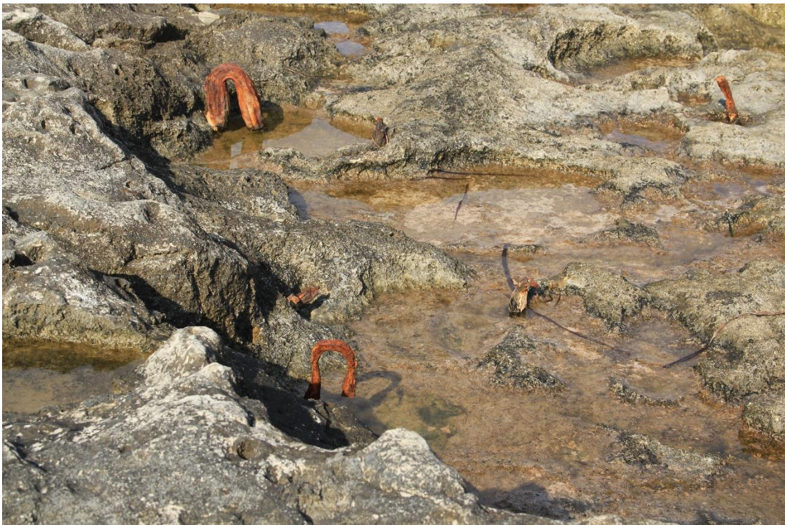
Fotografía 12.168: hierros que formaron parte de las infraestructuras del cargadero meridional que había en la Bahía de El Playazo. Captura del 30 de julio de 2011.
