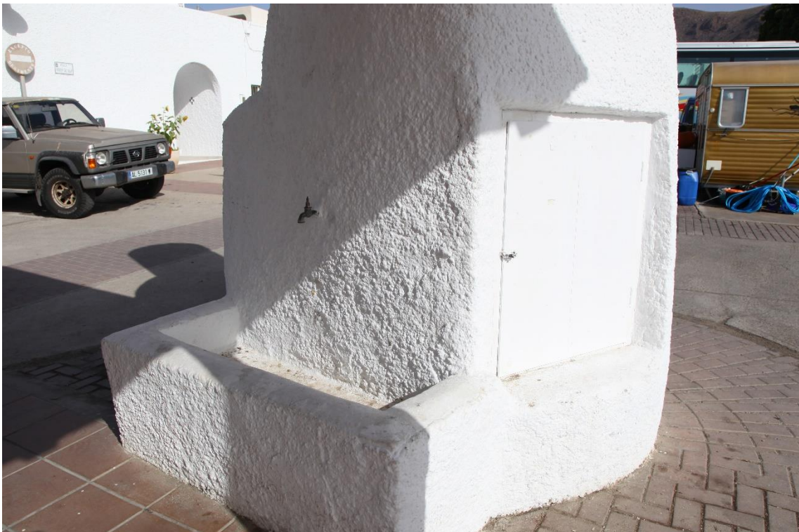
Fotografía 12.91: detalle del pozo, que abastecía de agua, al lavadero comunal restaurado de la Pedanía rehabilitada de La Isleta del Moro. Captura del 12 de agosto de 2019.
