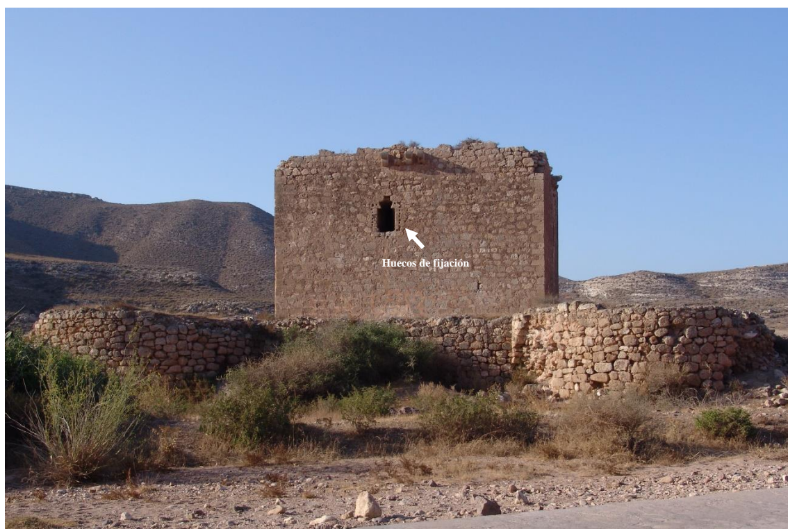
Fotografía 12.36: Torre (Torreón) de Los Alumbres (o Castillo de Rodalquilar) donde se aprecia la fábrica de cantería y los huecos de fijación de un enrejado, ya desaparecido, alrededor de una de las ventanas laterales de la fortificación. Captura del 17 de agosto de 2009.
