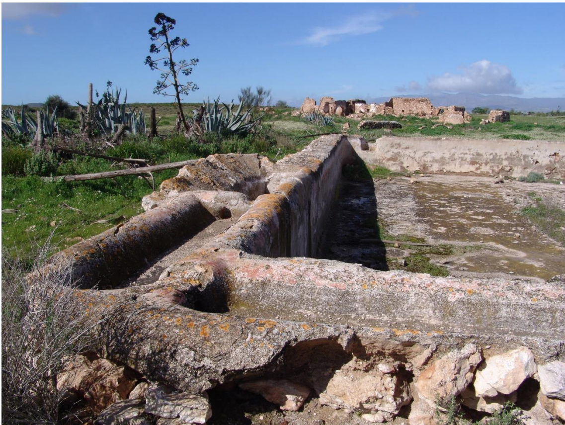
Fotografía 12.86: vista del abrevadero y del lavadero servidos por la acequia adosada al exterior del pretil de la mareta y alimentada por el depósito de distribución del agua del pozo. Captura del 4 de marzo del 2010.
