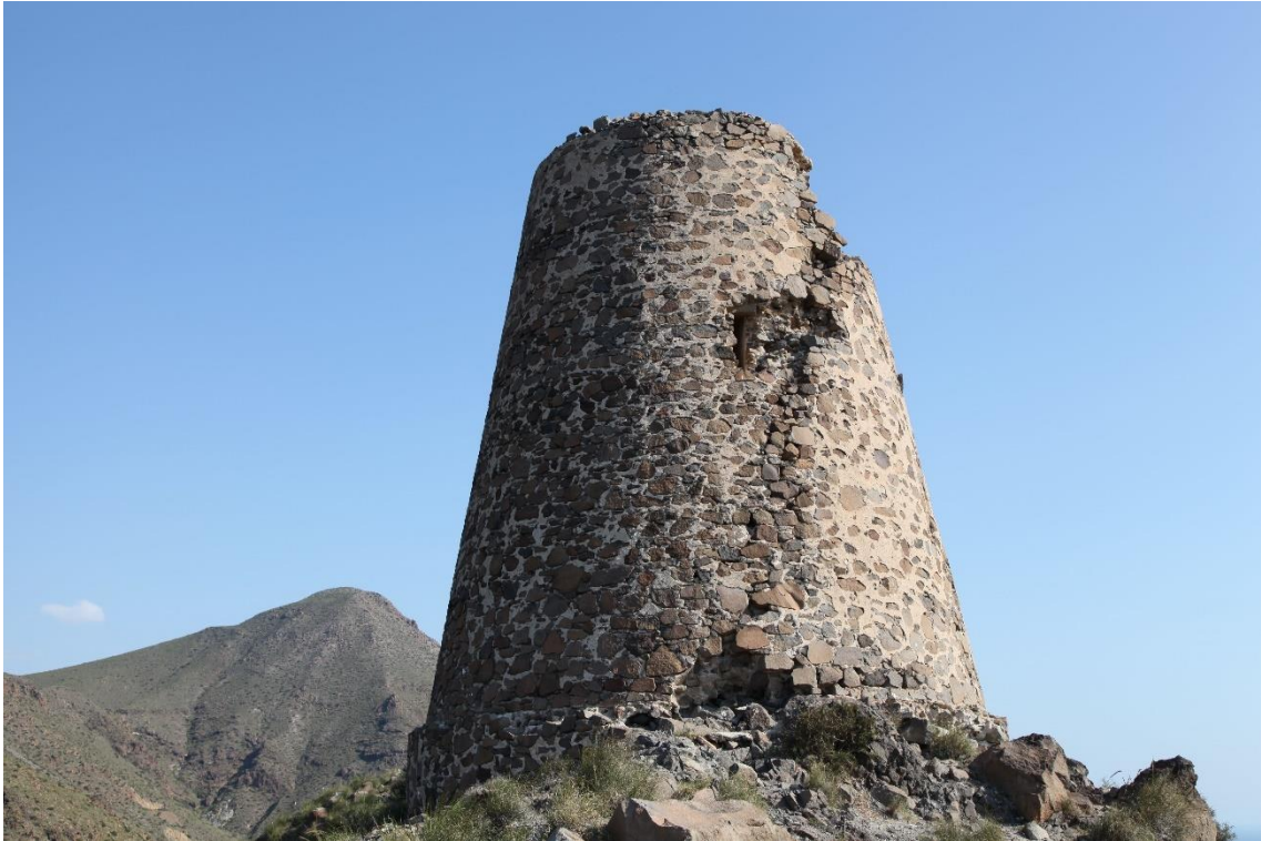
Fotografía 12.21: Torre de Vigía de Punta Higuera, en el extremo oriental de la Cala Higuera, entre San José y Los Escullos. Captura del 10 de marzo de 2012.
