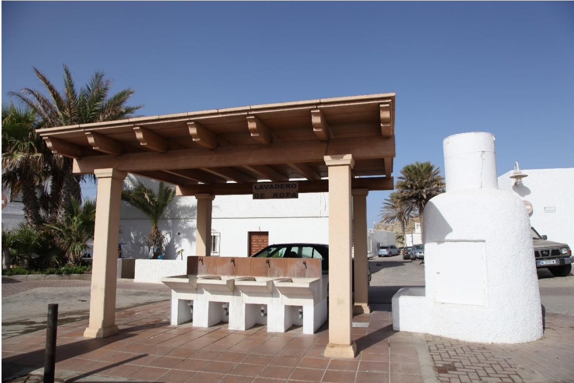
Fotografía 12.90: lavadero comunal restaurado, con su pozo de abastecimiento de agua (a la derecha de la imagen). Este pozo tiene encima un depósito para el almacenamiento de agua. Pedanía rehabilitada de La Isleta del Moro. En el pasado reciente, la pedanía era básicamente marinera, pero donde también había casas populares de cortijeros. Captura del 12 de agosto de 2019.
