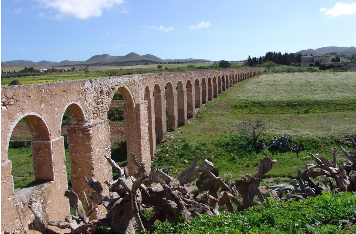
Fotografía 12.117: Acueducto de Fernán Pérez (1906). Vista lateral de la obra hidráulica desde su tramo inicial según el sentido de la circulación del agua. Captura del 4 de marzo de 2010.
