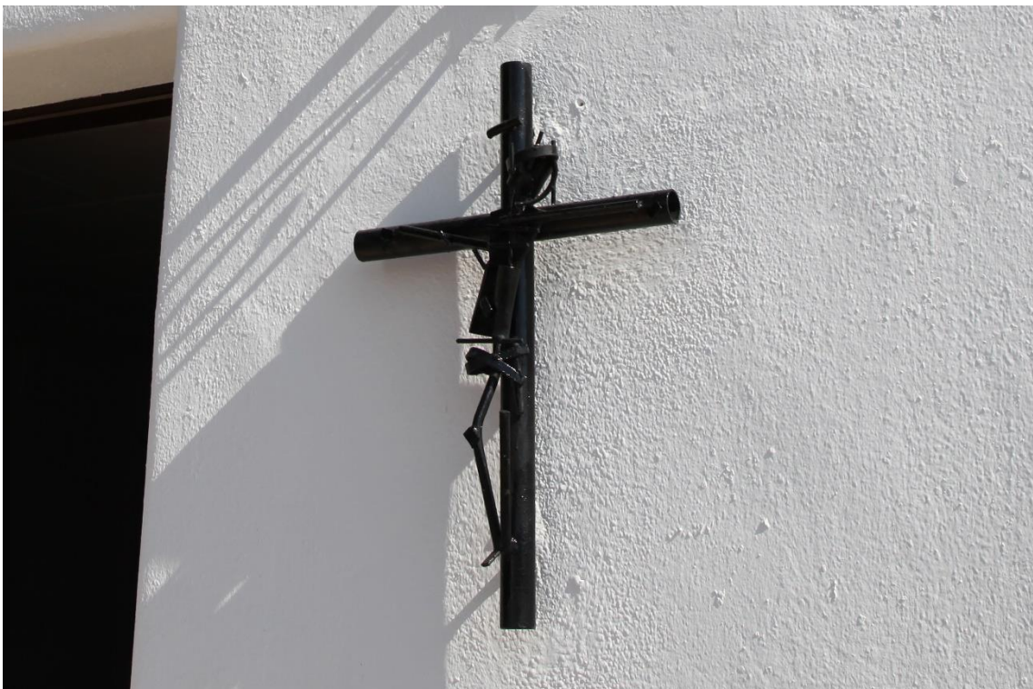
Fotografía 12.253: detalle de uno de los ornatos (un Crucifijo de hierro forjado) en el frontis de la Capilla de El Argamasón, como una alternativa de personalizar una tipología edificatoria externa simplista, a modo de una construcción cúbica con cobertera en terrao . Captura del 30 de agosto de 2019.
