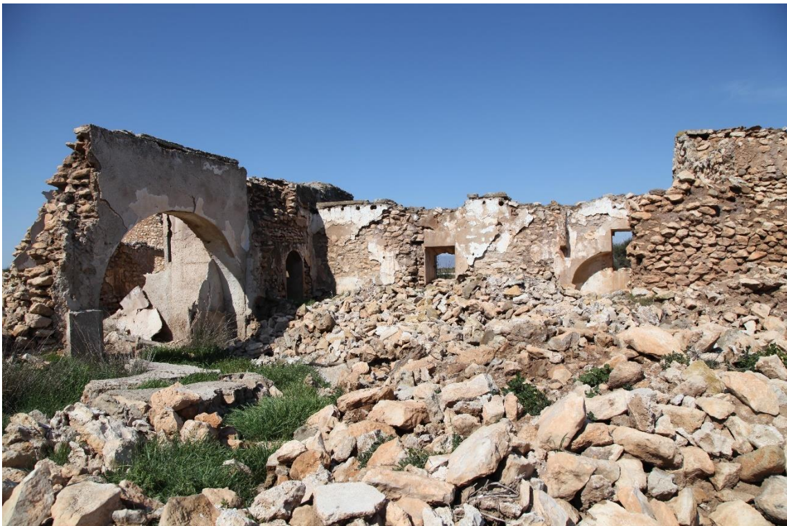
Fotografía 12.76: en las ruinas habitacionales de la Cortijada de Balsa Blanca, destaca el uso de arcos entre estancias. Captura del 3 de marzo de 2012.
