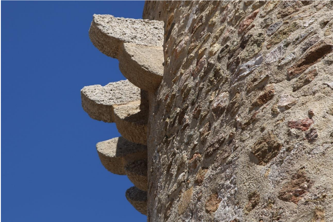
Fotografía 12.25: Torre del Rayo (entre el Pueblo de Carboneras y la Playa de El Algarrobico). Detalles de las ménsulas, o canecillos decorativos, de estilo renacentista, de la parte superior de la torre. En sus tiempos, estas ménsulas desarrollaban un anillo ornamental. Captura del 26 de abril de 2019.
