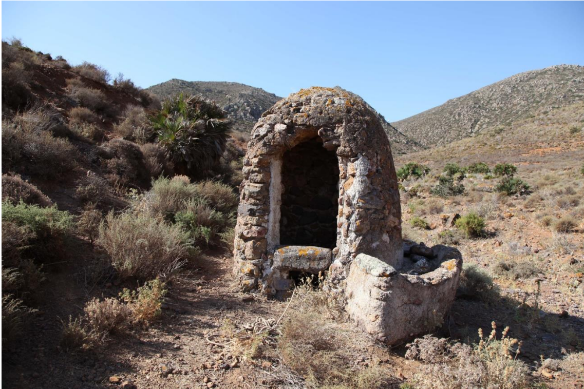
Fotografía 12.83: Pozo de Requena. A diferencia de los aljibes de cúpula, un generoso brocal, por su altura, hace que este pozo tome esbeltez. Aquí adquiere también protagonismo el abrevadero. Captura del 31 de julio de 2014.
