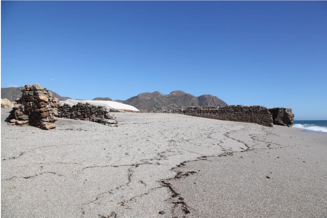
Fotografía 12.183: restos de las infraestructuras en piedra argamasada y soterradas del Muelle de Las Salinas, actualmente descarnadas por la erosión de la mar. Playa de Las Salinas del Cabo de Gata (entre la Iglesia de Las Salinas y la Almadraba). En un plano intermedio, se observa el acopio de las cosechas de sal. En el fondo escénico, toma protagonismo el SW de la Sierra del Cabo de Gata. Captura del 11 de abril de 2019.
