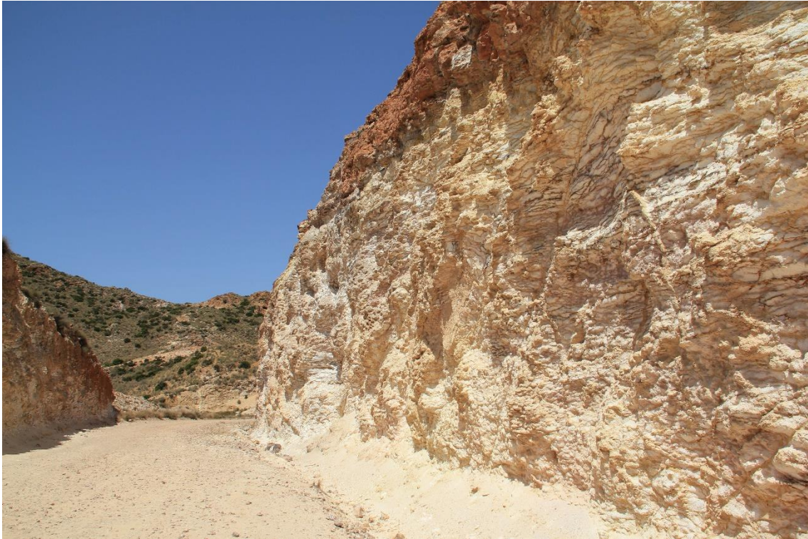
Fotografía 12.144: tramo del camino terrero entre Rodalquilar y el Cortijo del Fraile donde se encuentra excavado el túnel de acceso al Poblado minero de San Diego. Captura del 17 de agosto de 2011.
