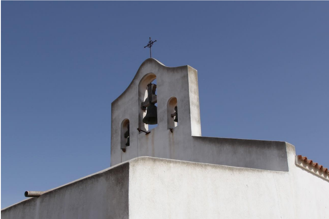
Fotografía 12.250: detalle de la espadaña en la fachada trasera de la Iglesia de San Fernando, en la pedanía de Fernán Pérez. Captura del 12 de agosto de 2019.
