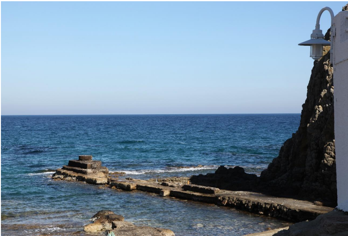
Fotografía 12.162: muelle en desuso, al oriente del istmo de La Isleta del Moro. Fue construido para el desembarco de la pesca artesanal del lugar durante situaciones de fuertes oleajes de levante. Captura del 13 de marzo de 2012.
