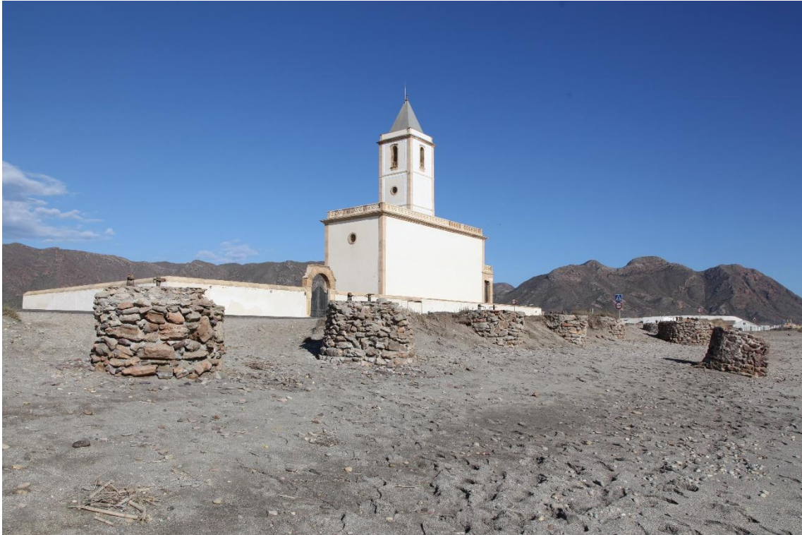
Fotografía 12.185: conjunto de once cilíndricos de piedra que soportaban las poleas para varar a las barcazas utilizadas en el transporte de sal entre el muelle de Las Salinas y los buques fondeados en las proximidades. Playa de Las Salinas del Cabo de Gata (frente a la Iglesia de Las Salinas). Captura del 11 de abril de 2019.
