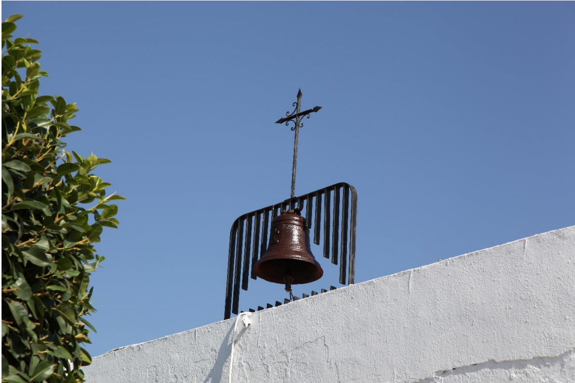
Fotografía 12.254: detalle de uno de los ornatos (una espadaña de hierro forjado, de un solo ojo con su reluciente campana) en el frontis de la Capilla de El Argamasón, como una alternativa de personalizar una tipología edificatoria externa simplista, a modo de una construcción cúbica con cobertera en terrao . Captura del 30 de agosto de 2019.
