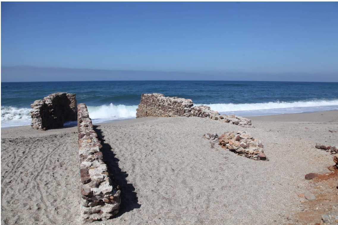
Fotografía 12.184: restos de las infraestructuras en piedra argamasada y soterradas del Muelle de Las Salinas, actualmente descarnadas por la erosión de la mar. Playa de Las Salinas del Cabo de Gata (entre la Iglesia de Las Salinas y la Almadraba). Captura del 16 de abril de 2019.
