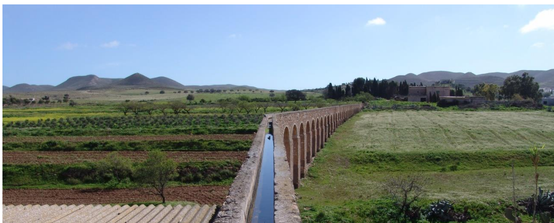
Fotografía 12.116: Acueducto de Fernán Pérez (1906). Vista de superior de la obra hidráulica desde su tramo inicial según el sentido de la circulación del agua. Captura del 4 de marzo de 2010.
