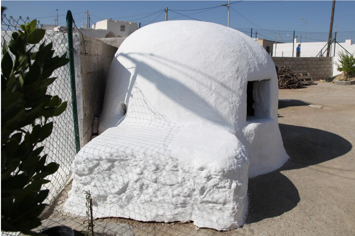
Fotografía 12.107: horno restaurado de pan, dentro de un patio de una casa, en la pedanía de Argamasón. Sector carbonero del Parque Natural de Cabo de Gata-Níjar. Captura del 31 de julio de 2014.
