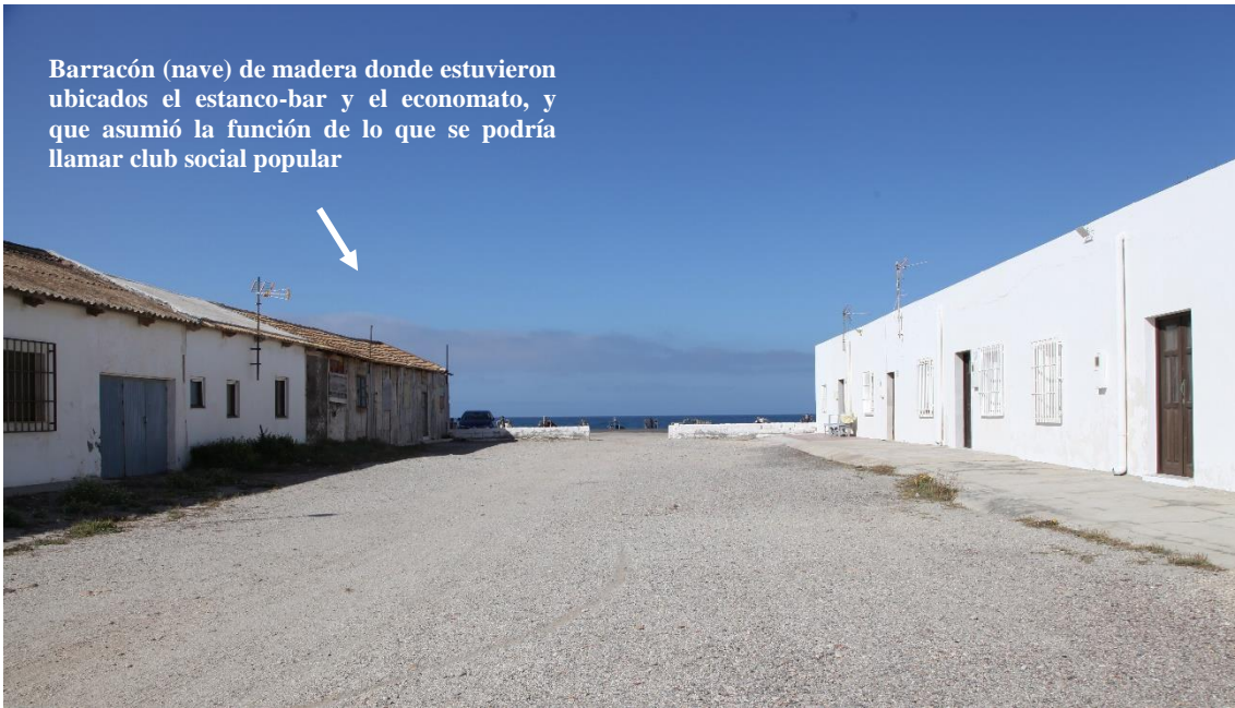
Fotografía 12.154: Poblado salinero de Cabo de Gata. Vista de una de las calles transversales a la Playa (la situada más hacia el noreste). A la derecha, hay una hilera de casas. La acera con sus bancos, al pie de las fachadas de este frente de casas, está estratégicamente orientada al sureste (para tomar el sol durante las mañanas de los inviernos, y la sombra en las calurosas tardes de los veranos). Captura del 16 de abril de 2019.
