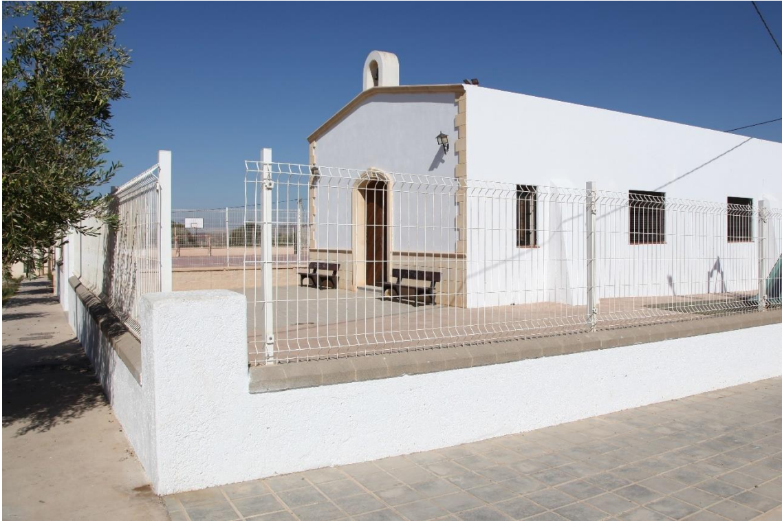
Fotografía 12.244: vista frontal-lateral de la Iglesia de Los Albaricoques, construida según una tipología popular marinera del Mediterráneo septentrional, desde el exterior del patio. Captura del 19 de agosto de 2019.
