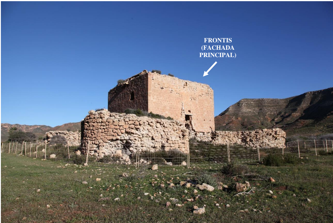
Fotografía 12.33: Torre (Torreón) de Los Alumbres, o Castillo de Rodalquilar, entre Rodalquilar y El Playazo. En la fachada iluminada se encuentra la entrada principal. Captura del 21 de marzo de 2018.
