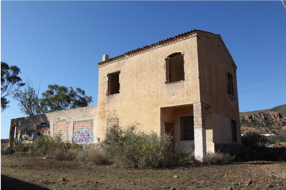
Fotografía 12.150: Ruinas del Poblado minero de Rodalquilar. Vista externa del edificio que fue la escuela. Captura del 14 de abril de 2019.
