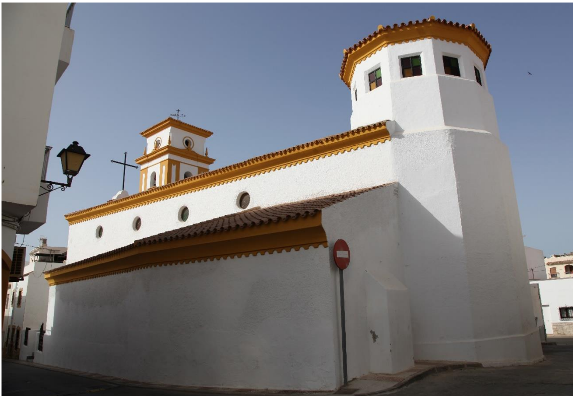
Fotografía 12.261: vista trasera y lateral (la que da a la Calle Nueva), con sus tragaluces, de la Iglesia de Carboneras. En un primer plano, a la derecha, toma identidad el cimborrio atípico, que ilumina al altar mayor. Captura del 8 de agosto de 2019.
