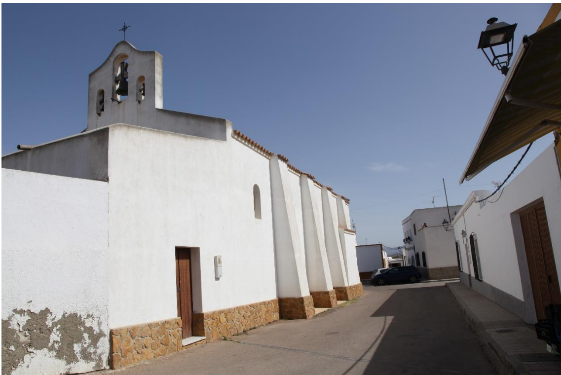
Fotografía 12.249: fachada trasera de la Iglesia de Fernán Pérez, con una espadaña de tres ojos. Y fachada lateral con contrafuertes triangulares. Captura del 12 de agosto de 2019.
