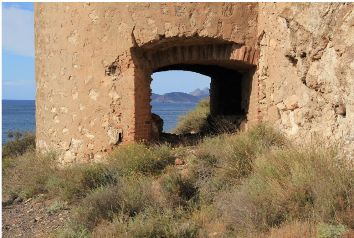
Fotografía 12.179: vanos de la base, recubiertos con ladrillos refractarios, del horno de calcinación (o de cal) en ruinas junto a los restos del Cargadero de mineral de Agua Amarga. Estos vanos son las ventanas del patrimonio cultural minero del lugar hacia su entorno del SW, dentro del Parque Natural de Cabo de Gata-Níjar. Captura del 22 de abril de 2011.
