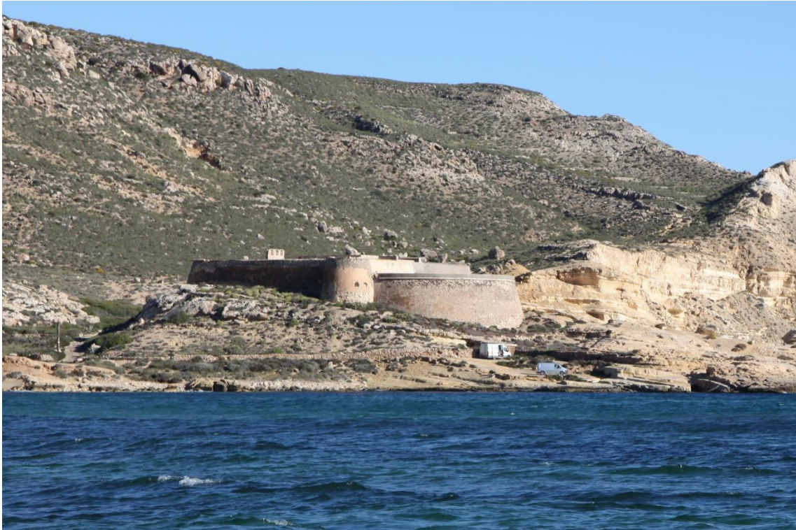
Fotografía 12.55: Batería de San Ramón en El Playazo. Vista desde el apoyo occidental del depósito de arenas. Captura del 20 de marzo de 2018.
