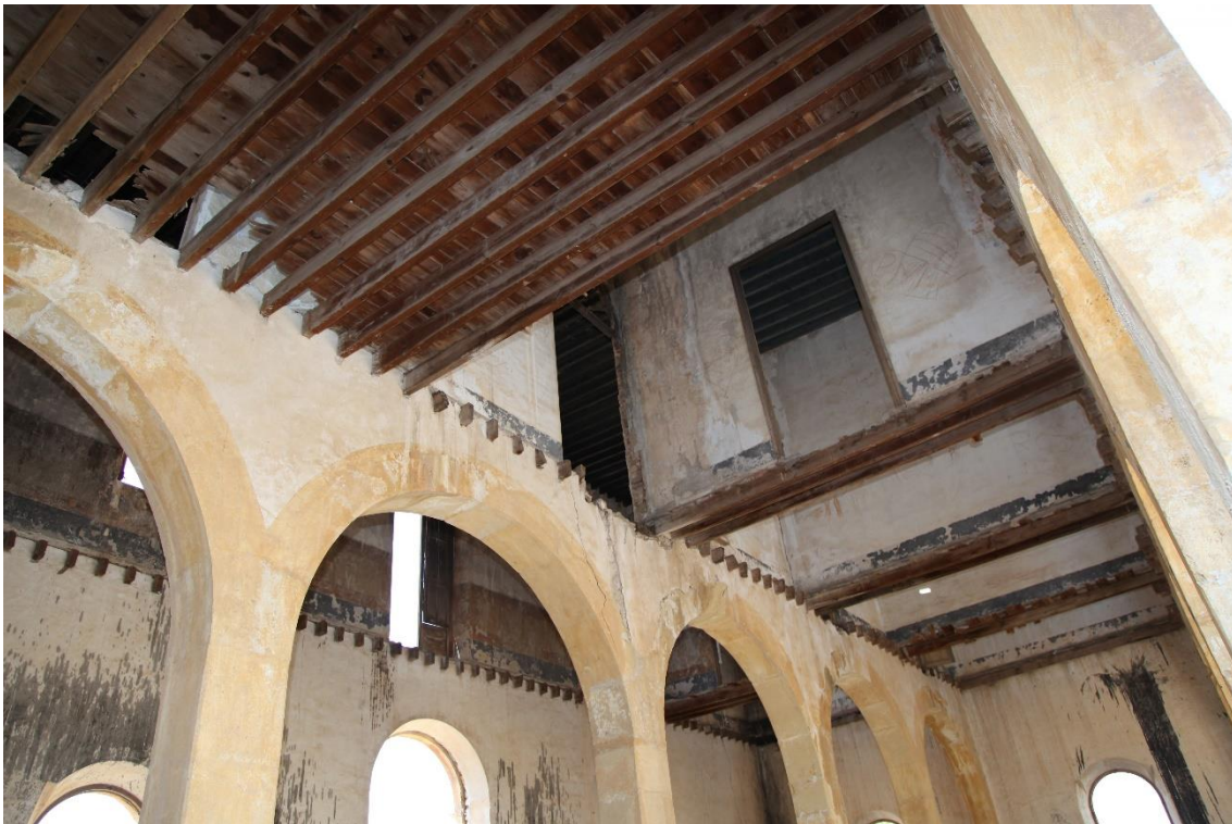
Fotografía 12.72: en la parte izquierda superior de la imagen, detalle de los techos entre los almacenes de la planta baja y la vivienda de los dueños en la planta alta, dentro del edificio principal del Cortijo Cayuela. Captura del 29 de julio de 2017.
