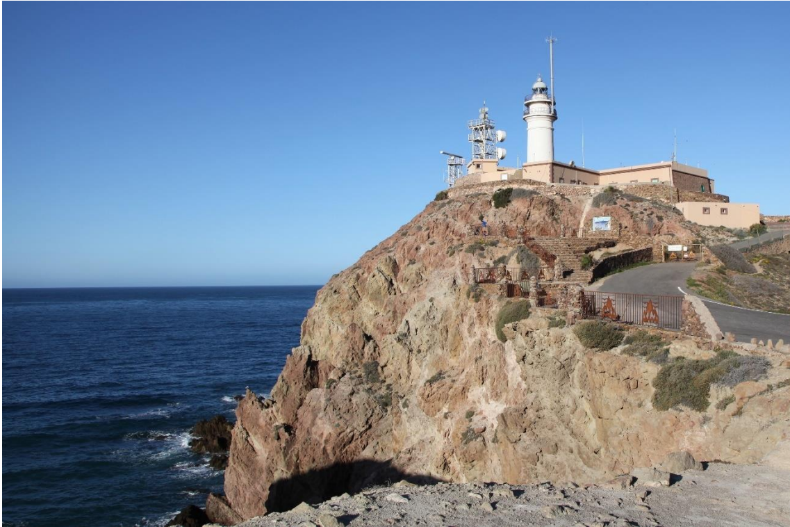
Fotografía 12.158: Faro del Cabo de Gata, dentro del recinto de una fortificación muy transformada (completamente desnaturalizada). Captura del 10 de abril de 2019.
