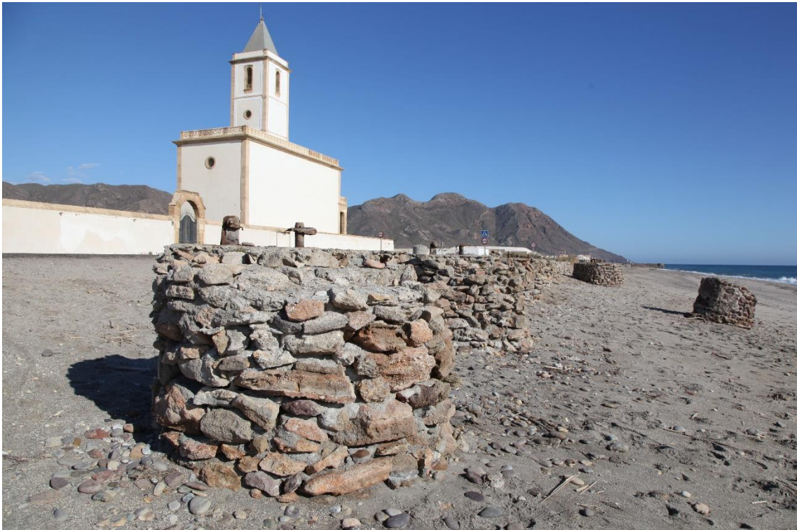
Fotografía 12.186: Detalles del conjunto de cilindros de piedra que soportaban las poleas para varar a las barcazas utilizadas en el transporte de sal entre el muelle de Las Salinas y los buques fondeados en las proximidades. Playa de Las Salinas del Cabo de Gata (frente a la Iglesia de Las Salinas). Captura del 11 de abril de 2019.
