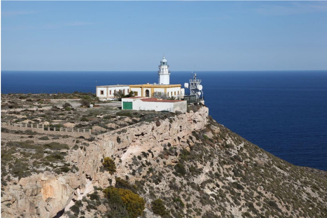
Fotografía 12.160: Faro de la Mesa Roldán (entre Agua Amarga y Carboneras), para la navegación marítima. El horizonte entre la mar y el cielo aparece difuso por la humedad reinante durante la toma de la imagen. Captura del 22 de marzo de 2018.
