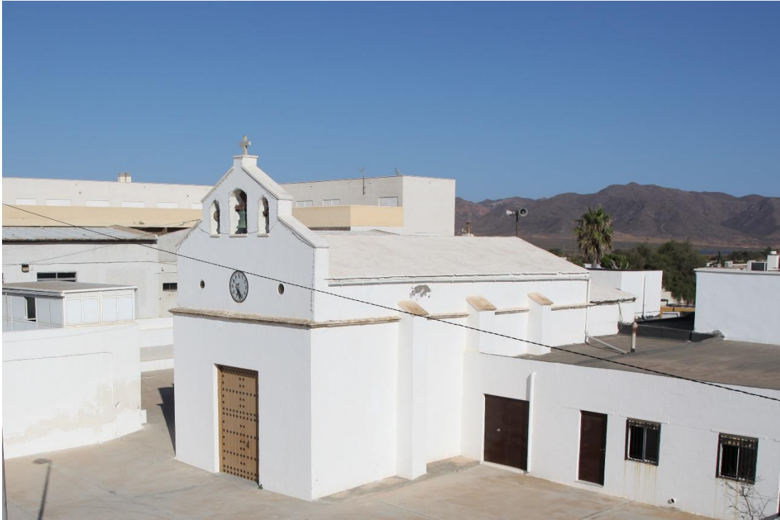
Fotografía 12.238: vista de la planta y del alzado, con su frontis y una de sus fachadas laterales, de la Iglesia de la Pedanía del Cabo de Gata, construida conforme con una tipología popular marinera del Mediterráneo septentrional. Como fondo escénico, se encuentra la Sierra volcánica más meridional del Cabo de Gata. Captura del 14 de agosto de 2019.
