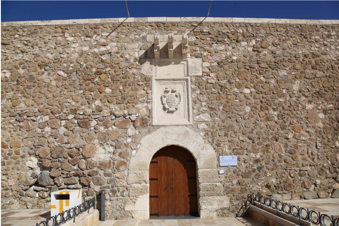
Fotografía 12.59: Castillo de San Andrés (Carboneras). Detalles de la fachada principal después de la última restauración. Captura del 26 de abril de 2019.
