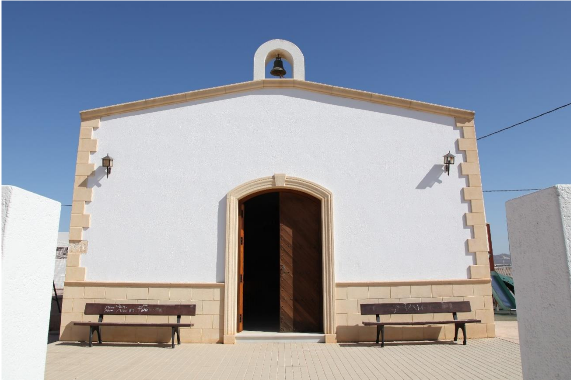
Fotografía 12.246: frontis de la Iglesia de Los Albaricoques, construida según una tipología popular marinera del Mediterráneo septentrional. Destaca la simplicidad de la espadaña y la puerta de entrada enmarcada por jambas y una arcada con clave. Captura del 19 de agosto de 2019.
