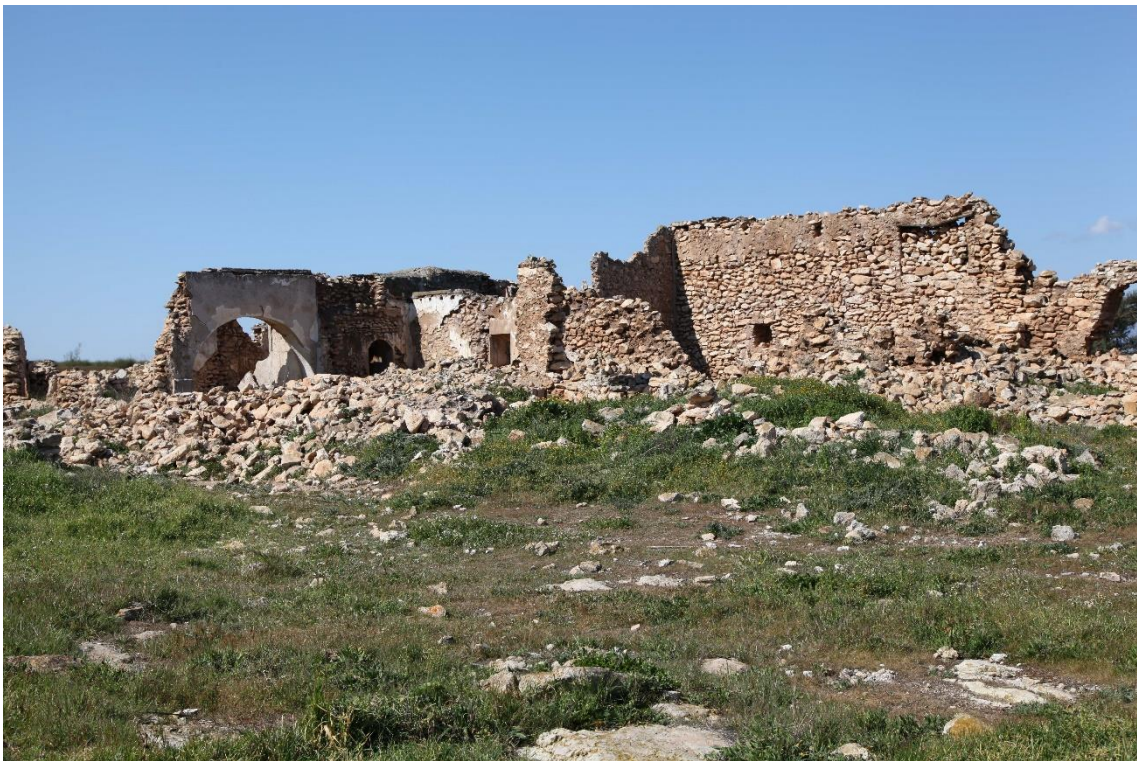
Fotografía 12.74: vista parcial de la tipología edificatoria externa y de las obras de interiorismo en las ruinas habitacionales de la Cortijada de Balsa Blanca. Captura del 3 de marzo de 2012.
