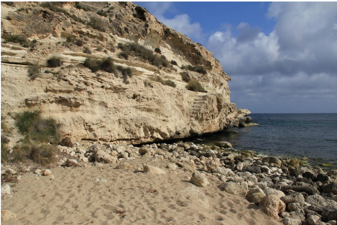
Fotografía 5.32: Socavón de la erosión por el mar en el acantilado que forma el apoyo oriental de la Playa de Agua Amarga. En este caso, el cuerpo de agua del mar no se encuentra sometido a una marea meteorológica. Captura del 15 de abril de 2011.
