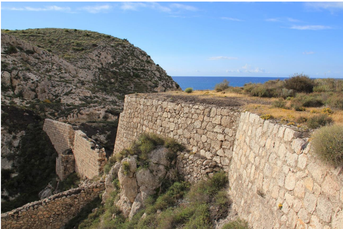
Fotografía 3.67: detalles de la fábrica y geometría de las tolvas más internas (las más alejadas del frente marítimo). Captura del 22 de abril de 2011.
