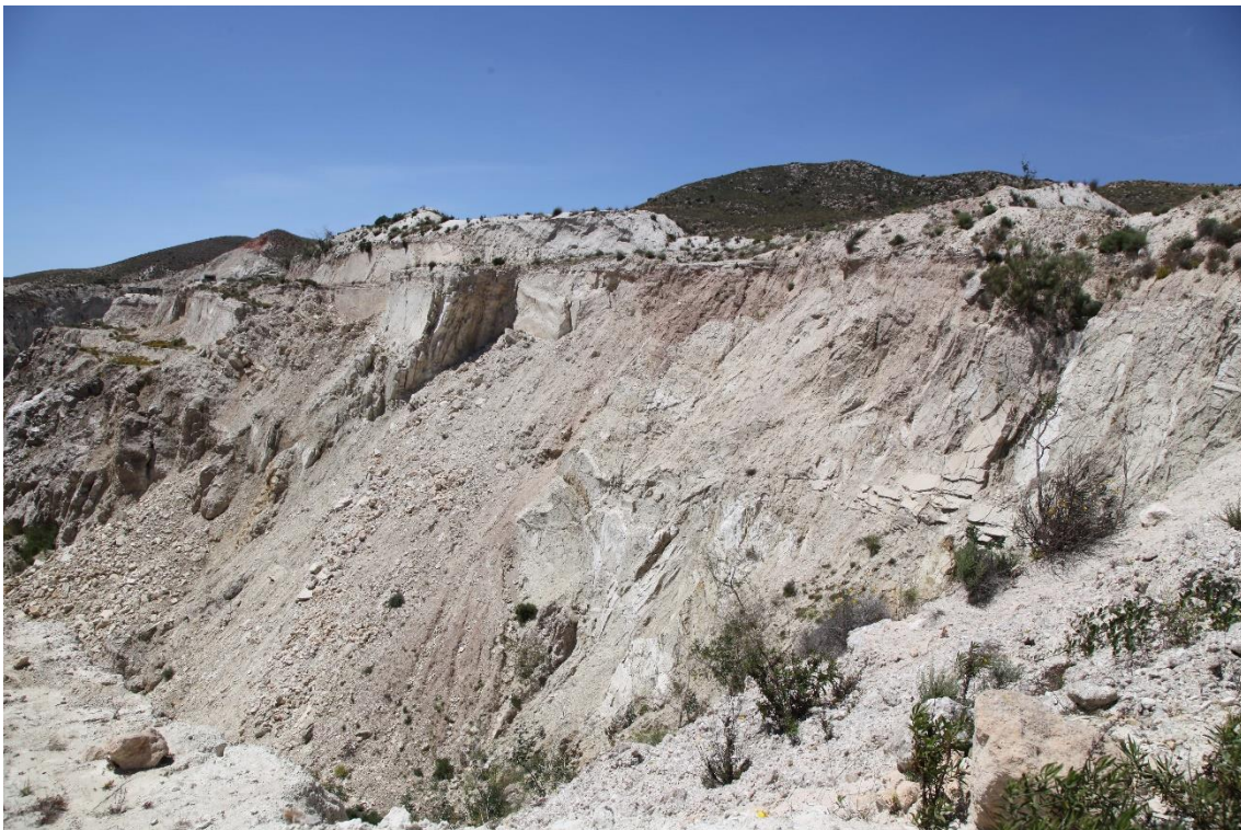
Fotografía 3.26: uno de los frentes de ataque de explotación de la Cantera Julia. Parte del frente se encuentra soterrado por los derrumbes. Captura del 30 de abril de 2017.
