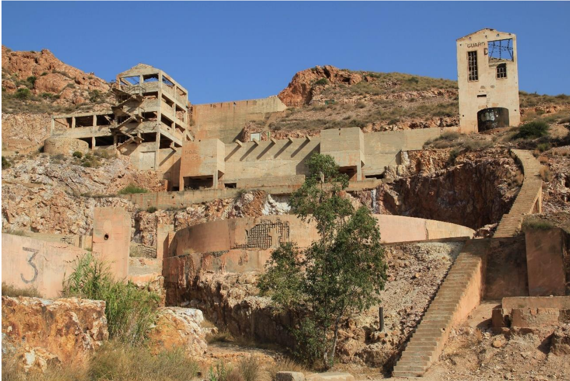
Fotografía 3.23: parte de las instalaciones de la Empresa ADARO. En un primer plano, se encuentra algunos de los tanques lavadores en relación con el procesado de la roca aurífera. Casi en un plano escénico intermedio, se suceden, de izquierda a derecha, la torre de admisión-trituradora de la roca, el complejo de molienda y el transformador eléctrico. Captura del 17 de agosto de 2011.
