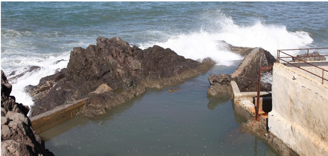
Fotografías 3.37-3.39: aproximación de olas de poniente. Mediante salpiqueo y rebose, las olas llenan las piscinas de alimentación (el afluente) de Las Salinas (Cabo de Gata) con agua de mar. Las piscinas se ubican a pie de los Acantilados de Ancón, entre La Fabriquilla y El Faro. Capturas del 17 de agosto de 2018 (la primera) y del 11 de abril de 2012.
