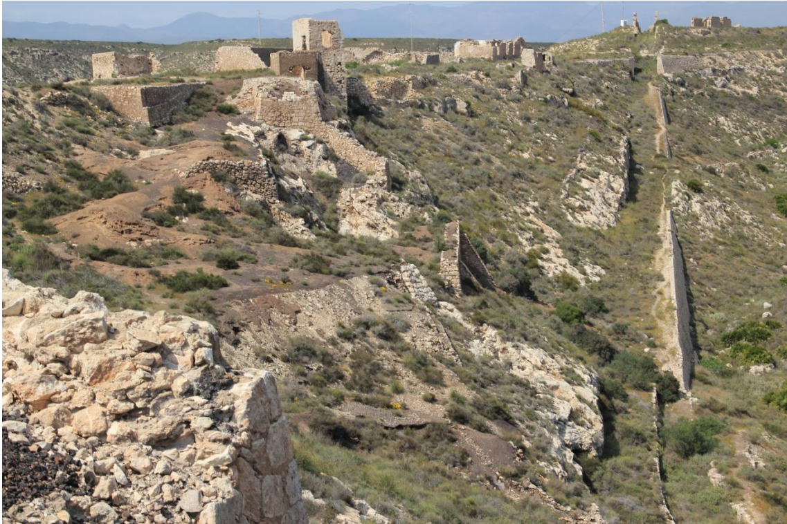
Fotografía 3.60: vista frontal del plano inclinado automotor del Cargadero, desde el sur. En la zona recogida dentro de la parte inferior derecha de la imagen, se iniciaban las ramificaciones de los raíles hacia las tolvas. En la parte superior de la imagen, a la izquierda, se encuentra la zona de los silos subterráneos del mineral. A la izquierda, casi como fondo escénico, se encuentra el pueblo minero. Captura del 11 de abril de 2011.
