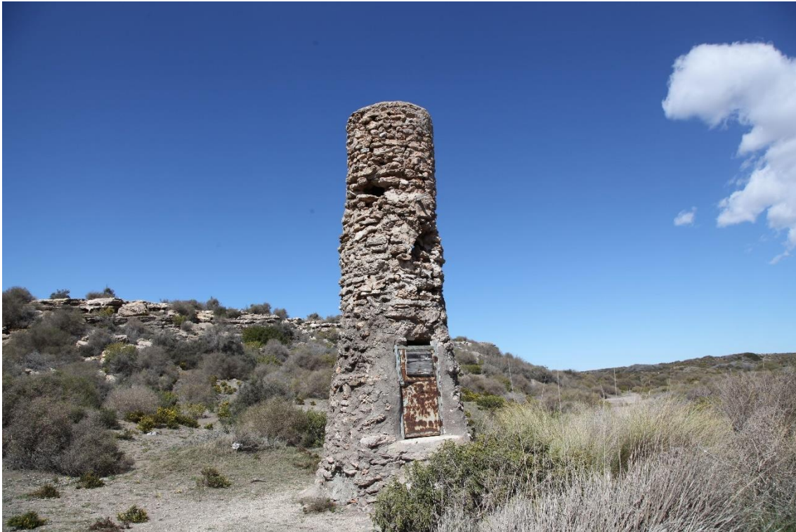
Fotografía 2.17: El Pocico con su puerta de explotación del agua más reciente en la parte inferior de la construcción, al descender el nivel de base de la rambla, en relación con el techo del cuerpo de obra externo del pozo. De este pozo y hasta 1990, se obtuvo potable, aunque algo salobre, según la comunicación personal de don Francisco Vargas (comunicación personal del 26 de marzo de 2018). Captura del 24 de marzo de 2018.
