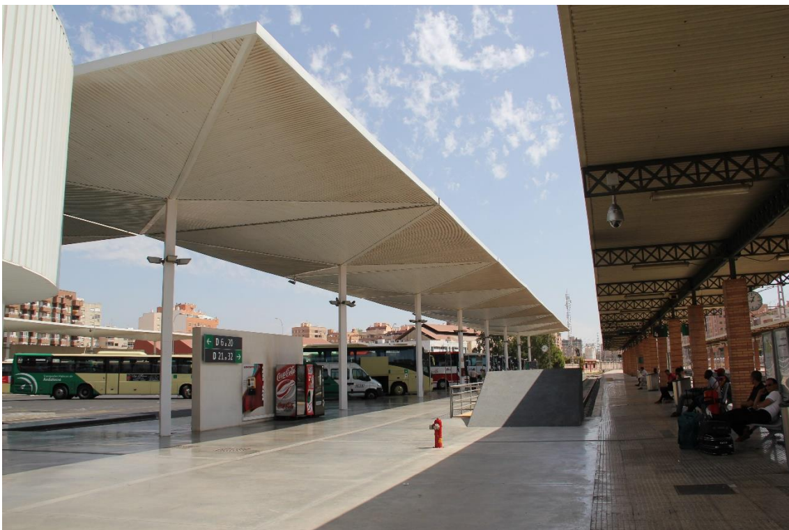
Fotografía 1.14: vista parcial de la dársena de autobuses de la Estación Intermodal de Almería, tras el vestíbulo central, donde se ubican el punto de información, la cafetería, los baños, diversas tiendas, la sala de espera y las oficinas del ferrocarril y de las diferentes líneas regulares de transporte de pasajeros por carretera, con sus puntos de ventas de pasajes.
