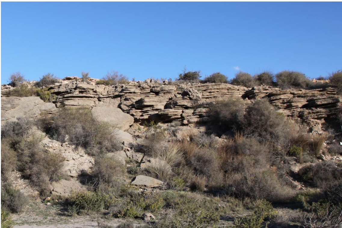
Fotografía 2.19: margen derecho, aguas abajo, de la Rambla de Las Amoladeras, a la altura de El Pocico. Se observa una estratificación muy marcada en la columna litológica del Glacis de Las Amoladeras-Morales. Asimismo, se aprecia bloques de estratos caídos por socavamiento de la base. El corte litológico se encuentra en las proximidades de la orilla del mar. Captura del 24 de marzo de 2018.
