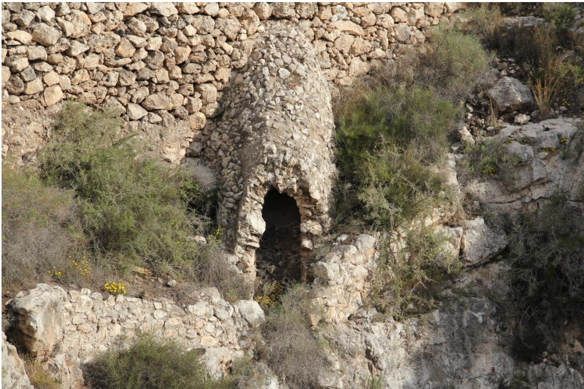
Fotografía 3.69: detalle de una bocamanga que permite la entrada a una de las tolvas más internas (más alejadas del Cargadero). Captura del 22 de abril de 2011.
