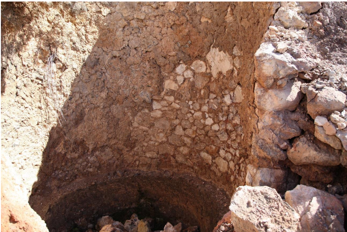
Fotografía 3.53: vista parcial del interior de la Calera de la Palmera, en la periferia de Huebro (Níjar). Destaca el bordillo que servía para apoyar el primer anillo (el más externo) de la cúpula que soportaba la carga de piedras calizas en el horno de cal. Captura del 3 de mayo de 2017.
