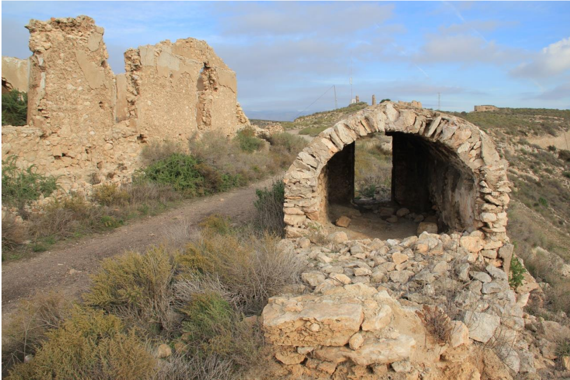
Fotografía 3.79: detalles frontales de una de las construcciones de almacenamiento, con bóveda de cañón (a la derecha y en un primer plano), al borde del camino de la divisoria de aguas, desde el sur. Captura del 4 de enero de 2011.
