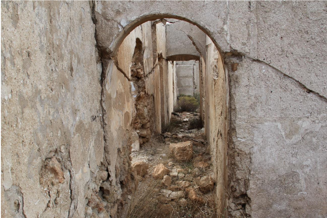
Fotografía 3.81: interior de una vivienda del poblado minero del Embarcadero. Destaca los materiales de fábrica empleados en estas construcciones y parte del interiorismo en obra (vanos interiores en arco y alacenas empotradas). Además, se aprecia el revestimiento (repellado, o enfoscado) de las paredes interiores. Captura del 4 de enero de 2011.
