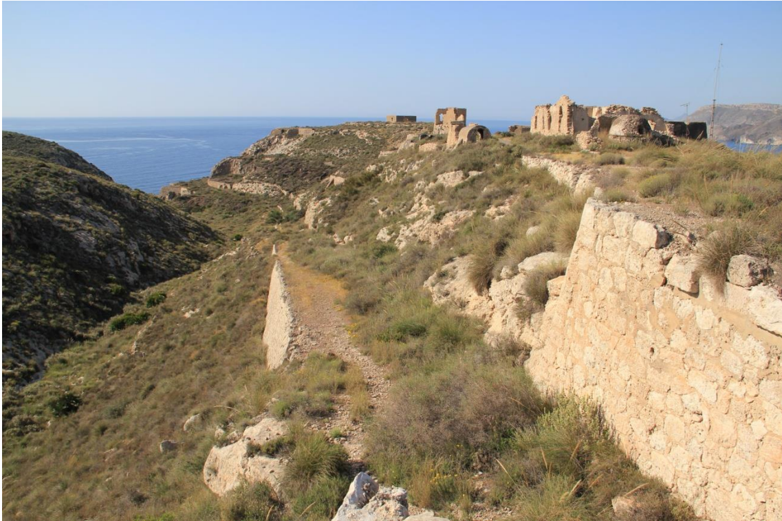
Fotografía 3.58: vista frontal del plano inclinado automotor del Cargadero, desde el norte. A la derecha, camino hacia el poblado minero y hacia la casa del amarrador de buques, y por donde circulaban las vagonetas con mineral, bocas de los silos subterráneos. Captura del 13 de abril de 2011.
