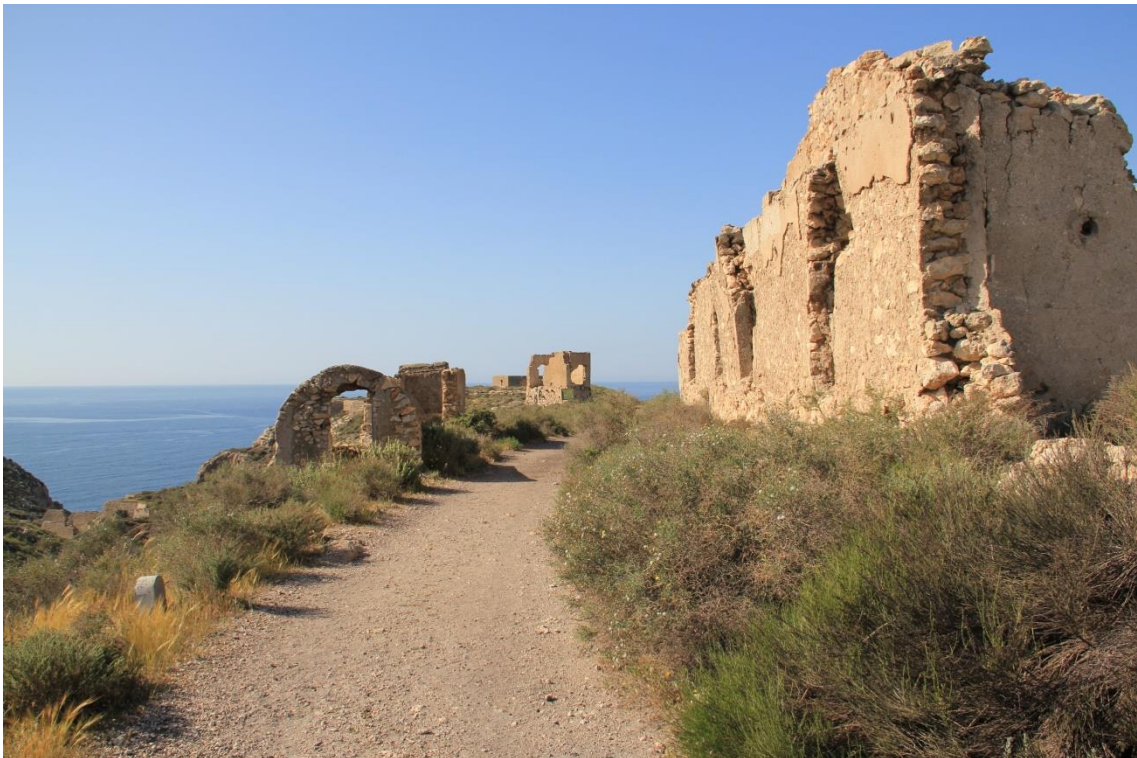
Fotografía 3.78: construcciones de almacenamiento (a la izquierda y en un plano intermedio), al borde del camino que corona la divisoria de aguas, desde el norte. Captura del 13 de abril de 2011.
