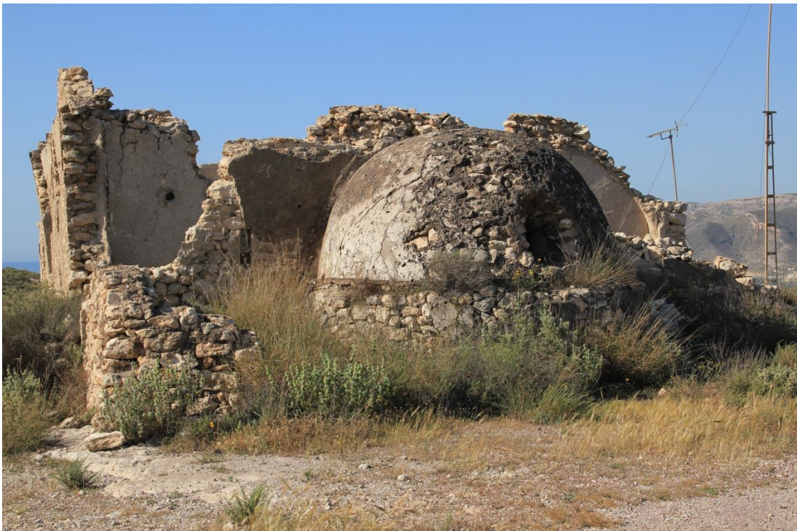
Fotografía 3.80: tahona de pan de base circular y con cúpula, anexa a las viviendas del poblado del Embarcadero. Se observa la solución edificatoria del horno, la ubicación y las características geométricas de su boca. Captura del 13 de abril de 2011.
