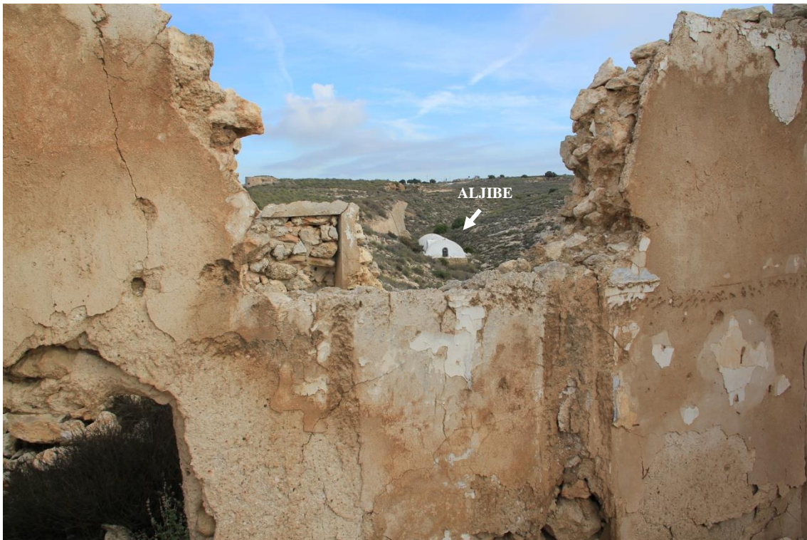
Fotografía 3.82: vistas hacia el norte, desde el interior de una de las casas del poblado minero del Embarcadero. En el fondo escénico próximo, toma protagonismo el aljibe. Captura del 4 de enero de 2011.
