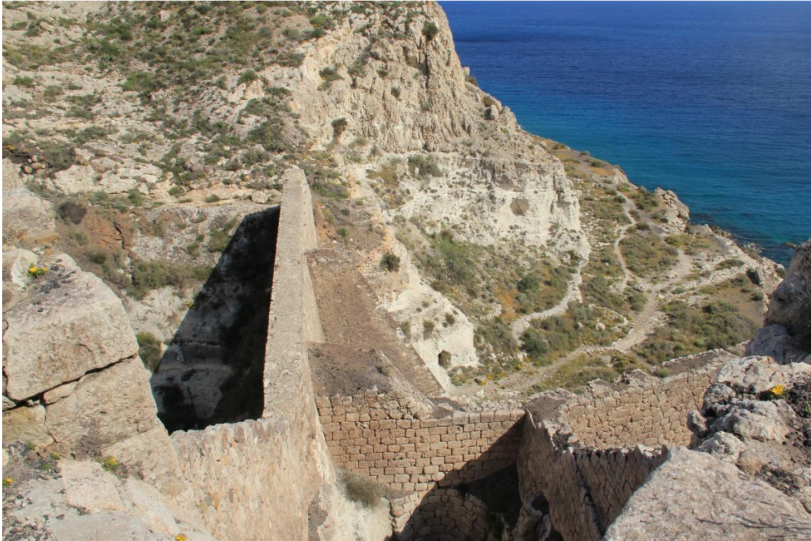
Fotografía 3.62: vista de las tolvas más próximas a la fachada marítima. Captura del 15 de abril de 2011.
