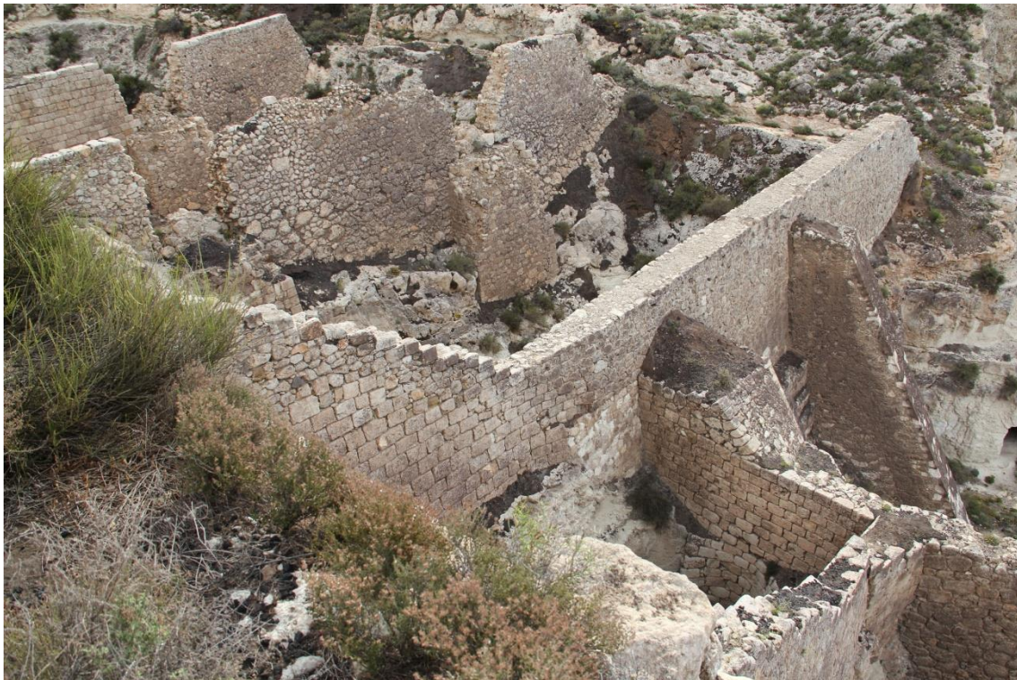
Fotografía 3.63: vista del interior de las tovas más cercanas a la fachada marítima, reforzadas con contrafuertes. Captura del 22 de abril de 2011.
