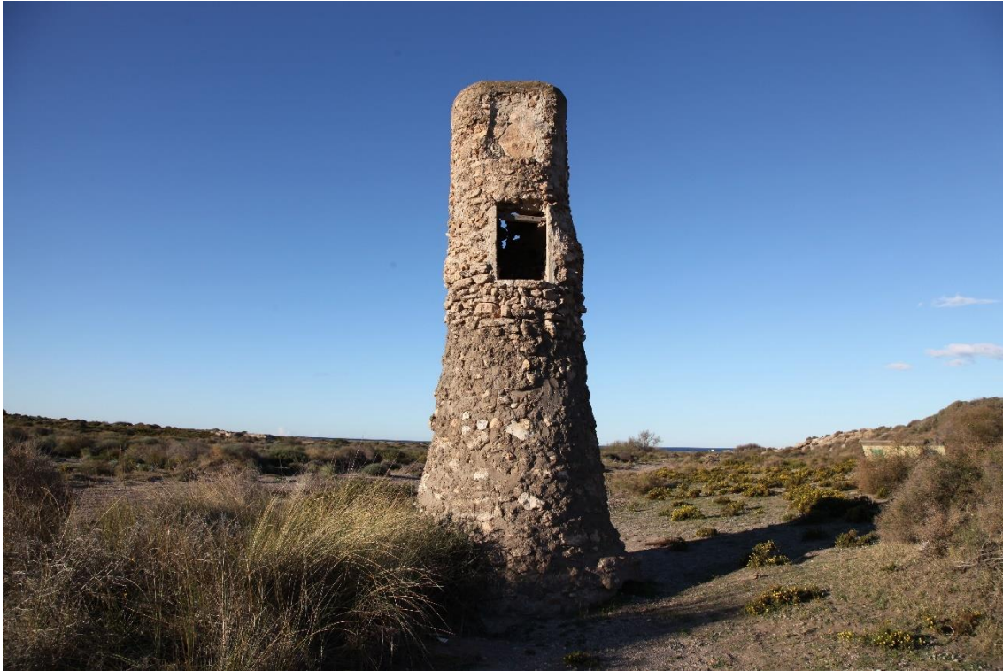
Fotografía 2.16: El Pocico con sus dos puertas más antiguas de explotación del agua en la parte superior de la construcción, cuando el nivel de base del perfil de equilibrio de la rambla estaba más alto respecto al techo del cuerpo de obra externo del pozo. Captura del 26 de marzo de 2018.
