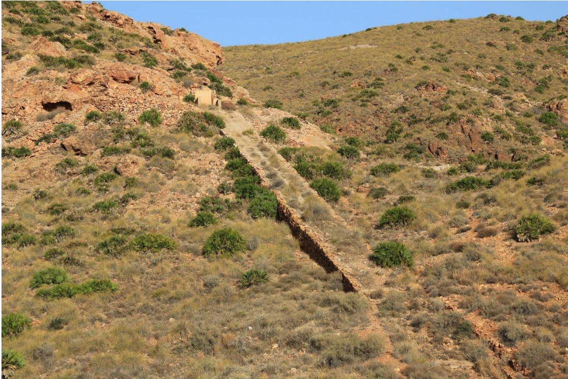
Fotografía 3.7: vista del plano inclinado (desde el Cortijo Cuarentena, desde un camino minero, en la cabecera del Valle de Rodalquilar), que se utilizaba para el transporte, en vagonetas, del mineral de plomo extraído en la Mina de Las Niñas. El entorno, la boca y la galería de acceso a la zona de explotación de esta mina se encuentran recogidas en las fotografías 3.3-3.5. Captura del 17 de agosto de 2011.
