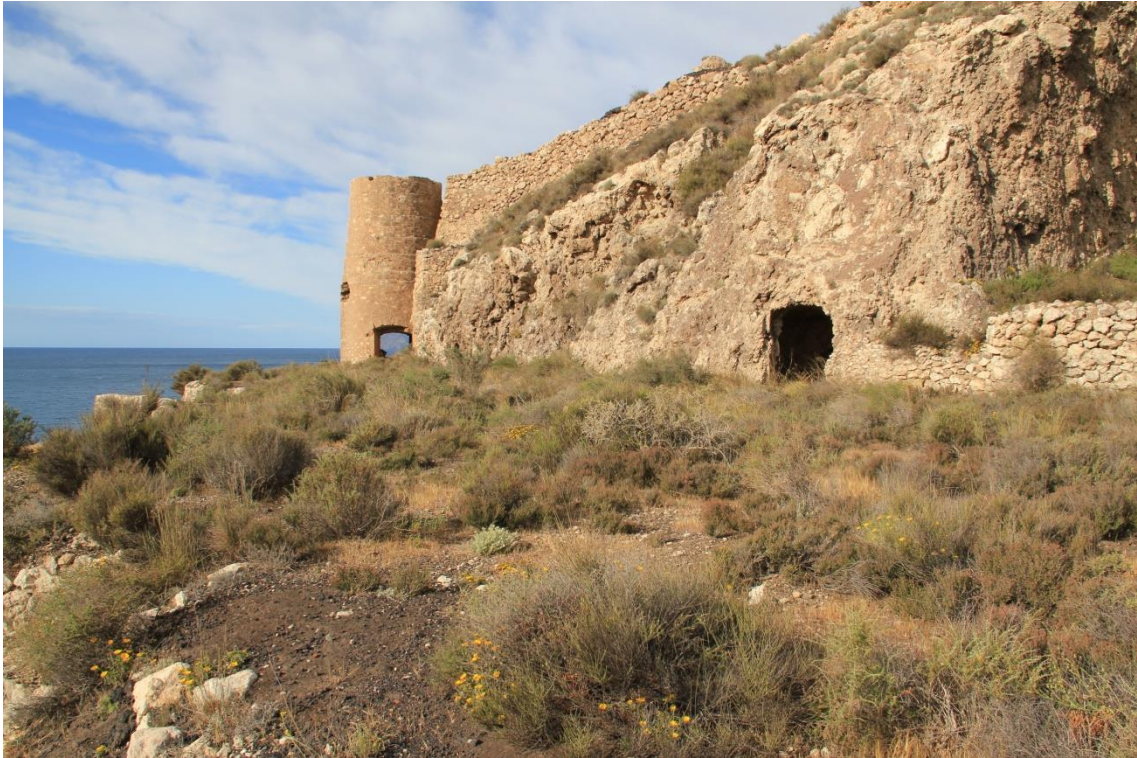
Fotografía 3.72: vista de la calera desde el norte, en las proximidades de las tolvas. Captura del 22 de abril de 2011.
