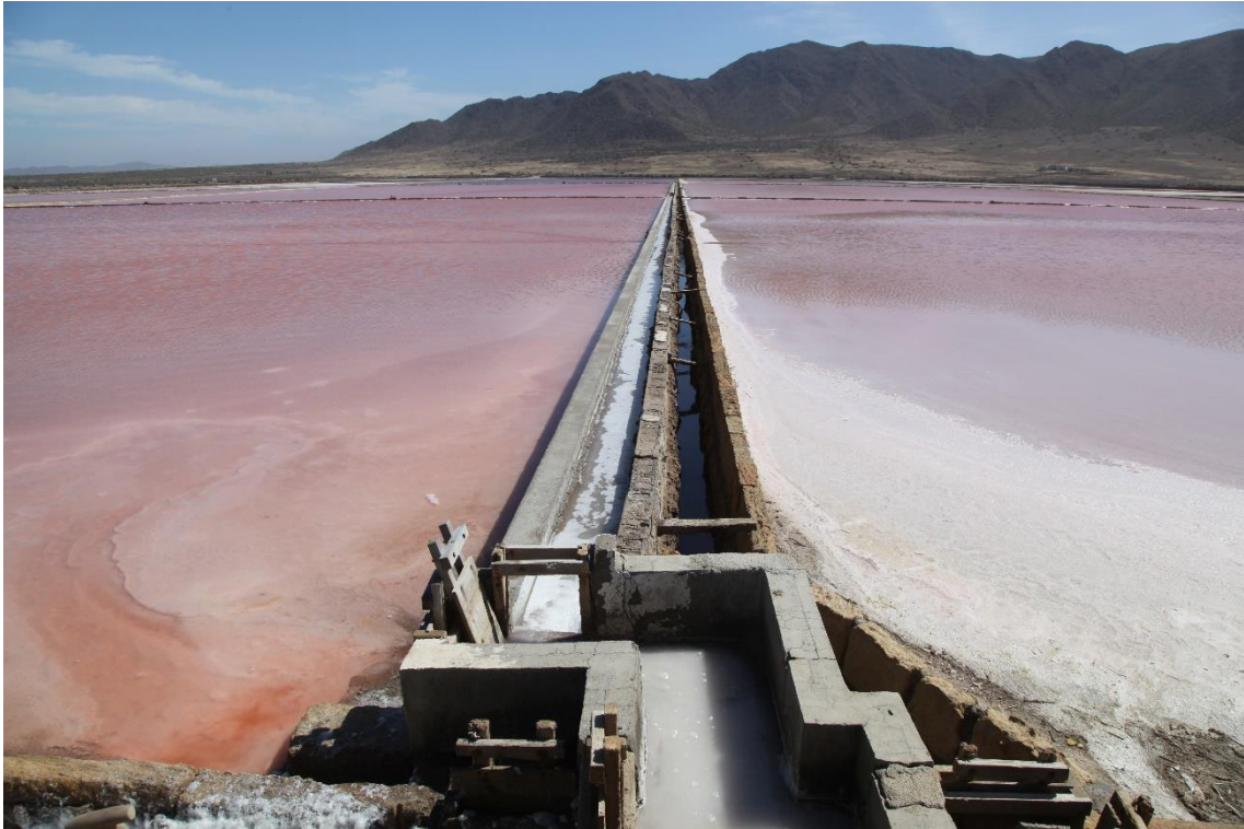
Fotografía 3.36: una de las conducciones de agua, con sus mecanismos de regulación, entre los estanques de Las Salinas de Cabo de Gata (Almería). Captura del 18 de abril de 2012.
