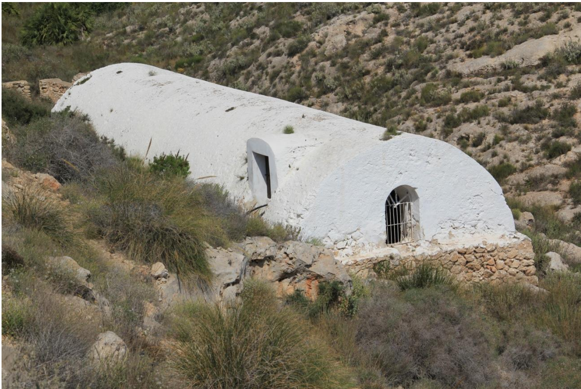
Fotografía 76: vista del lateral occidental, del exterior de la bóveda y de la cara frontal del aljibe, con su pared inferior externa a piedra vista y los elementos funcionales propios para la explotación del agua almacenada. En un aljibe estándar, la puerta lateral suele estar ausente y, en su lugar, se construyen un pilar, un lavadero y un abrevadero para el ganado. Captura del 15 de abril de 2011.
