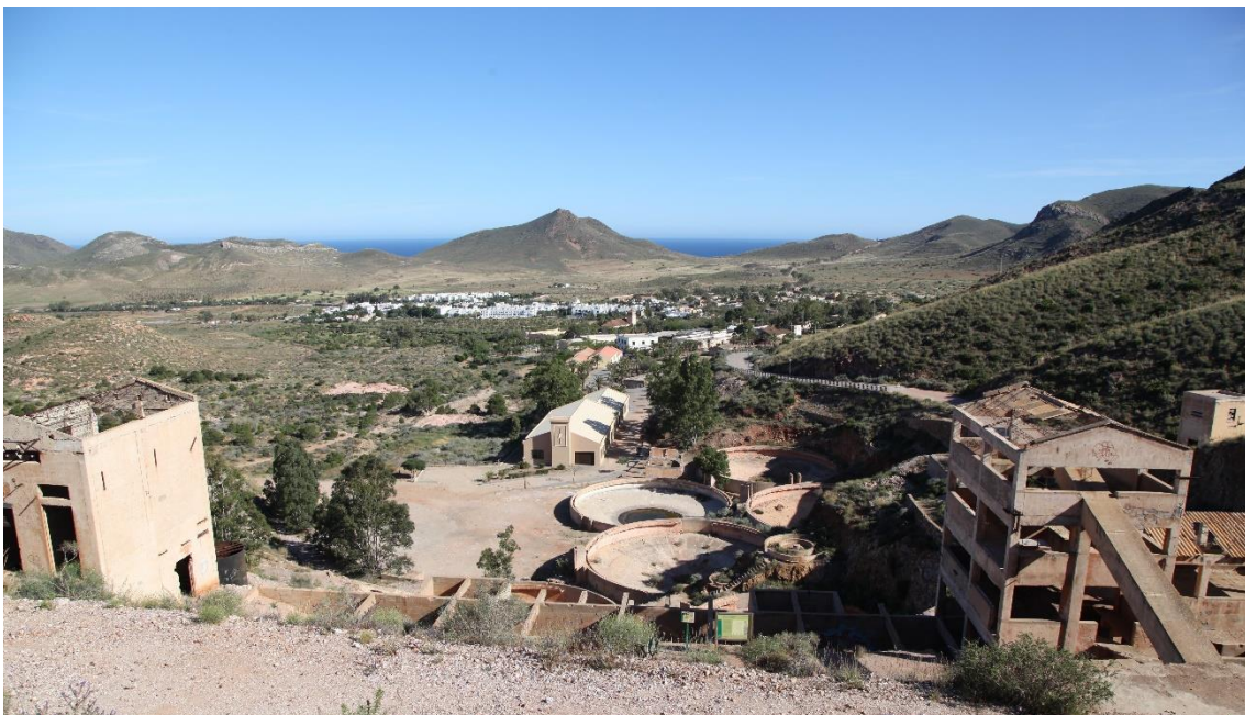
Fotografía 3.22: panorámica (en 2017) de una parte de las instalaciones de la Empresa ADARO, en relación con el procesado a la roca aurífera, mediante cianuro, para obtener el oro. En un primer plano y de derecha a izquierda, una de las torres trituradoras de la roca y tanques lavadores. En un plano intermedio próximo, se encuentra la nave de precipitado, afino, fundición y almacenaje de los lingotes de oro en una caja fuerte. En un plano intermedio lejano está la Población de Rodalquilar, que en estos momentos vive de la industria turística, básicamente de sol y playa . En el fondo escénico, se levantan los relieves que delimitan a una caldera volcánica por colapso. Captura del 2 de mayo de 2017.
