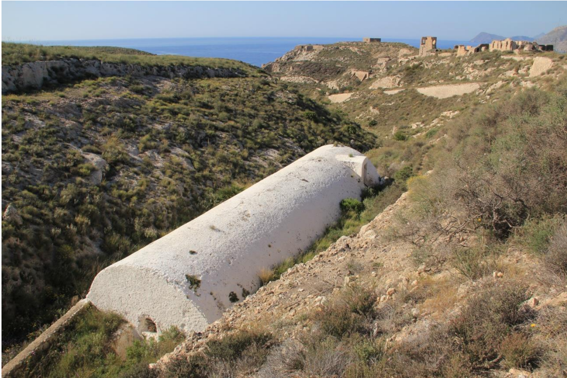
Fotografía 3.75: vista del aljibe desde el norte, con el pueblo minero como fondo escénico. Se observa su bóveda de cañón, su lateral occidental y su parte trasera, con las canalizaciones de captura, el reposadero (balsa de decantación) y la boquera para la recogida de las aguas superficiales desde el reposadero. En la mayoría de los casos, las canalizaciones de captación se encuentran sustituidas por acequias de captación. Captura del 13 de abril de 2011.
