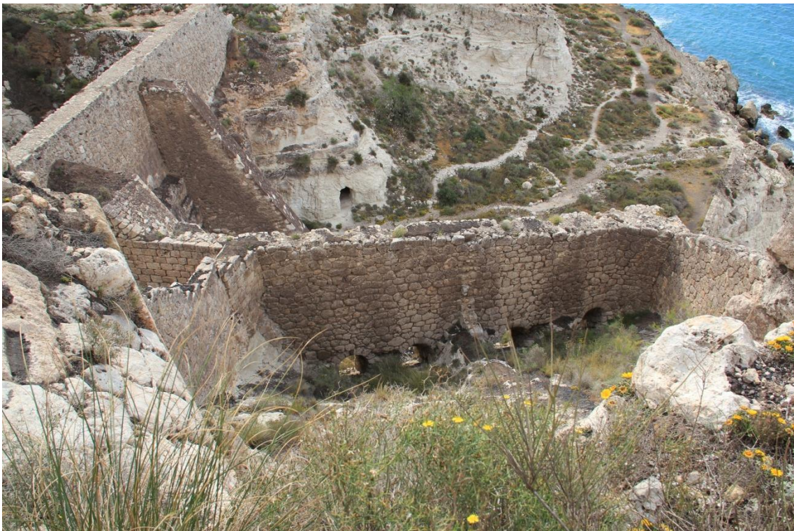
Fotografía 3.65: vista de las aberturas en arcos en la base de las tolvas más externas (más próximas al mar), por donde se sacaba el mineral para el Cargadero. Captura del 22 de abril de 2011.
