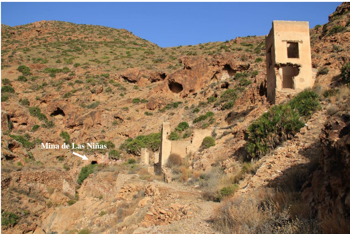
Fotografía 3.4: restos de las instalaciones empleadas en la explotación de plomo y plata en la Mina de Las Niñas. Dentro de esta mina, en 1883, se descubrió cuarzo aurífero. Al fondo, y a pie de camino, en plena curva, se encuentra la bocamina. Captura del 17 de agosto de 2011.
