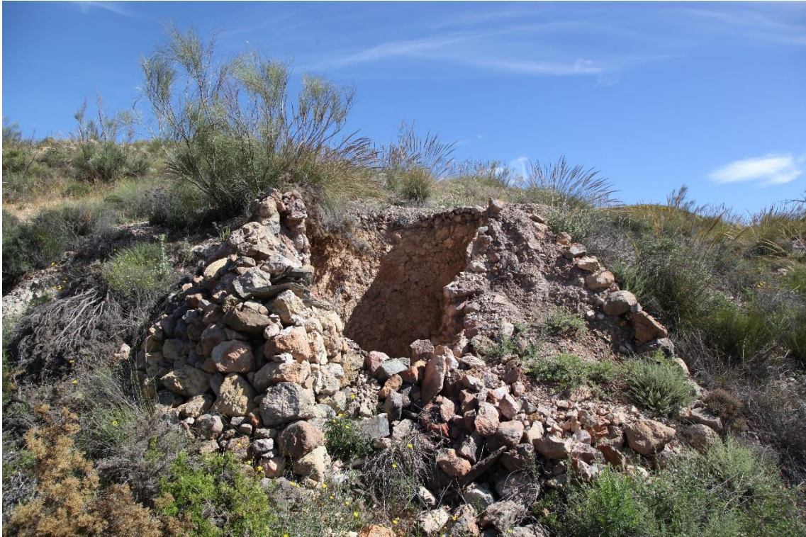
Fotografía 3.52: vista externa de la Calera de la Palmera, en la periferia de Huebro (Níjar). En el centro de la imagen, destaca el hueco de la puerta (actualmente obstruida en su base), y el techo abierto del horno de cal. Captura del 3 de mayo de 2017.
