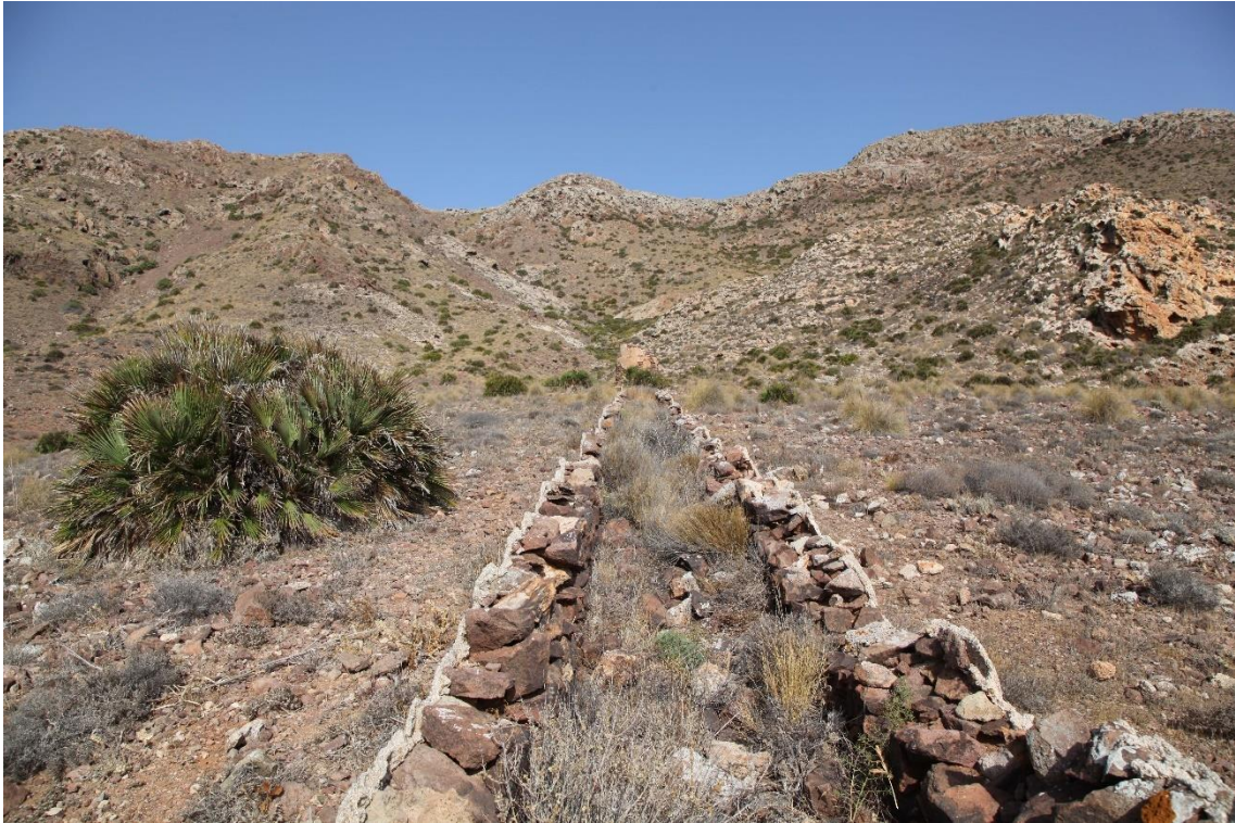
Fotografía 3.9: conducto de obra sobre el relieve, y cubierto con una bóveda (cimbra), para la conducción de los gases tóxicos de la fundición de La Fabriquilla hasta la chimenea a media ladera. La conducción tiene una amplitud (entre las paredes) alrededor de un metro, y recorre unos 800 m. Al fondo de la conducción, se observa la chimenea. Captura del 15 de agosto de 2012.
