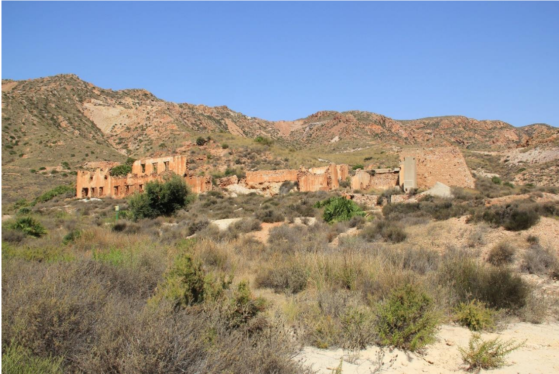
Fotografía 3.21: panorámica de los edificios que albergaban las instalaciones diversas y oficinas de las Minas de Abellán. Captura del 17 de agosto de 2011.
