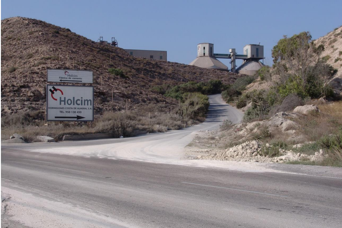
Fotografía 3.48: entrada secundaria a la Cementera Holcim, en el Polígono Industrial de Carboneras. Captura del 4 de agosto de 2009.
