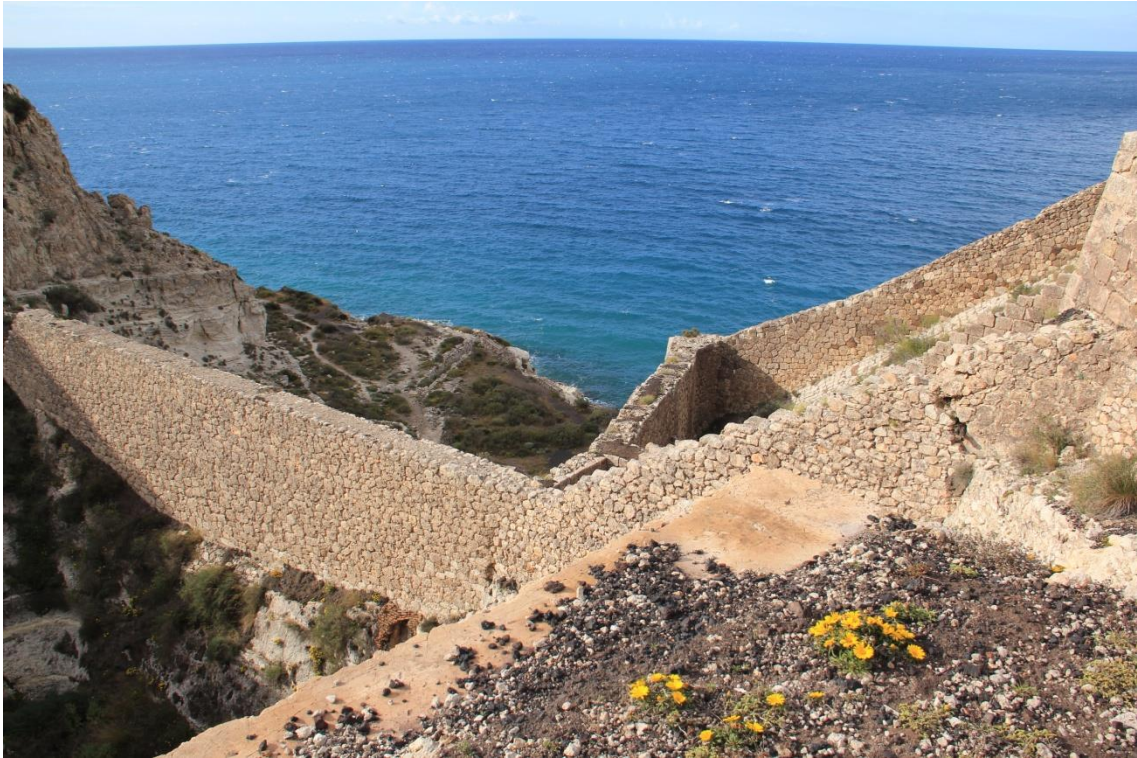
Fotografía 3.64: detalle de la fábrica de los muros de las tolvas más cercanas a la fachada marítima. Captura del 22 de abril de 2011.
