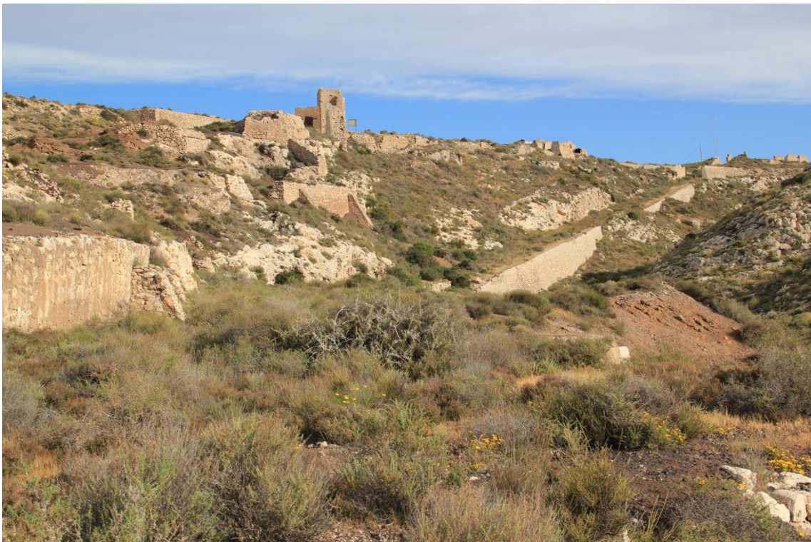
Fotografía 3.59: vista lateral del plano inclinado automotor del Cargadero, desde el sur. El fondo escénico se identifica con la divisoria de aguas, que soporta al poblado minero Captura del 22 de abril de 2011.
