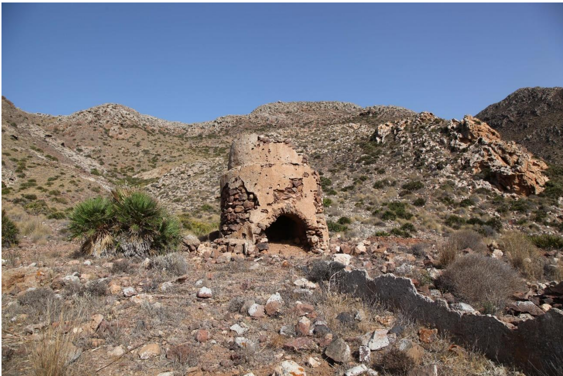
Fotografía 3.10: chimenea a media ladera del Cerro de La Testa para la evacuación de los gases tóxicos que se producían durante la fundición de plomo de La Fabriquilla (hoy totalmente desmantelada). Captura del 15 de agosto de 2012.
