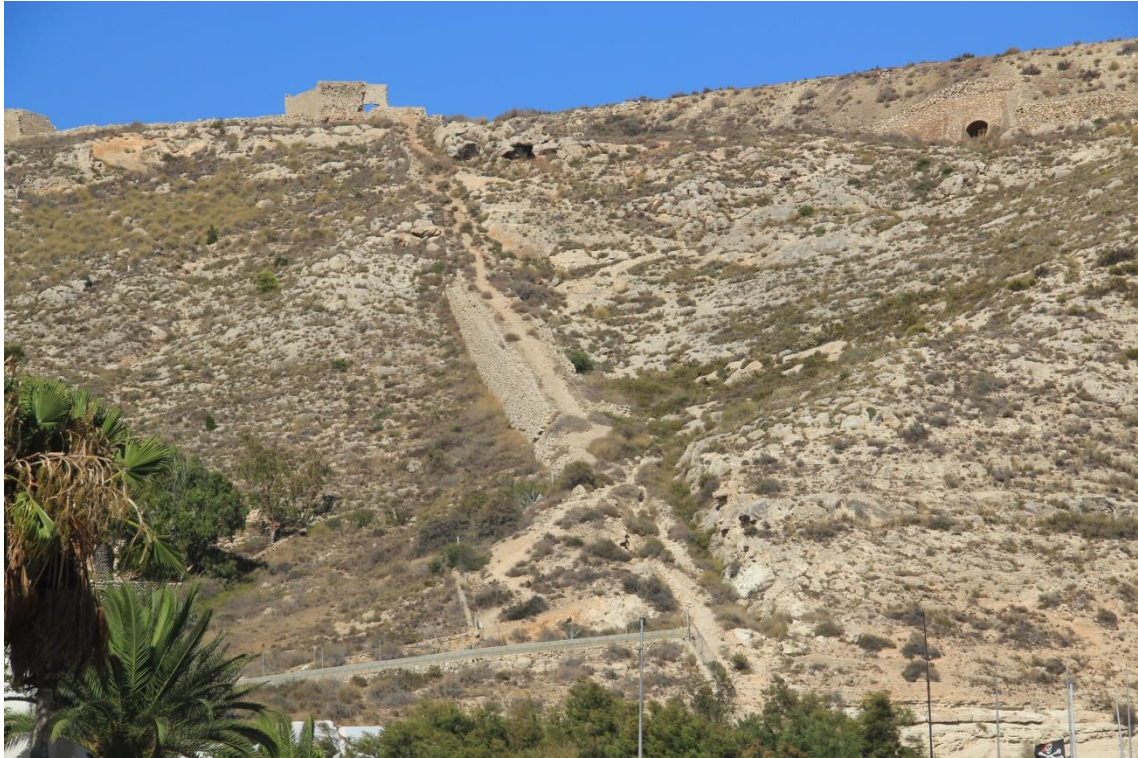
Fotografía 3.89: plano inclinado a motor para subir los insumos diversos a la divisoria de aguas entre Playa Amarga y el Barranco de Calarena, en un primer plano. Captura del 6 de agosto de 2011.
