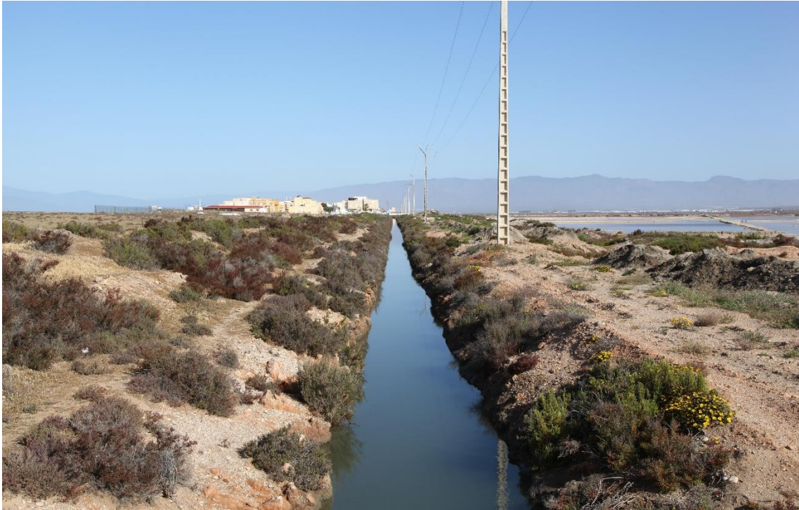
Fotografía 3.40: canal que lleva agua de mar a los estanques de Las Salinas del Cabo de Gata, desde las piscinas de alimentación a pie de los acantilados entre La Fabriquilla y El Faro. Captura del 14 de agosto de 2011.
