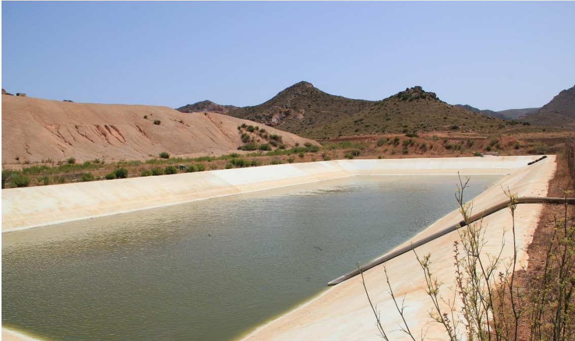
Fotografía 3.13: vista, en un primer plano, de la balsa que recogía el lixiviado de la escombrera ubicada en un segundo plano. La balsa y la escombrera pertenecen a la Empresa aurífera St. Joe Transacción Inc. (1989-1990). Captura del 17 de agosto de 2011.
