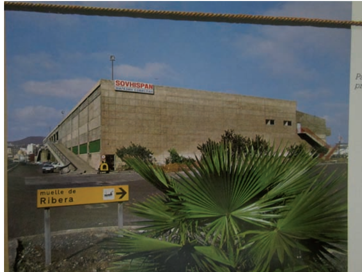
Foto 3. Edificio de "Sovhispán" en las Palmas de Gran Canaria, Muelle de Ribera. Aprox. 1983.
