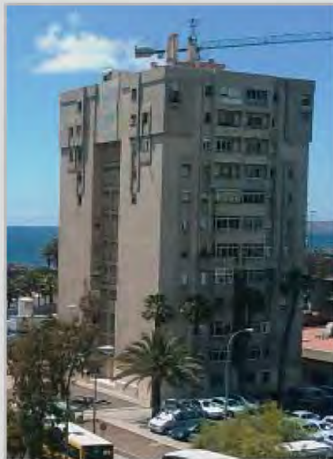
Imagen del estado actual de las torres
