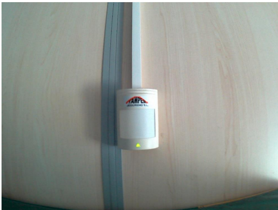
IMAGEN 30. SENSORES DE MOVIMIENTO. FUENTE: EDICIÓN PROPIA.
