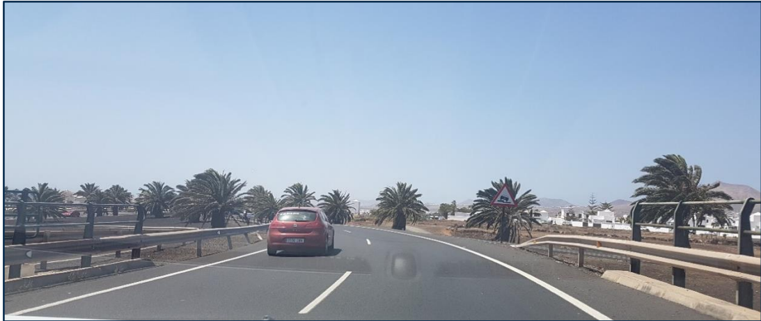
Imagen 20. Enlace de carreta LZ-2 a LZ3. Escalón lateral.
