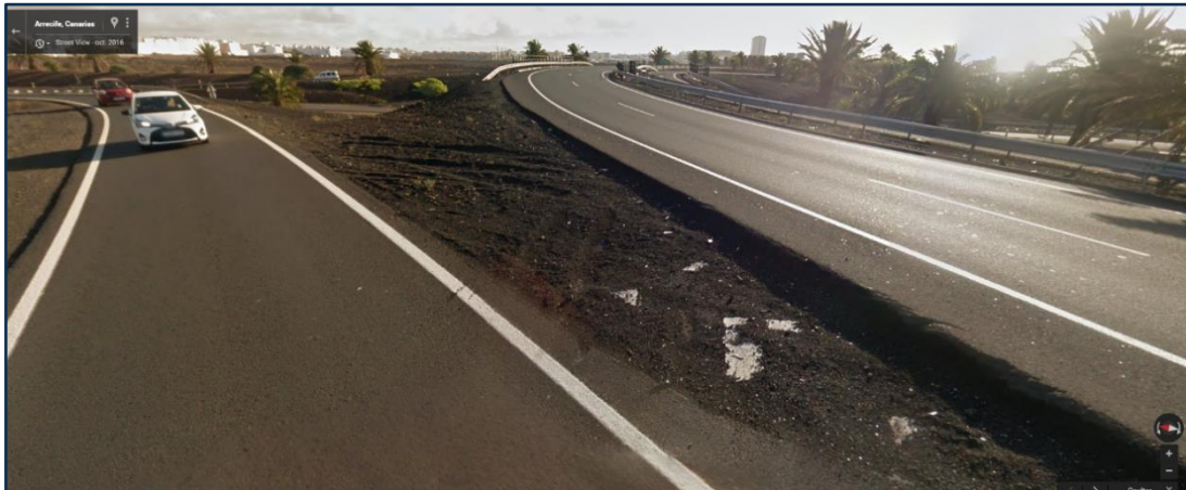
Imagen 21. Enlace de carreta LZ-2 a LZ3. Escalón lateral, vista inversa.
