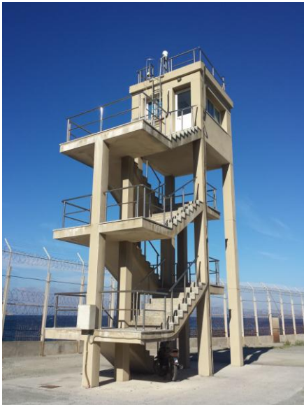
Imagen 10. Torreta de vigilancia o grada.
