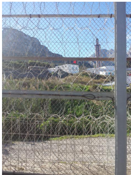
Imagen 17. Sensor por contacto (cable negro pegado a la valla) y concertinas en el lado marroquí.
