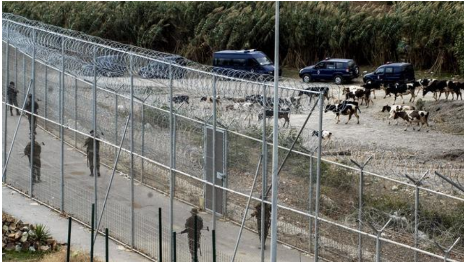
Imagen 4. Valla de Ceuta cuando sólo había sido elevada a los 6 metros una de ellas.
