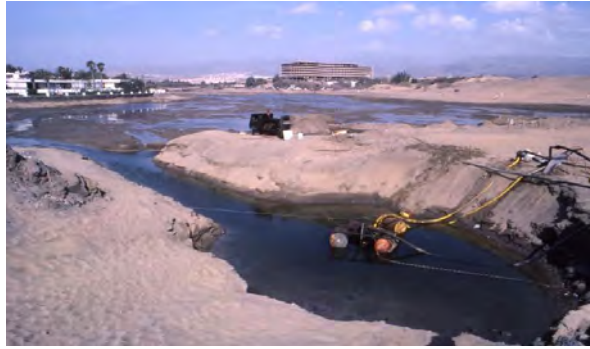
Fotografía 75: Panorámica de las intervenciones en La Charca de Maspalomas, en 1987, para el saneamiento de sus arenas del fondo y de los laterales
