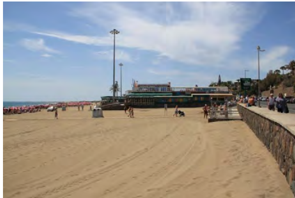
Fotografía 79: Vista lateral del Centro Comercial Anexo II
