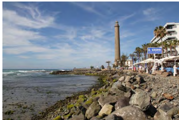
Fotografía 90: Vista del muro de 2010 hacia el Oeste, después de los temporales del S-W de finales de 2010 y de enero y febrero de 2011
