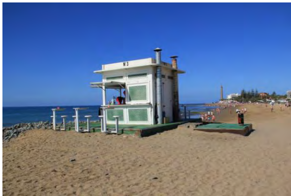
Fotografía 105: Vista lateral del kiosco n° 3 de la Playa de Maspalomas, con el anexo de servicios soterrado
