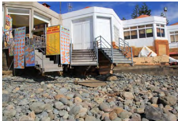
Fotografía 95: Afectación de la erosión de los temporales del S - W a la fachada marítima del Centro Comercial Oasis
