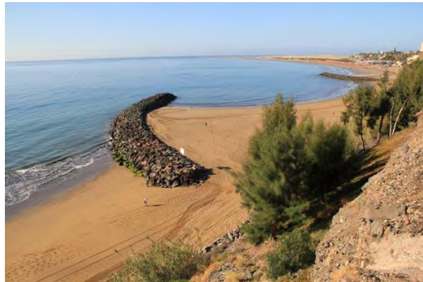
Fotografía 88: Vista del captador intermedio de El Veril, con las aportaciones externas desde Las Canteras
