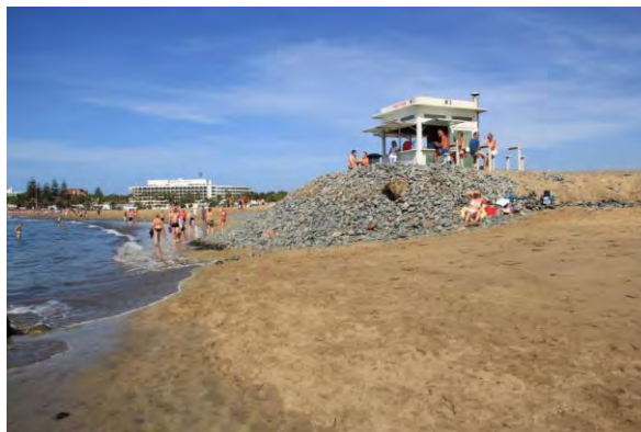
Fotografía 106: Vista lateral del kiosco nº 3 de la Playa de Maspalomas, con su base frontal (hacia el mar) protegida por una peculiar escollera de cantos
