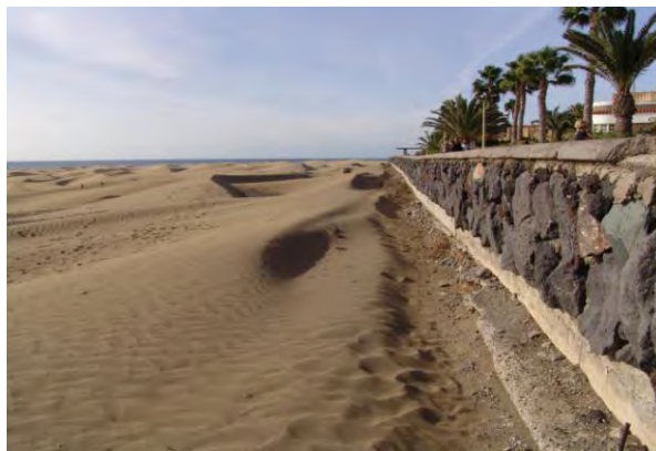
Fotografía 71: Incipiente pasillo entre el Campo de Dunas y el Paseo Sahara Beach Club, por el efecto pantalla
