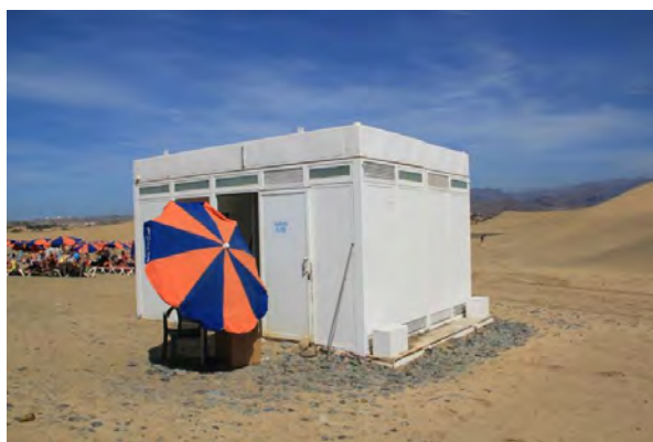
Fotografía 111: Vista de las instalaciones de aseos situadas en las cercanías del kiosco nº 7 de la Playa de Maspalomas
