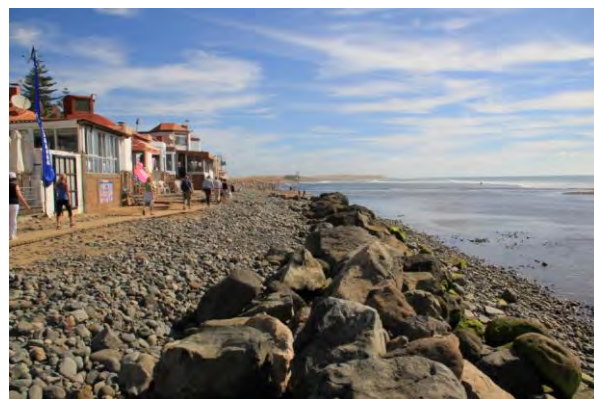
Fotografía 91: Vista del muro de 2010 hacia el Este, después de los temporales del S-W de finales de 2010 y de enero y febrero de 2011
