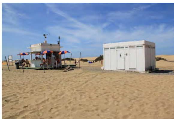
Fotografía 112: Vista de las instalaciones de aseos situadas en las cercanías del kiosco nº 8 de la Playa de El Inglés
