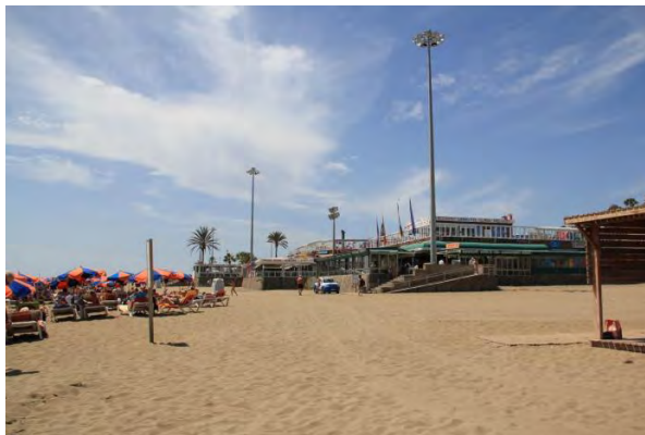
Fotografía 80: Vista frontal del Centro Comercial Anexo II
