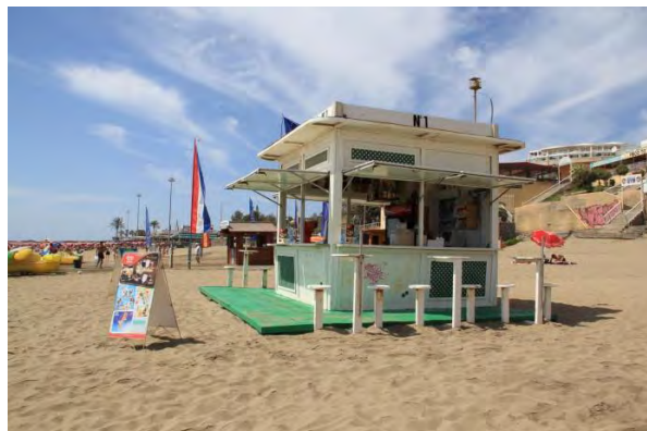
Fotografía 104: Vista lateral del kiosco n° 1 de la Playa de El Inglés
