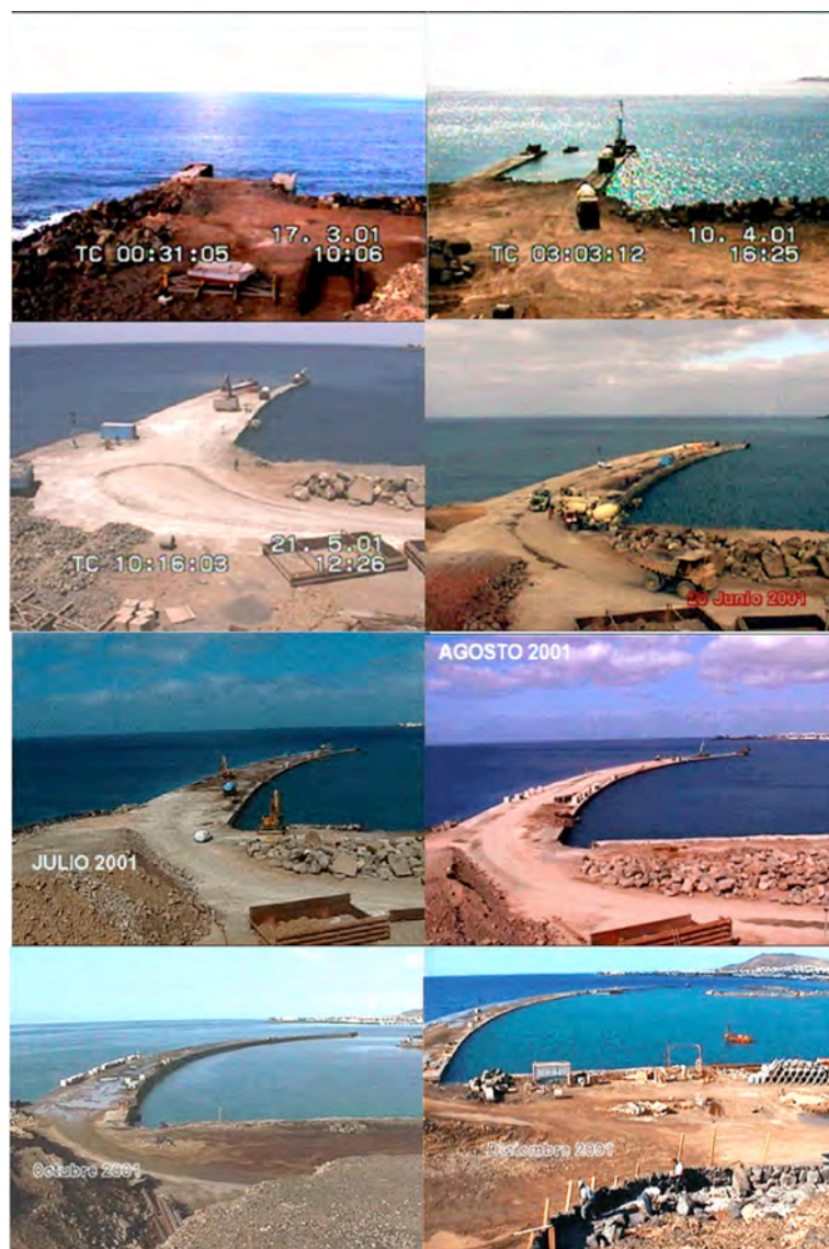
Figura V.2. Proceso de inicial de la construcción de Marina Rubicón, Lanzarote.
