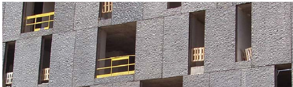
Edificio Inakasa. Ejemplo del uso de paneles prefabricados de hormigón armado
