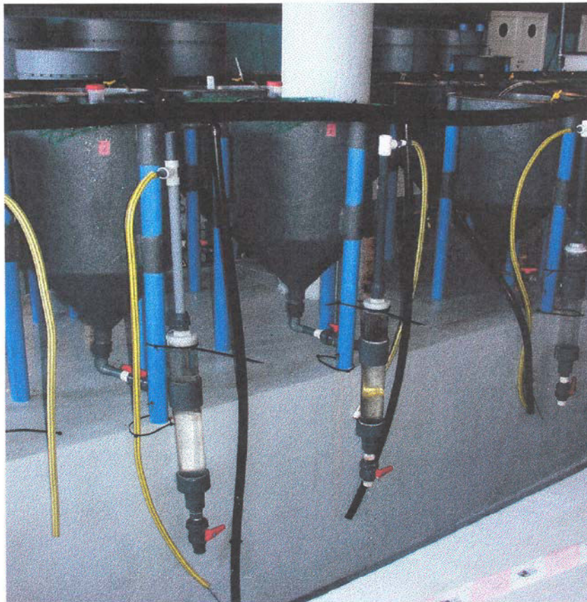
Figura 16.- Detalle de las columnas de decantación en los tanques para la recogida de heces.
