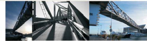
Puente peatonal sobre el puerto de Sant Adrià, Forum de Barcelona.
