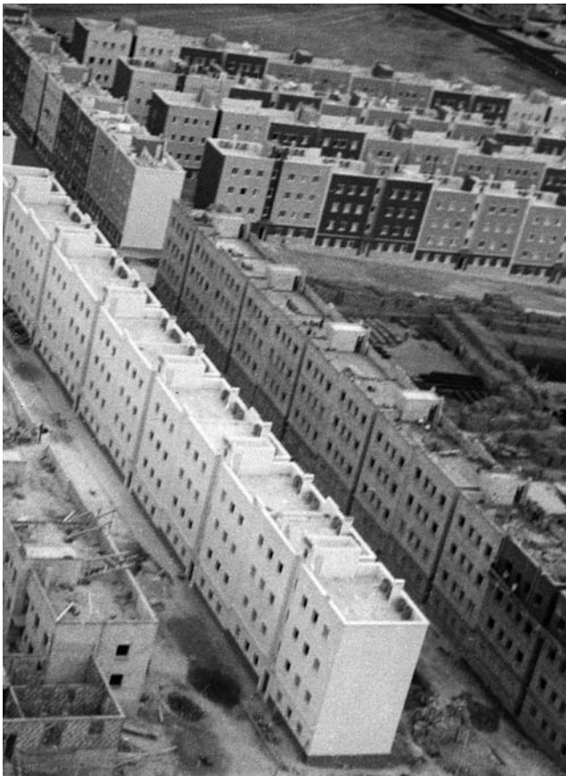
Construcción del barrio de Schamann en Las Palmas de Gran Canaria (FEDAC).
