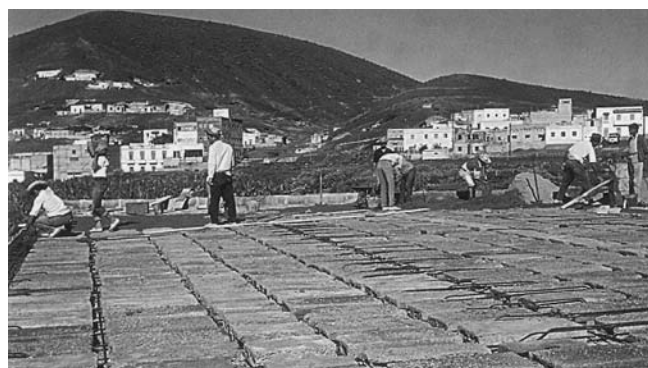
Construcción de las infraestructuras turísticas de Los Cristianos, en el sur de Tenerife, en los años sesenta.
