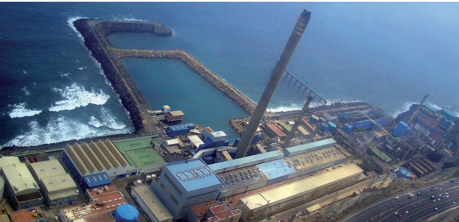
El uso de la tecnología de la desalación resultó esencial para resolver los problemas de abastecimiento de agua potable en las islas orientales (prensa digital).
