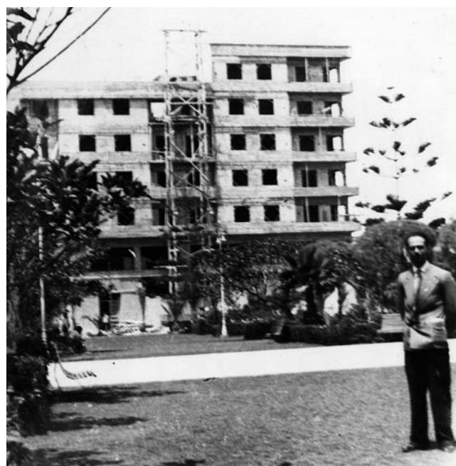
Construcción del Hotel Parque, en Las Palmas de Gran Canaria (FEDAC).
