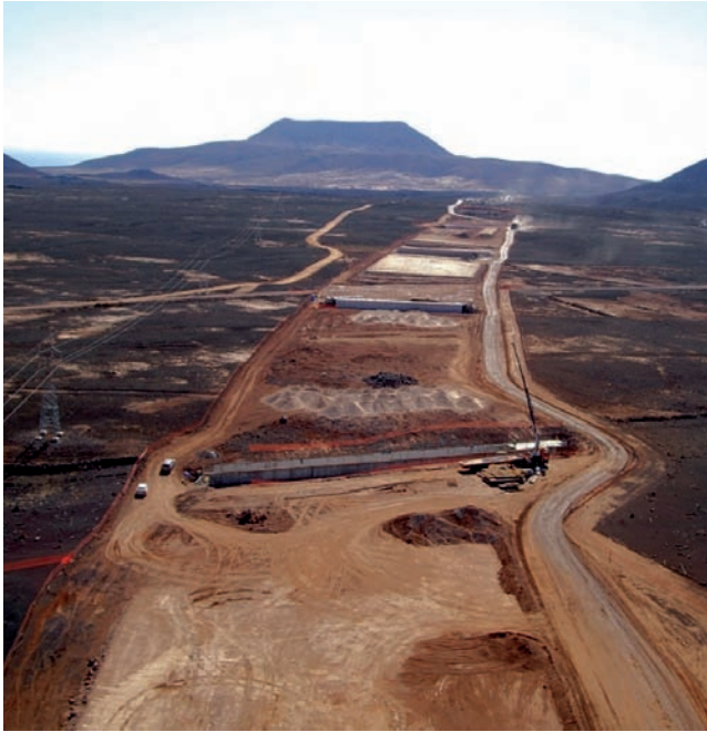
Obra para la construcción de uno de los tramos del Eje Insular de Fuerteventura, autovía que atravesará la isla del norte a sur (Gobierno de Canarias).
