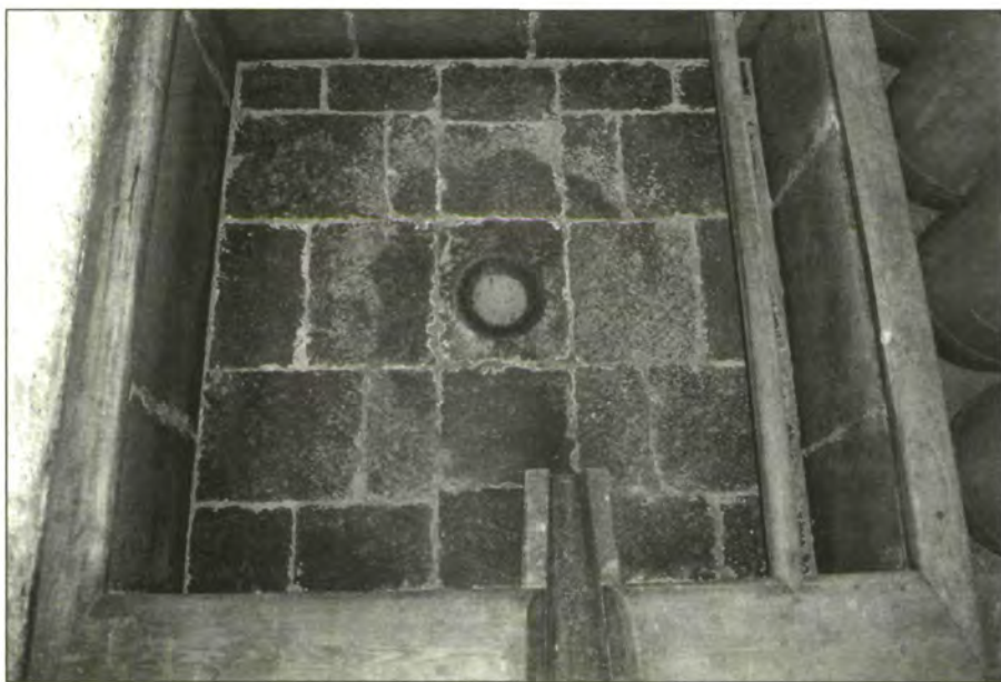
Lagareta mostrando el fondo con el cuenco, vinca, guarderas y traviesa para apoyar los tercios.
